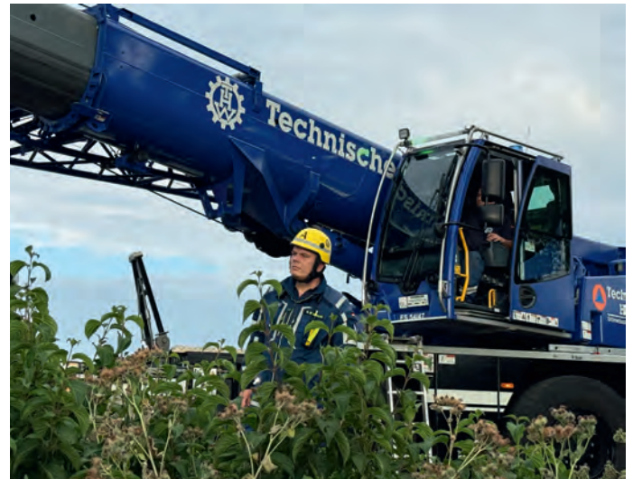
Zentimeterarbeit unter Aufsicht. Der Maschinist des Mobilkrans hat für die Bergung den Ausleger sehr flach gestellt, um gut an einem Baum vorbeizukommen. Der Freisinger Zugführer als Einsatzleiter vor Ort überwacht die Hubarbeiten.
