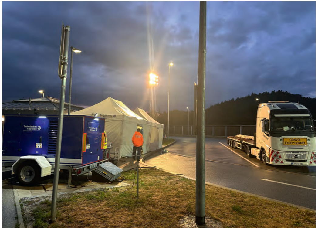
Die vorhandene Verkehrsbeleuchtung des Rastplatzes wurde durch Lichtmastanhänger des Ortsverbandes Wörth ergänzt.
