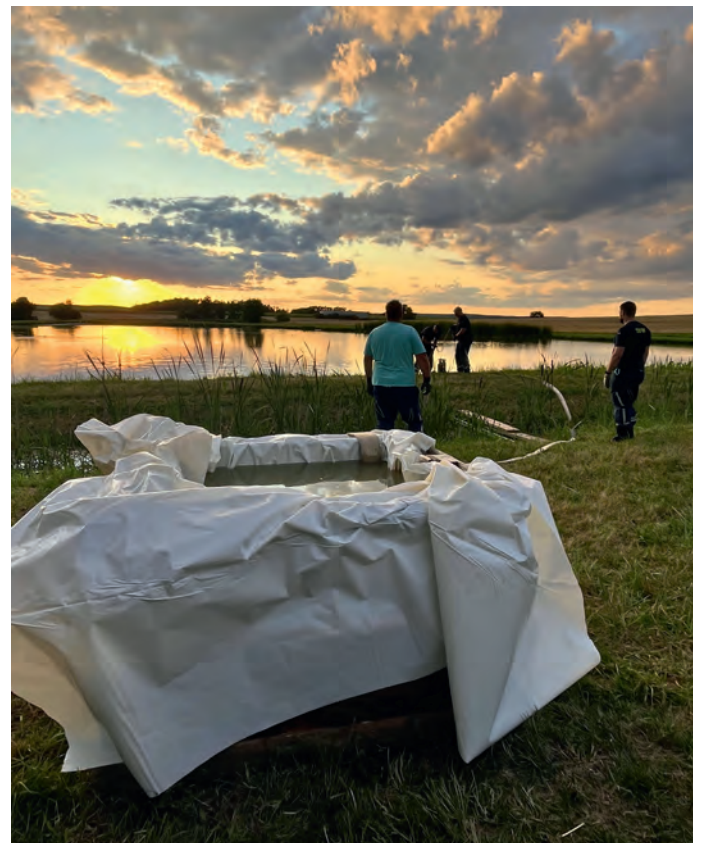
Aus Paletten und Plane entsteht ein Behelfswasserbehälter, der bei längeren Förderstrecken als Zwischenspeicher dienen kann.
