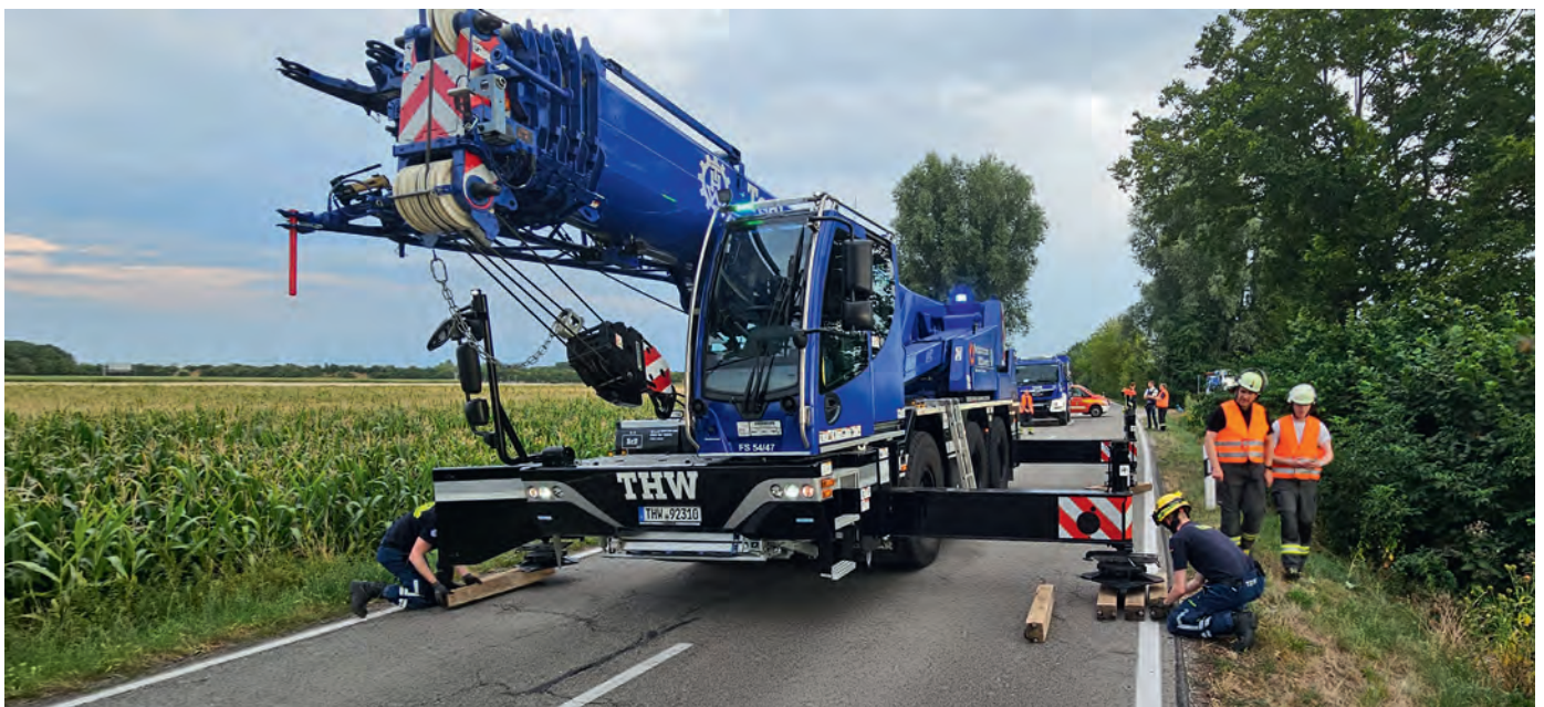
Vorbereiten des Krans zur Bergung des Fahrzeugs. Zur Druckverteilung müssen die Stützen des Krans mit Holz unterbaut werden. Dies ist insbesondere wichtig, wenn die Stützen sehr knapp am Fahrbahnrand ausgefahren werden müssen
