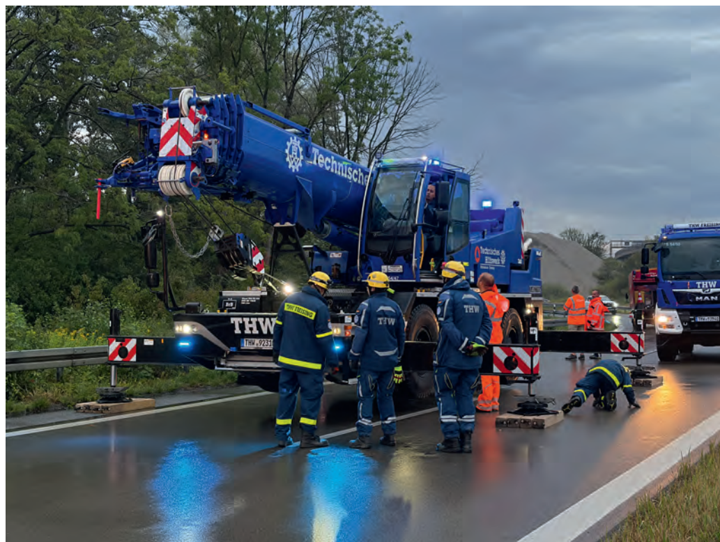
Aufrüsten des 50-to-Mobilkrans Liebherr LTC1050-3.1 an der Einsatzstelle Neufahrner Kreuz auf der Ableitung von der A9 auf die A92 Richtung Stuttgart
