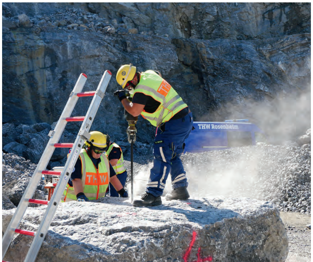
Die Sprenglöcher werden gebohrt
