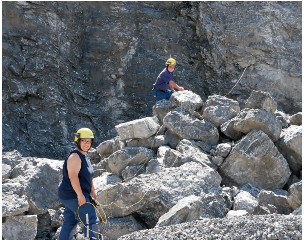
Verlegen der Zündleitungen
