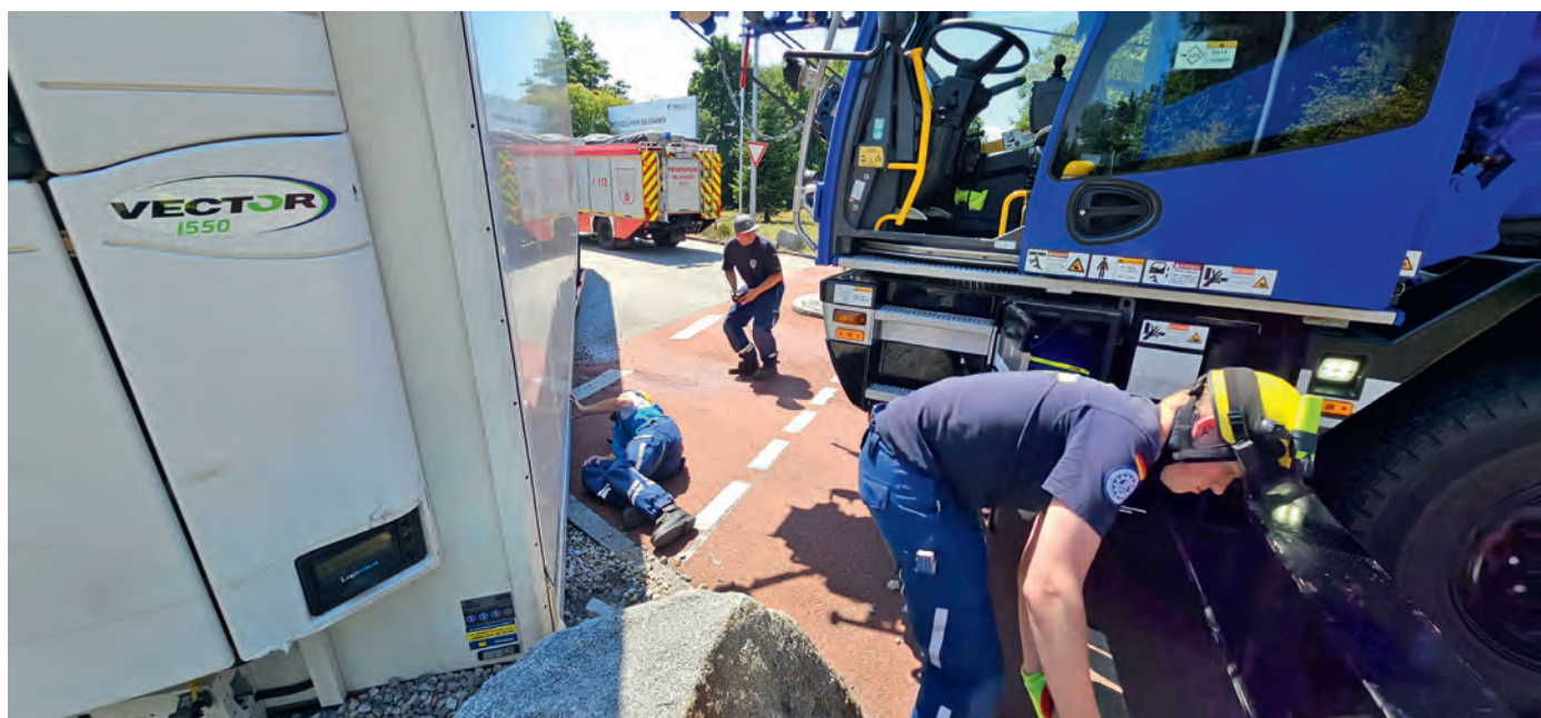
Aufrüsten des Krans. Während der Gruppenführer den Auflieger nach geeigneten Auflagepunkten absucht, rangiert der Maschinist den Kran mit der Fernbedienung zentimetergenau in die Endposition während eine Einsatzkraft die Unterleghölzer für die Stützen des Krans einbaut.
