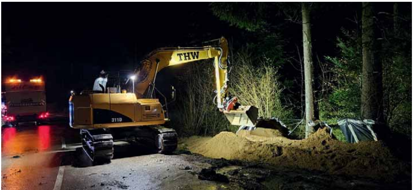
Der Kettenbagger des THW Freising beim Ausbaggern des Sandes
