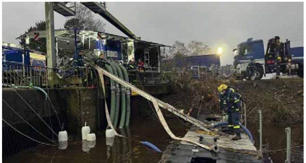
Durch die Verwendung von modulare Schwimmelementen wird die Gefahr von Aus- und Unterspülungen während der Pumparbeiten eingedämmt.
