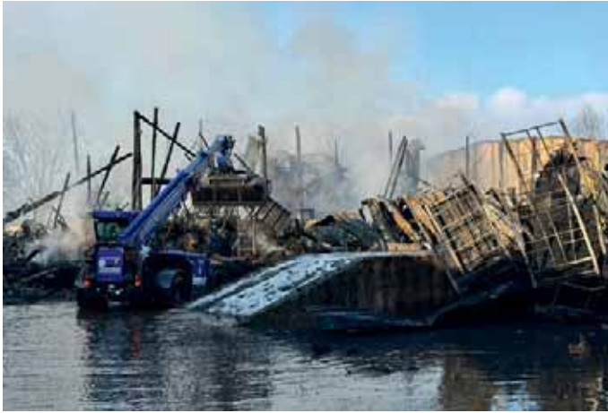
Beginn der Räumung des Brandobjekts mittels Bergeräumgerät.
