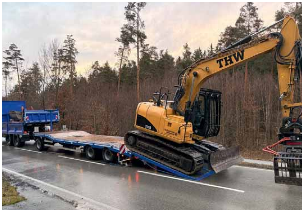
Der Kettenbagger fährt vom Tieflader des Ortsverbands, mit dem er transportiert wird.
