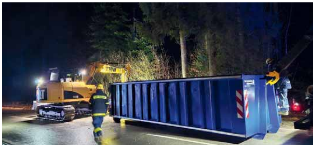
Die große Schuttmulde des Ortsverbands wird vom Bagger mit dem Sand befüllt.
