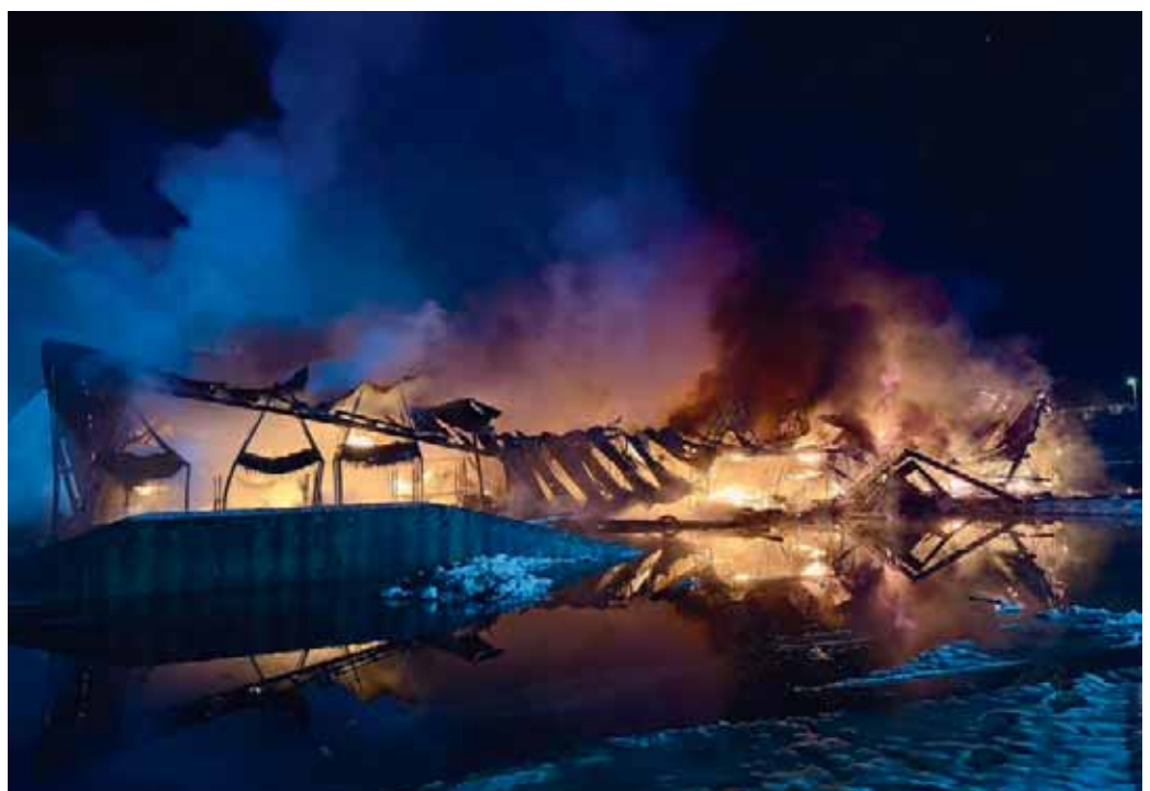
Circa eineinhalb Stunden nach der ersten Erkundung – Teileinsturz des Brandobjekts.
