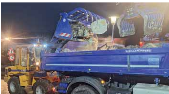
Mit dem Chamer Radlader und dem Bagger des OV Roding wird die Unglücksstelle beraumt, absturzgefährdete Trümmer beseitigt...
