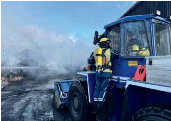
Absprache des weiteren Vorgehens zur Räumung des Schadensobjekts mittels Radlader.
