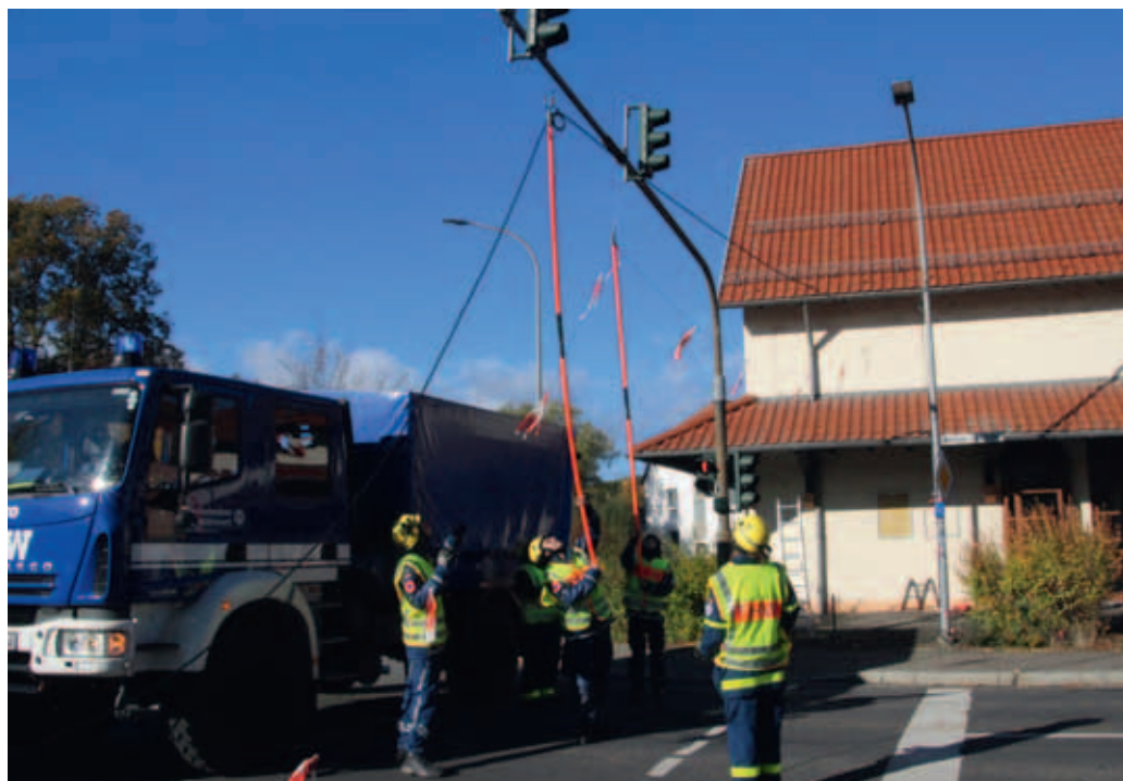
Knapp 7400 m Feldkabel und Anschlusskabel wurden quer durch Mellrichstadt verlegt, um alle wichtigen Einrichtungen miteinander zu verbinden.
