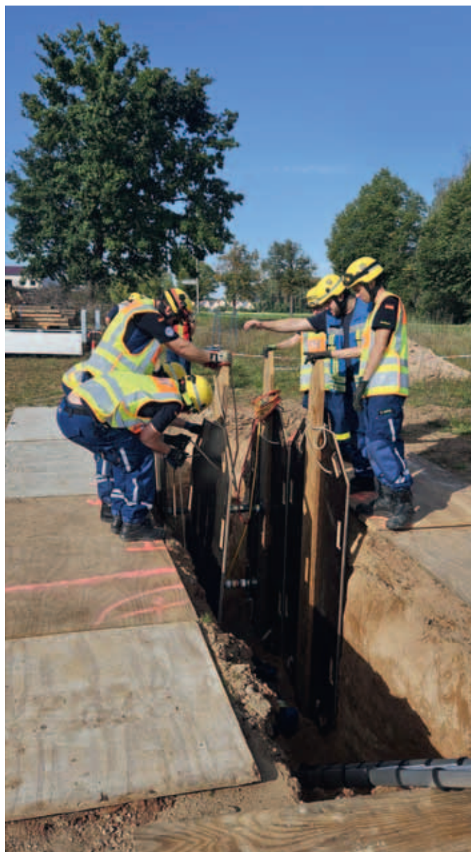
Die Ausbildungsgruppe beim Sichern des Übungsschachts mittels Spundwänden und Stützen
