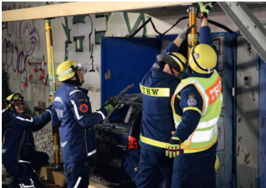
Die THW-Helfer Adrian Redder, Tobias Unger, Maximilian Hörrmann und Daniel Lang sichern einen Balkon mit Paratech-Stützen und Holzbohlen, bevor das Gebäude gefahrlos betreten werden kann.
