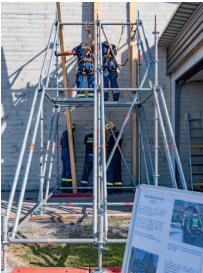
Die Helfer hatten auch eine Wandabstützung aus dem Einsatzgerüst-System (EGS) gebaut, zu dem die Besucher sich informieren konnten.
