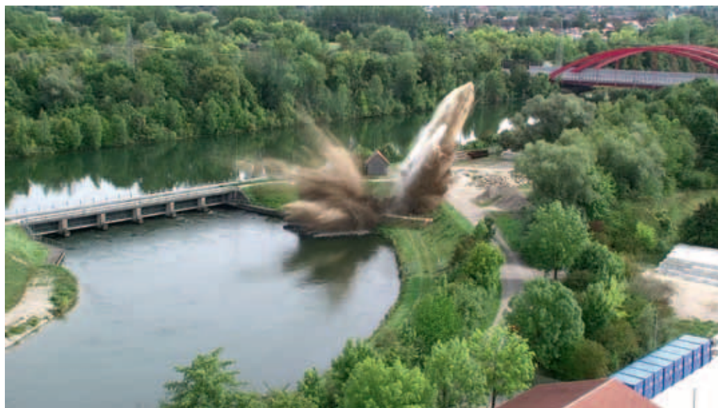
Erstmals gezielte Sprengung eines Musterdeichs in Gersthofen durch die Fachgruppe Sprengen THW Augsburg.
