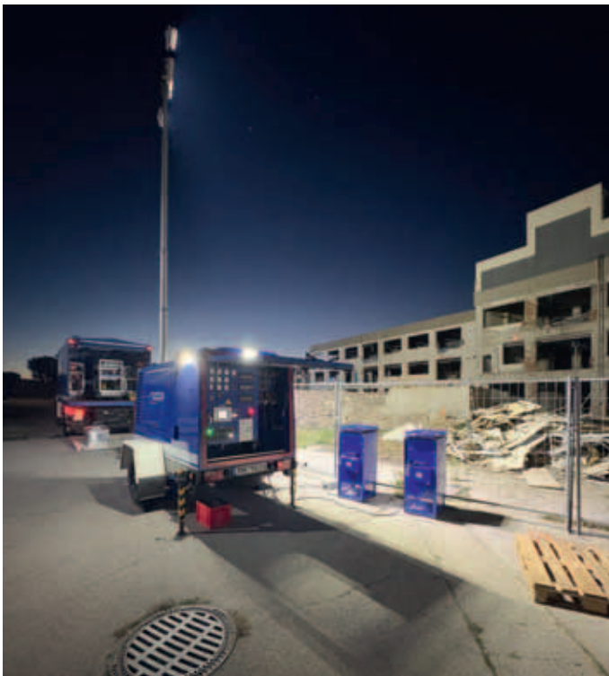
Zur Ausleuchtung des Areals diente der Lichtmast der 50-kVA-NEA der Fachgruppe N.
