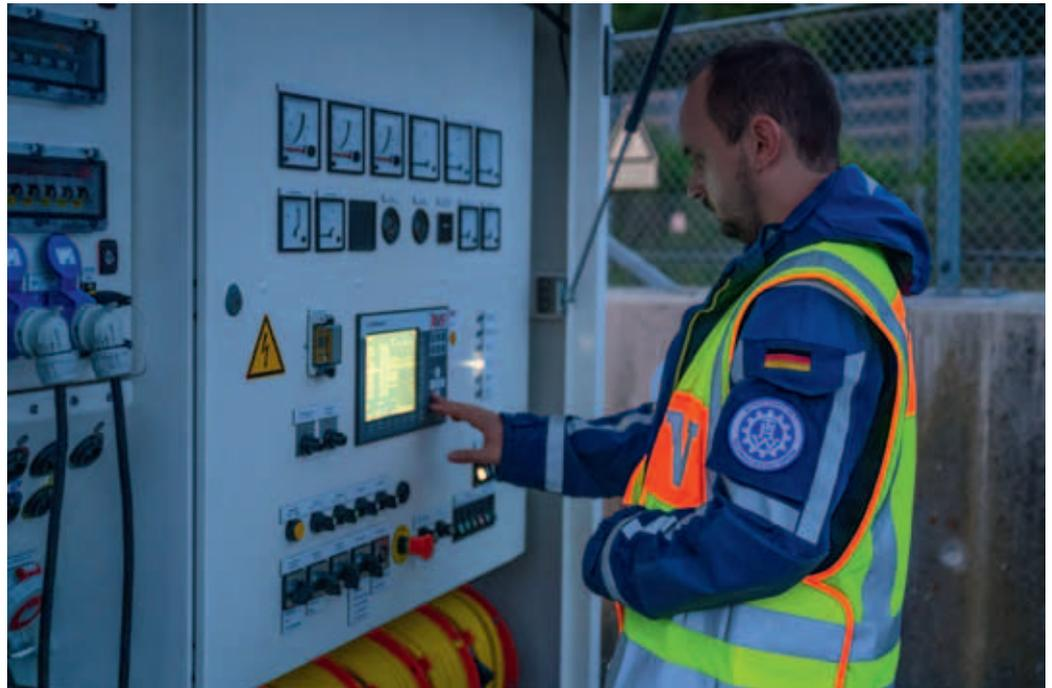
Im Herbst 2023 investierte der Landkreis Roth (Mittelfranken) in drei werksneue Notstromaggregate mit einer maximalen Leistung von je 100 kVA. Jedes Aggregat ist mit einem Lichtmast versehen, deren bewegliche LED-Elemente für eine blendfreie Ausleuchtung von Einsatzstellen sorgen. Die Bedienung der Aggregate erfolgt durch speziell ausgebildete und geschulte THW-Einsatzkräfte.
