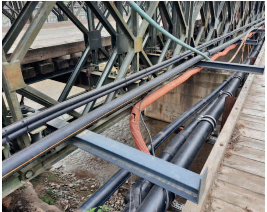
*In Slowenien werden Ver- und Entsorgungsleitungen gerne unter Brücken über Gewässer geführt. Mit dem an der Brücke angebrachten Kragarmen werden die neuen Leitungen über das Gewässer geführt.*
