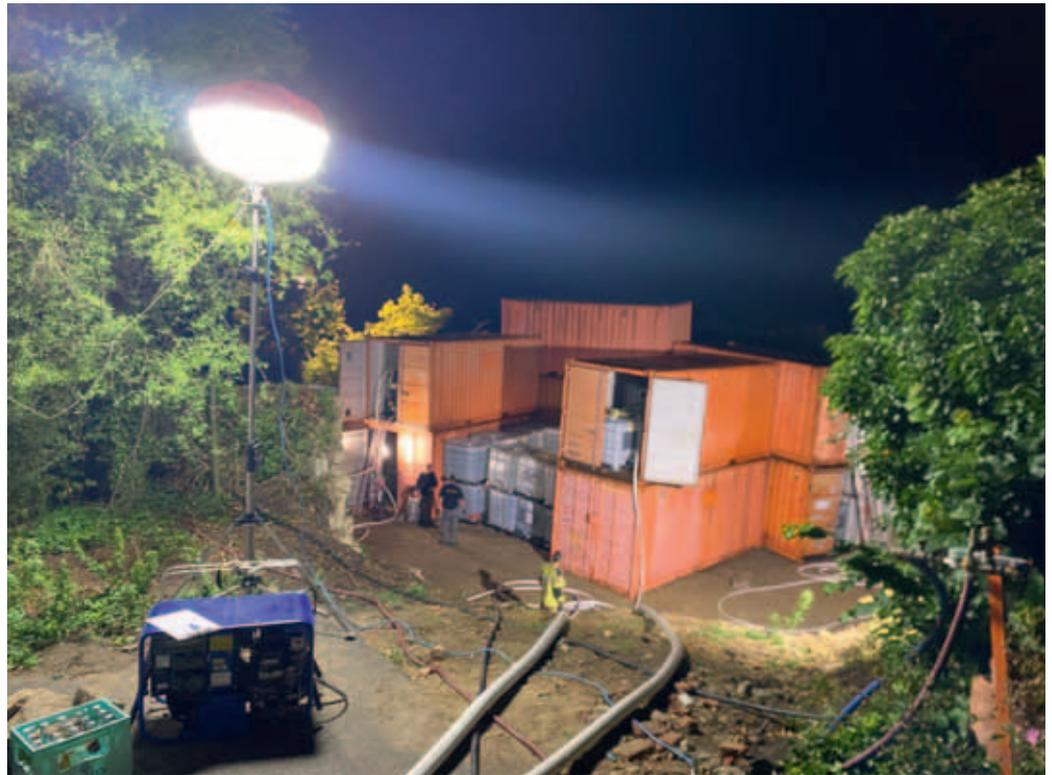
Mit Wasser gefüllte IBC-Container sollten die Wirkung der Bombe im schlimmsten Fall minimieren.
