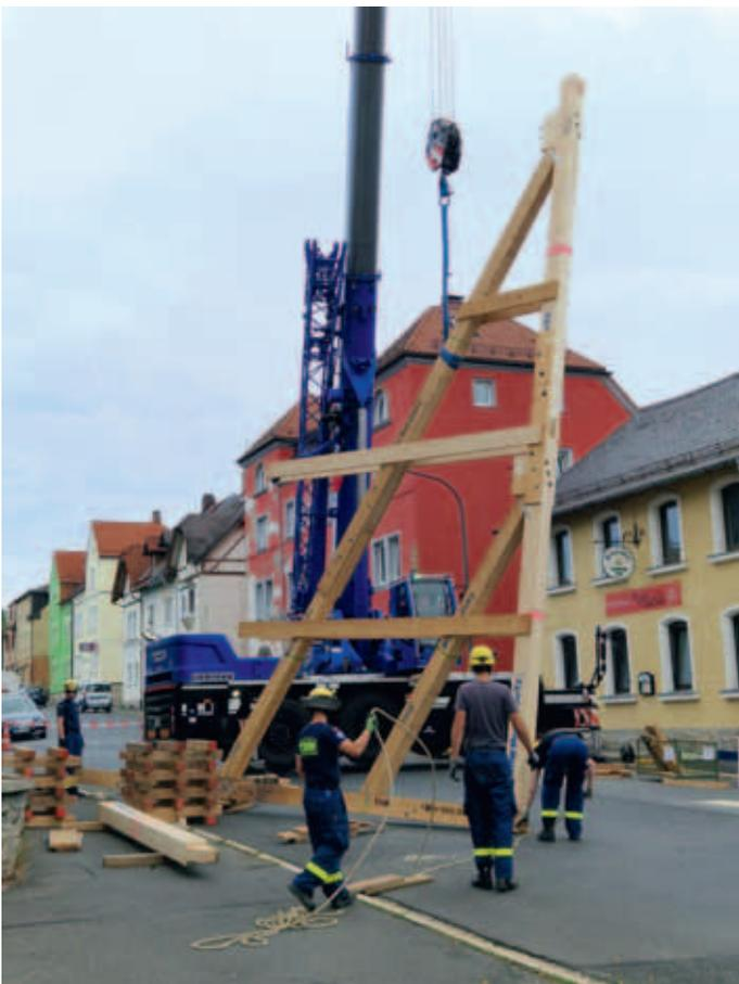
Einheben der fertig montierten Strebstütze an die Gebäudefassade mit dem Freisinger 50 to. Mobilkran - siehe auch Foto auf der nächsten Seite.
