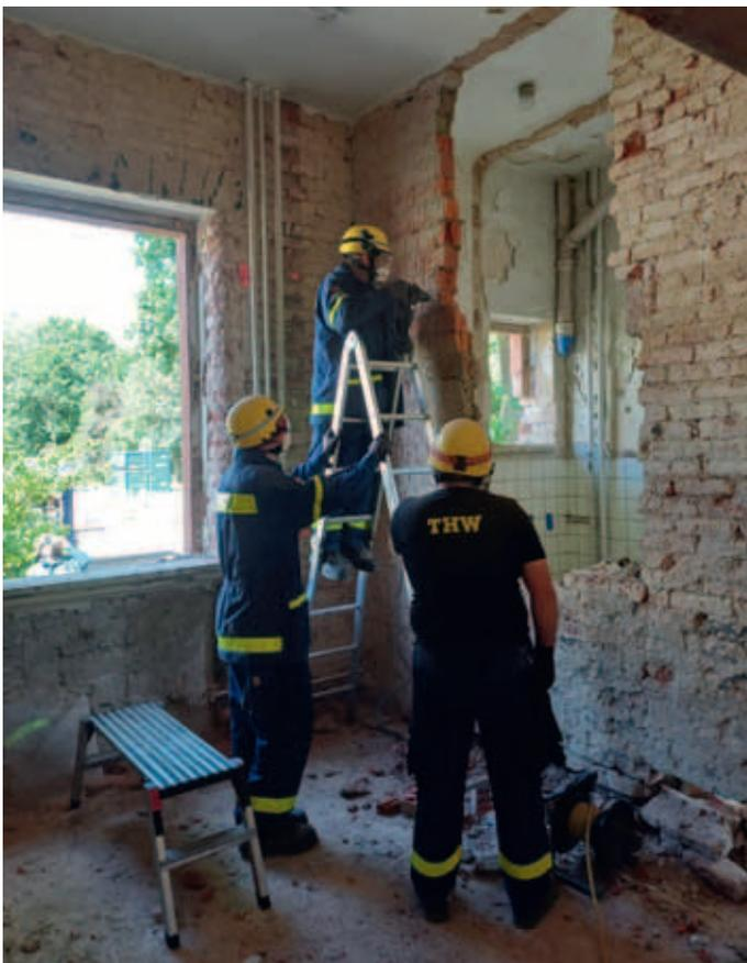
Nichttragende Innenwände entfernten die THWler des OV Coburg vor der Sprengung.
