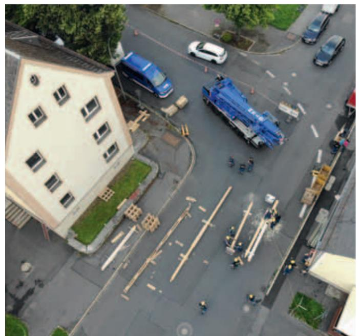
*Der Zuschnitt von Komponenten des Abstützensystems Holz durch THW-Einsatzkräfte entscheidet mit über die Stabilität.*
