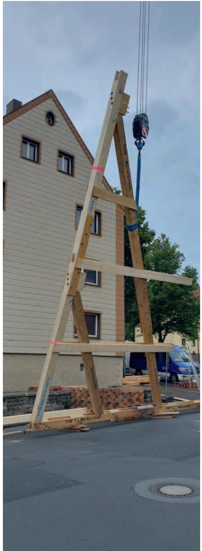
*Einheben der fertig montierten Strebstütze an die Gebäudefassade mit dem Freisinger 50 to. Mobilkran*
