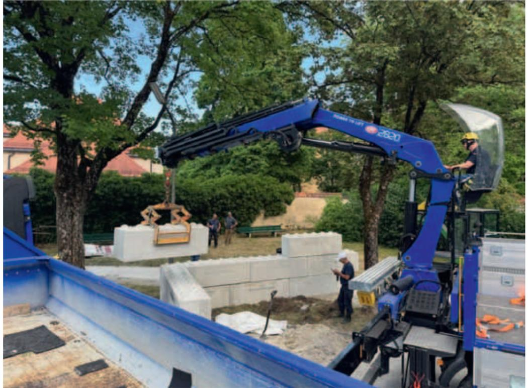
Die Betonbausteine werden in einer V-Anordnung vor den Bombenkörper gestellt, um bei einer evtl. Detonation die Druckwelle in Richtung der Häuser abzufangen. Unter der Folie liegt der Bombenkörper. Die Betonstein werden mit einer Zange am Kran des Wassergefahrenfahrzeuges von München Mitte gestapelt.
