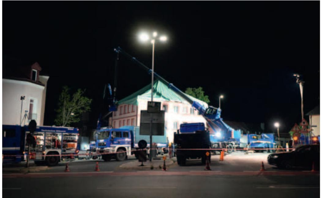
Die beleuchtete Einsatzstelle zur fortgeschrittener Stunde. Das Notdach wird an der Südseite von zwei Arbeitskörben (OV Fürth, OV Neuburg/Donau) aus befestigt. Insgesamt waren drei Kräne mit Arbeitskörbe im Einsatz.
