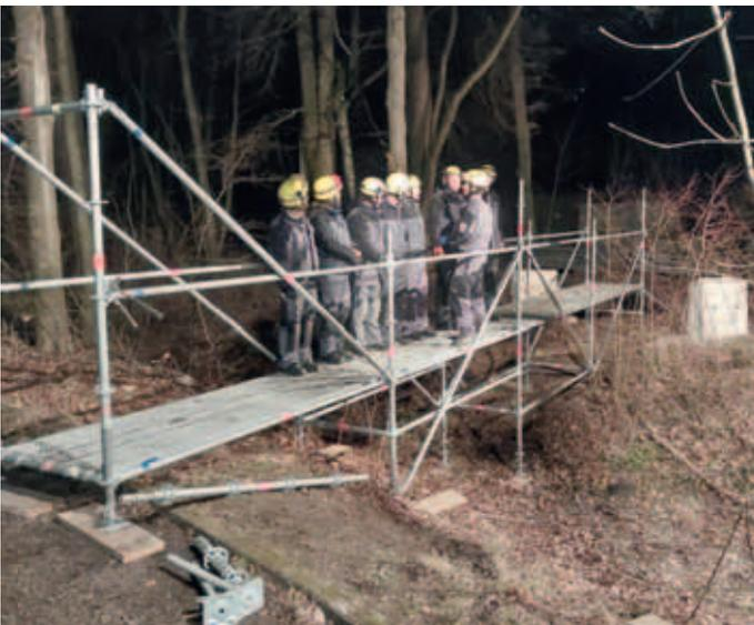
Auch klassische THW-Aufgaben müssen immer wieder geübt werden: Bau eines Behelfsstegs mit dem Einsatzgerüstsystem auf dem Übungsgelände durch die Bergungsgruppe des 1. Technischen Zugs.
