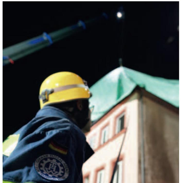
Mit dem Autokran ist es möglich, über das Haus an der Rückseite mit dem Arbeitskorb zu arbeiten. Auch hier wurde das Notdach befestigt.
