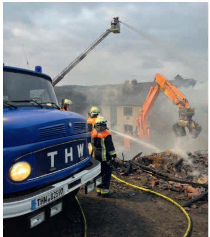
*Unterstützung der Fachgruppe Räumen durch einen Kettenbagger mit Sortiergreifer. Das Brandgut wurde durch die Fachgruppe Räumen zum Ablöschplatz transportiert.*
