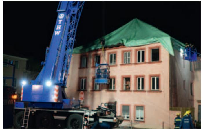
Der Autokran der Fachgruppe Brückenbau vom OV Fürth führt zwei Helfer im Arbeitskorb an das Notdach zur Befestigung.
