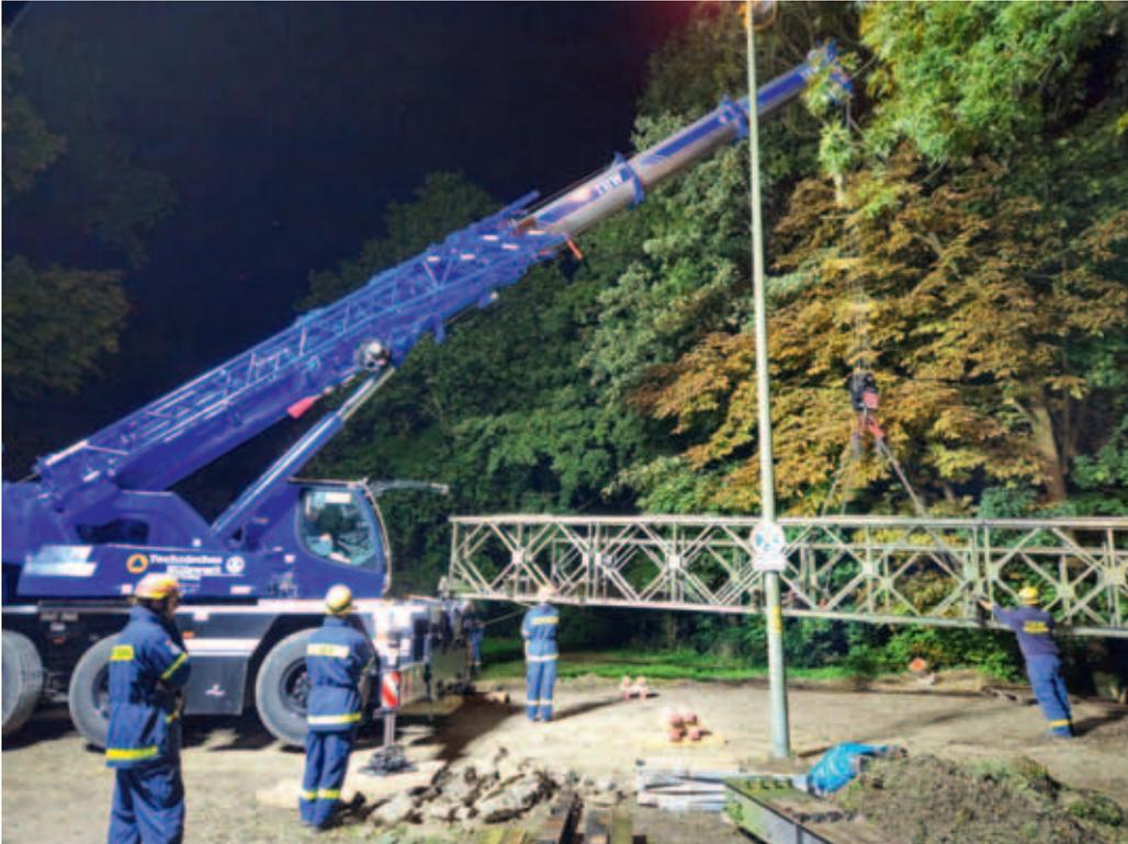
Rückbau der von der Freisinger Brückenbaugruppe errichteten Baileybrücke zur Freisinger Luitpoldanlage. Diese Behelfsbrücke war notwendig geworden, da die alte Brücke baufällig war, der Übergang für Volksfest und andere große Veranstaltungen als Fluchtweg aber zwingend erforderlich ist. Vor Montage der neuen Brücke baute die Brückenbaugruppe die Brücke an einem Wochenende zurück.
