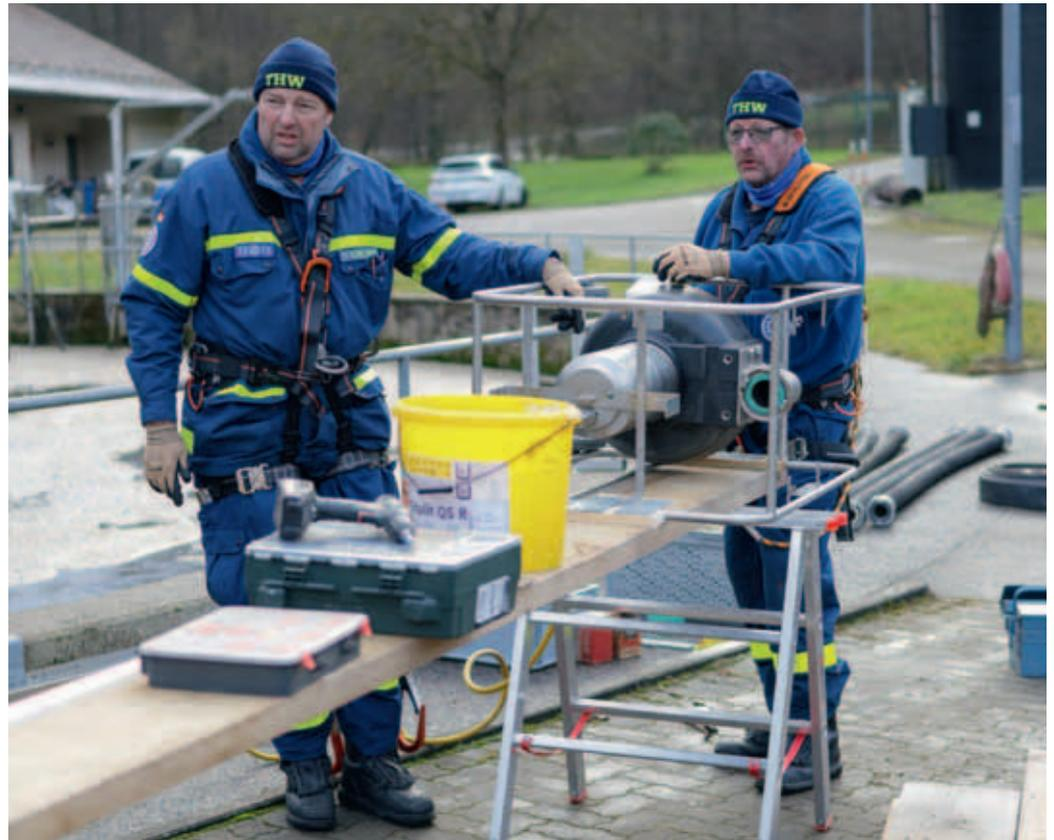
*Befestigung der Wilo-Elektrotauchpumpe zur Installation im Klärbecken*
