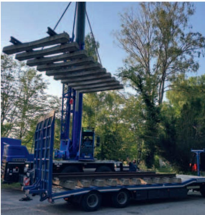
Abladen der je 6 m langen Gleisstücke mit Schwellen vom Multifunktionsanhänger der FG. Brückenbau
