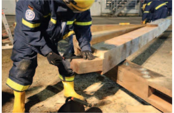
te sich als anspruchsvoll und zeitraubend heraus. Schließlich musste sie passgenau positioniert werden, dabei durften aber keine zusätzlichen Kräfte auf das geschädigte Bauwerk ausgeübt werden.
