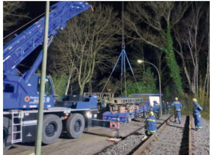
*Umheben des Eisenbahnwaggons vom Mehrzweckanhänger auf den Gleiskörper durch den THW-Kran*
