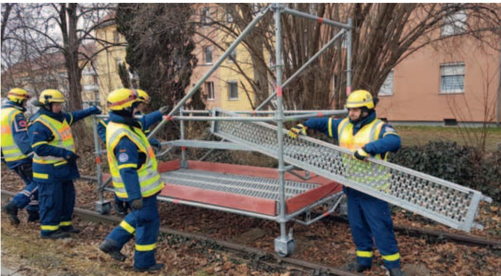
Das Einsatzgerüstsystem (EGS) ist im THW Standard. Es ist vielfältig anwendbar zum Beispiel bei der Sicherung von Einsatzstellen oder bei der Bergung von Menschen.
