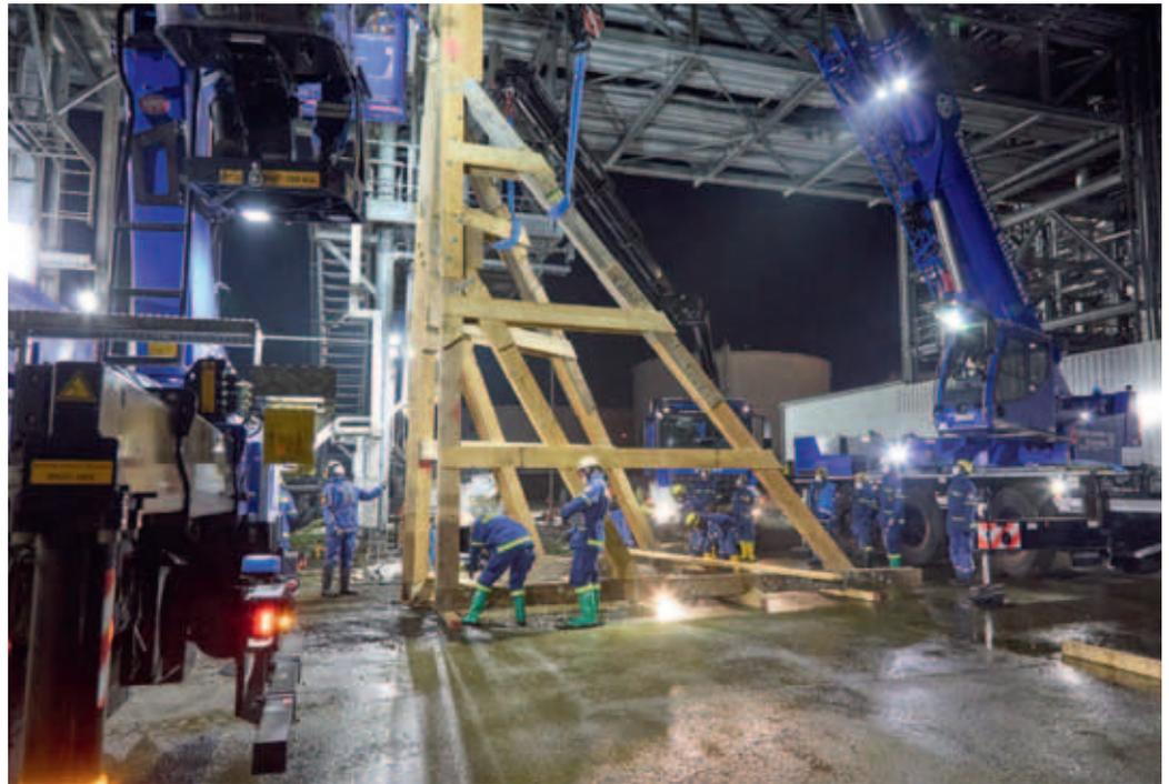
Einheben des vorgefertigten Stützbocks an die Prozesskolonne
