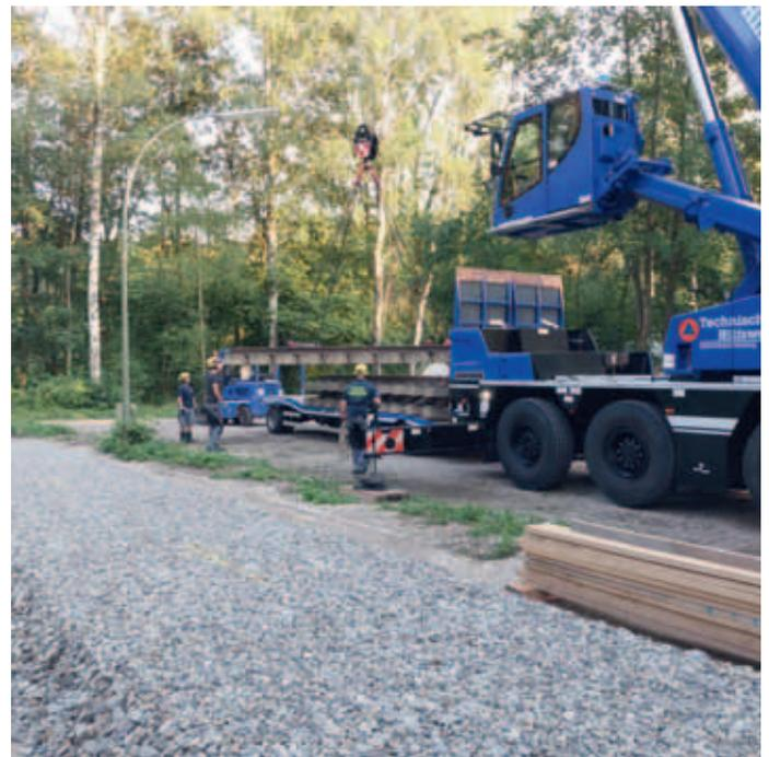
Einheben der Schienenstücke auf das vorbereitete Gleisbett. Die in die Höhe fahrbare Kranbedienkabine bietet dem Maschinisten einen guten Überblick.
