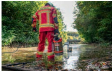
Die im Tank verbaute Schmutzwasserpumpe entleert den Sauger kontinuierlich auch aus 10 Metern Tiefe. Die Technik ermöglicht ein pausenloses Arbeiten mit bis zu 20000 l/h Förderleistung und erlaubt durch die verwendeten breiten Aludüsen mit einstellbaren Gummilippen ein völliges Trockensaugen bis zum letzten Tropfen. Lange, formstabile Schläuche in C-Größe gehören
