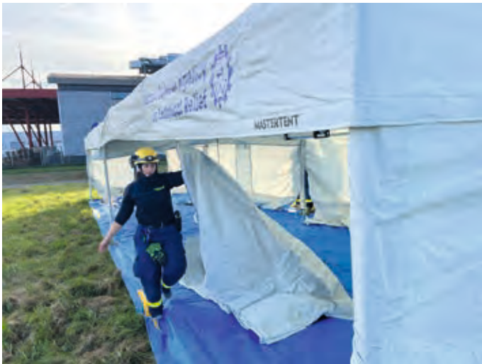
Campaufbau durch die Helfenden des HCP Teams Germany South. Foto: Benjamin Wieland OV Backnang/LVBW
