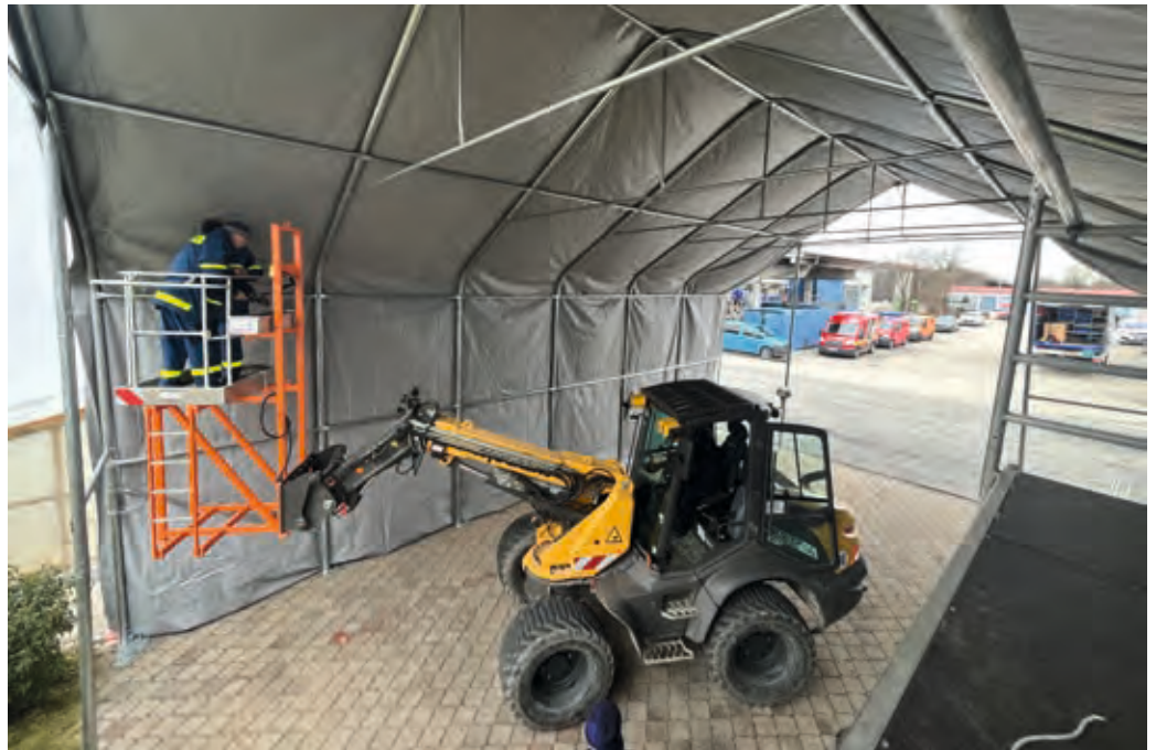
Montage der Zeltplane auf dem Rohrgerüst der Zeltgarage mit dem Radlader des Bauhofs.
