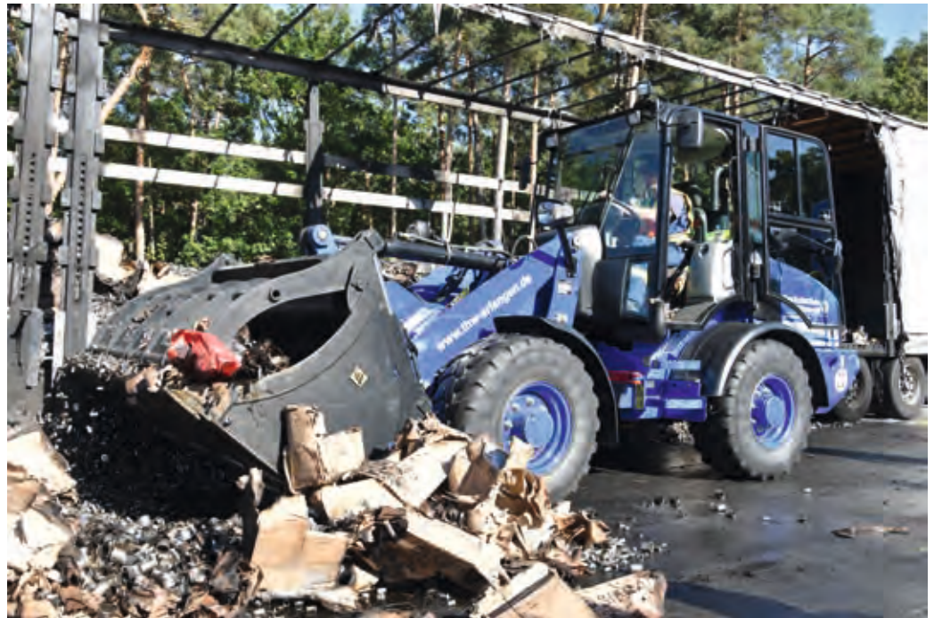
Bergung der verunfallten Ladung mittels Radlader des THW Erlangen
