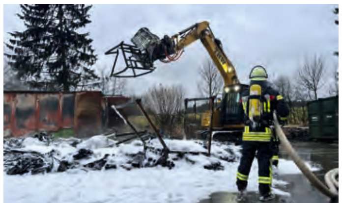
Ausgeglühte Gitterboxen werden vom Kettenbagger getrennt.
