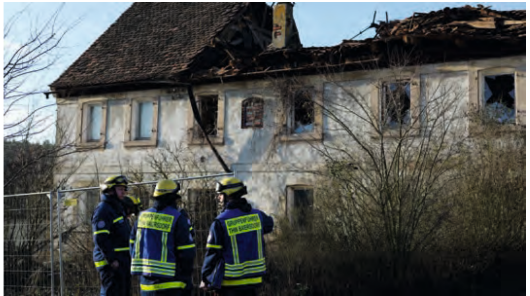
Begutachtung des teileingestürzten Hauses
