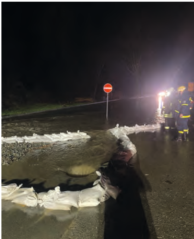
Nächtliche Hochwasser-Schutz-Arbeiten der Fachgruppe Notversorgung und Notinstandsetzung. Der Zugtrupp war koordinierend im Einsatz.
