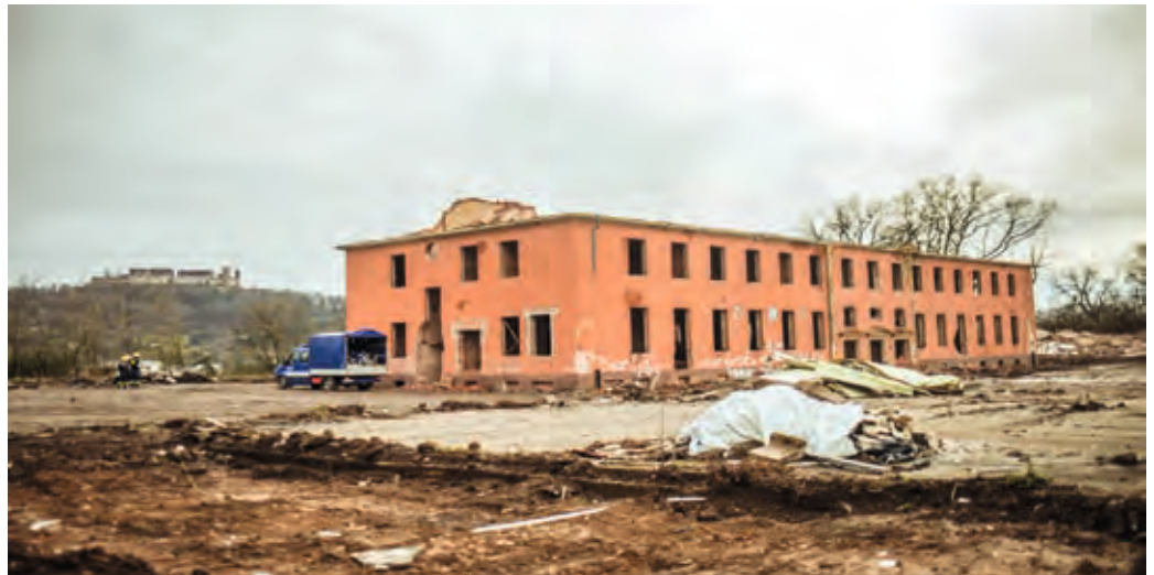
Gebäude vor der Sprengung. Der Dachstuhl wurde durch die beteiligte Abrissfirma zur besten Entsorgung abgetragen. Im Hintergrund die Veste Coburg.
