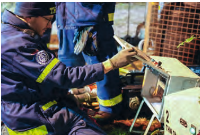
Den Strom für die Pumpen der THW-Ortsverbände Lohr und Obernburg liefert der OV Alzenau.
