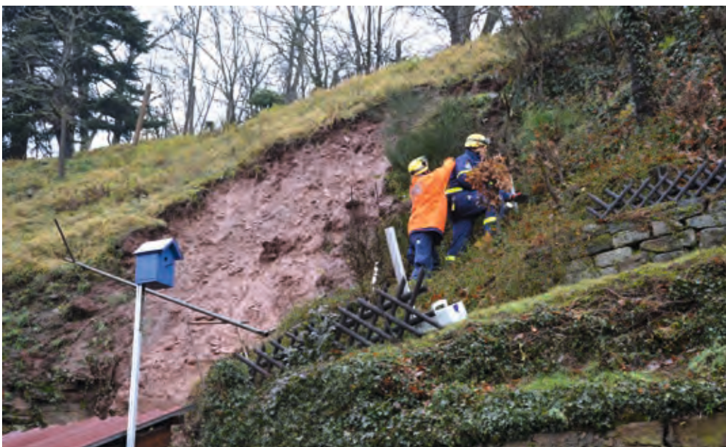
Messpunkte für das ESS werden gesetzt
