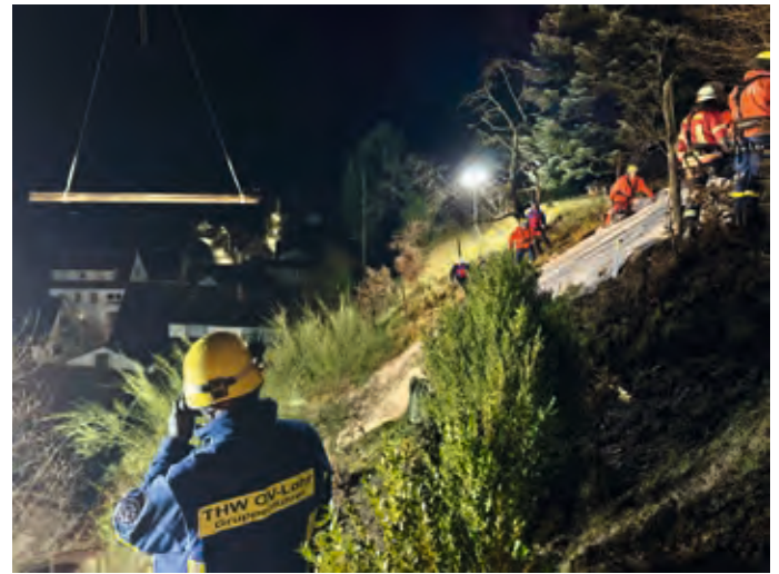
Sicherungsarbeiten am Hang, Material kommt per Kran.
