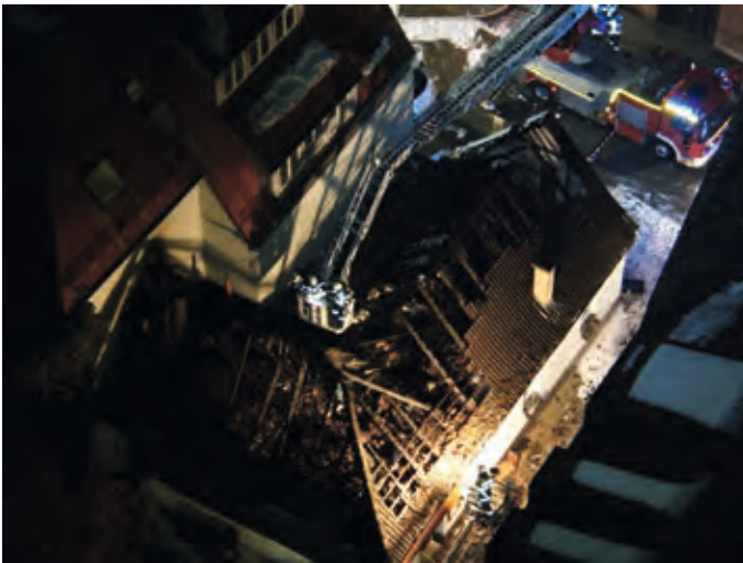
Die Drehleiter der Memminger Feuerwehr bei den Nachlöscharbeiten über dem Dachstuhl
