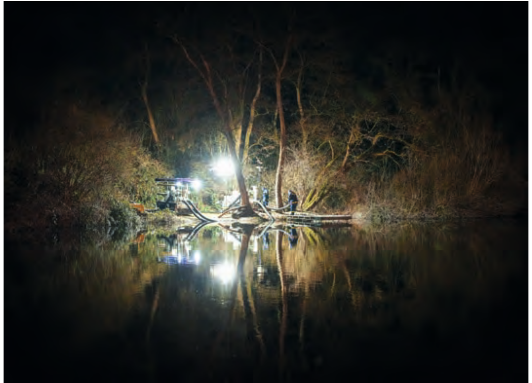
Die Wasserentnahmestelle für die THW-Pumpen am See Emma Süd in Kahl am Main
