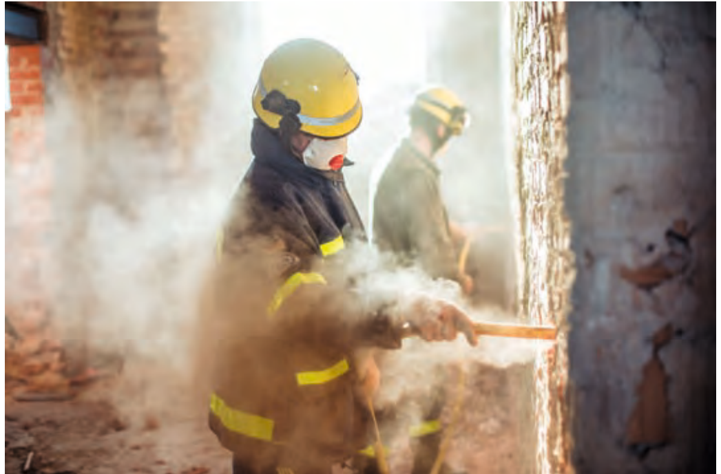
Ausblasen der Bohrlöcher zum Entfernen des Bohrstaubes.
