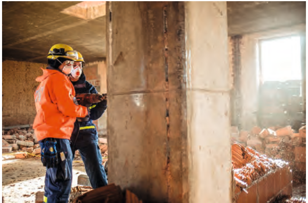
Bohren von Sprenglöchern in einer Betonsäule.
