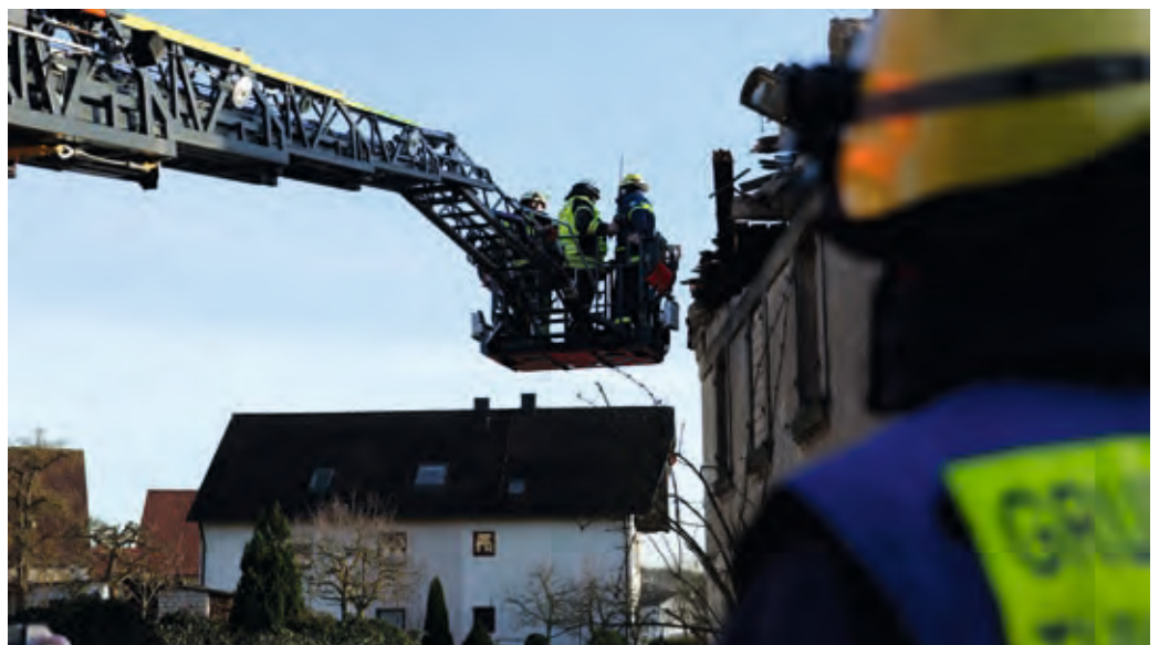
Gemeinsame Beurteilung der Lage auf der Drehleiter zwischen Feuerwehr und THW
