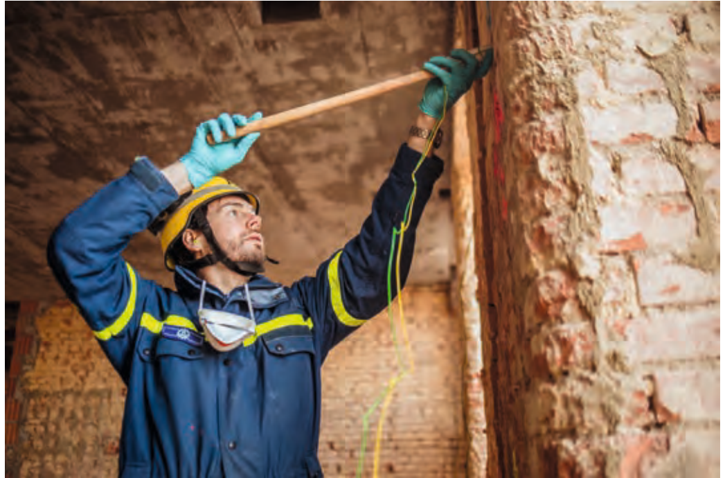
Laden der Bohrlöcher mit Sprengstoff und Läden.
