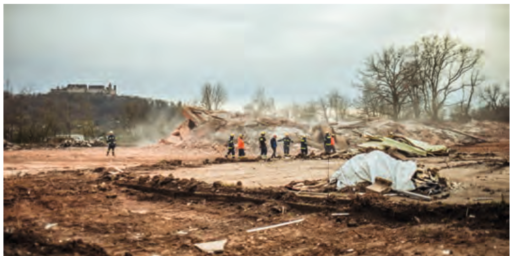
Gebäude nach der Sprengung mit sich verziehenden Staubwolken.
