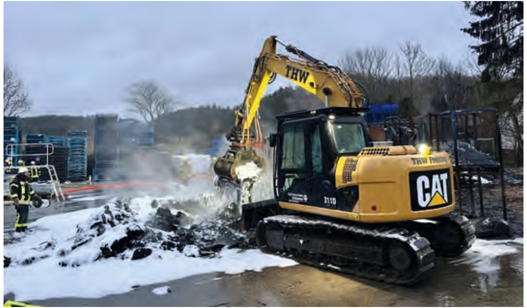
Brandgut wird vom Kettenbagger mit dem hydraulischen Sortiergreifer zum Ablöschen hochgehoben.
