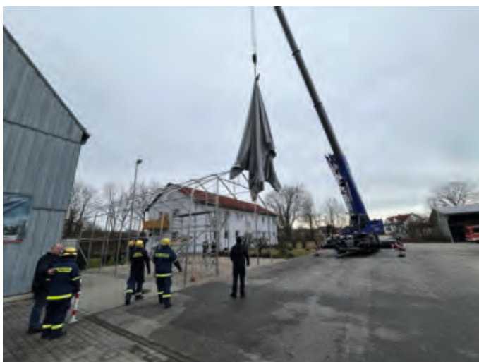
Einheben der Zeltplane über das Rohrgerüst der Zeltgarage.
