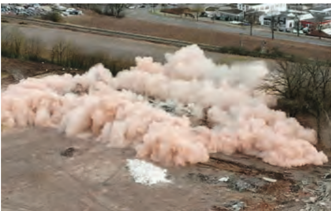
Sequenz der Sprengung und des Einfalls des Gebäudes.
