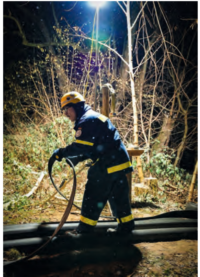
Verlegen der Schlauchstrecke
