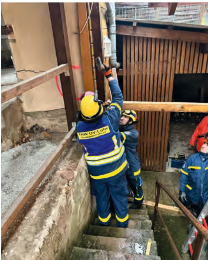
Installation des Fachwerkes zum Abstützen zwischen Wohnhaus und Gartenhütte
