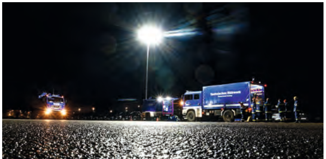
Lichtmasten an den Gruppenfahrzeugen des THW Freising und den Aggregaten sowie auf Stativen sorgen für blendfreie aber taghelle Beleuchtung am Bereitstellungsraum für die VIP-Kolonnen.
