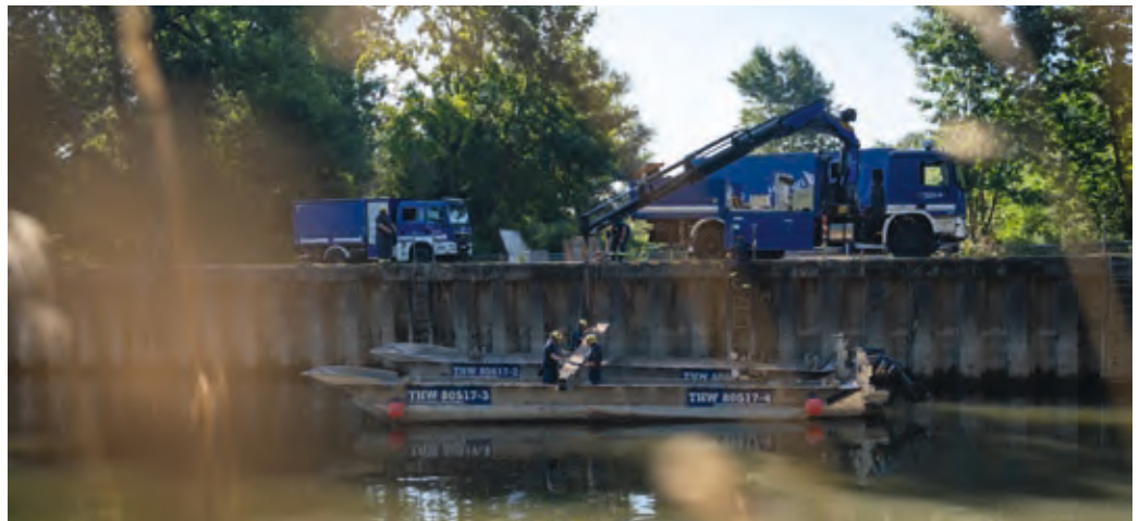
Der Bau der Fähre schreitet voran.
