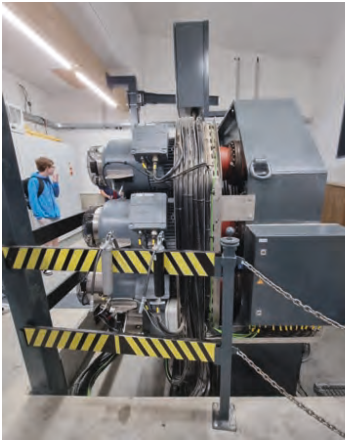
Ein Blick auf die mächtige Seilwinde vom Freefall-Tower „Voltrum“.
