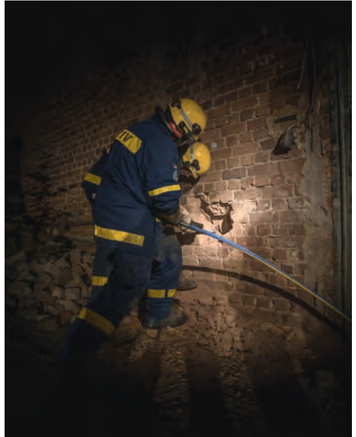
Die Fachgruppe Schwere Berung (OKUL) verschafft sich mit schwerem Gerät Zugang zum alten Brauereigebäude.
