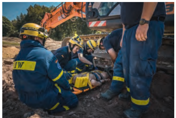
Person unter Baumaschine: Nach dem Freigraben der Person folgt die Fixierung und Rettung auf dem Spineboard.
