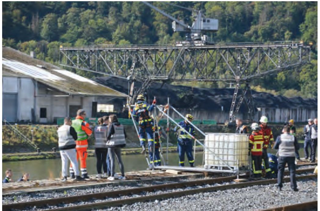
Aufbau des EGS an der Kaimauer
