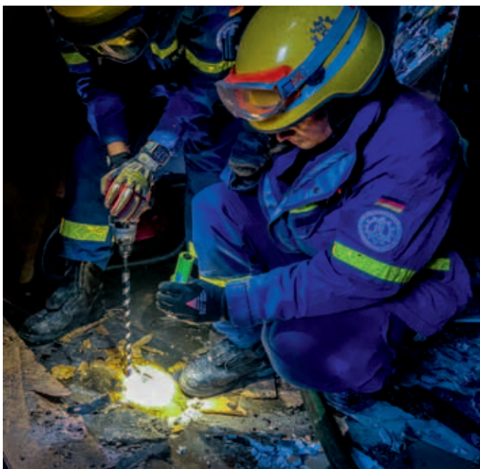
Mit der Bohrmaschine werden Öffnungen geschaffen, um ein Abfließen des Löschwassers aus der Zwischendecke zu ermöglichen.
