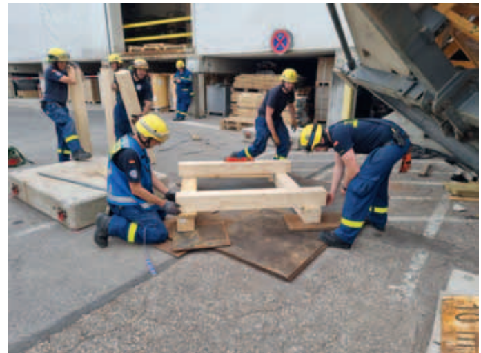
Zuschnitt des für den Kreuzholzstapel benötigten Holzes vor Ort an der Einsatzstelle.
