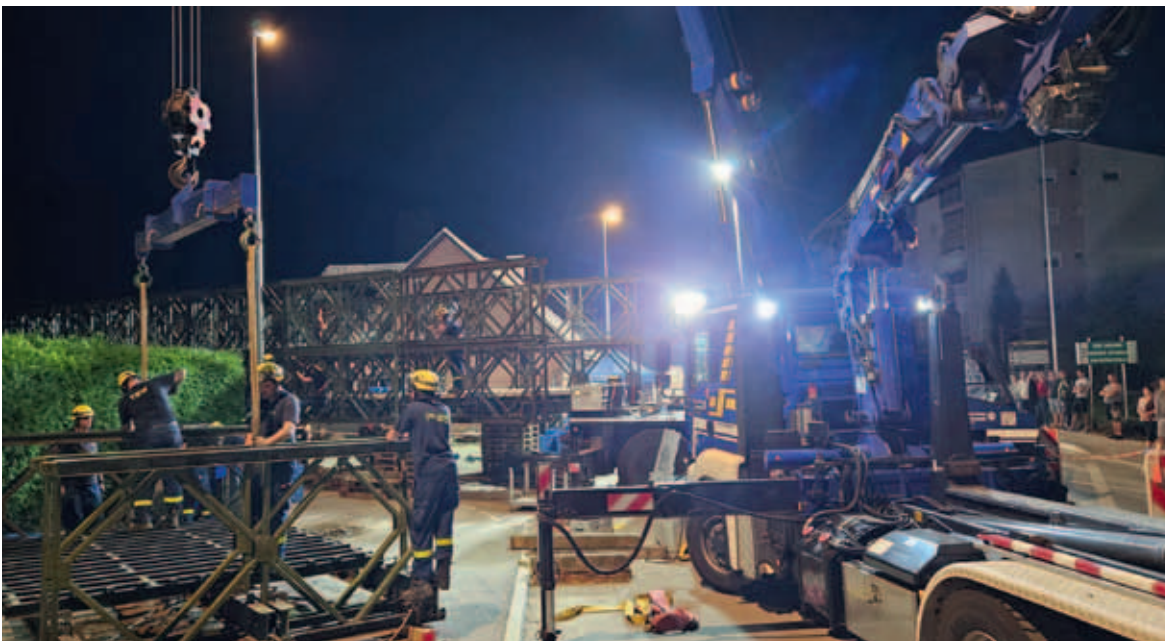
Einheben von Brückenteilen in der Nacht unter Flutlicht
