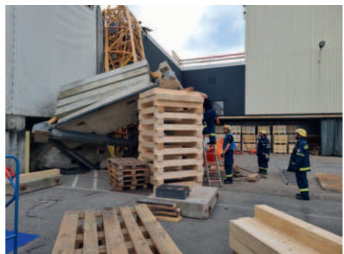
Durch den Umsturz hängen einige Kranfüße der Kranbasis in der Luft. Um ein Zurückschlagen der tonnenschweren Baukranbasis bei der Demontage des Krans zu verhindern, unterbauten die Freisinger Einsatzkräfte die Basis mit einem sog. Kreuzholzstapel. Durch seine Form kann er das Gewicht der Baukranbasis problemlos stützen und verhindert so unkontrollierte Bewegungen bei der Demontage des Krans.
