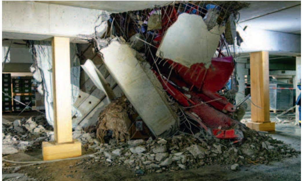
Abstützung durch Holzriegel im Keller. Das Kontergewicht mit den Seiltrommeln des Krans hatte das Gebäude beim Umfallen komplett durchschlagen und einen zentralen Betonunterzug zerstört. Die an der Einschlagstelle befindliche Betonstütze wurde durch die Wucht des Einschlags sprichwörtlich pulverisiert.
