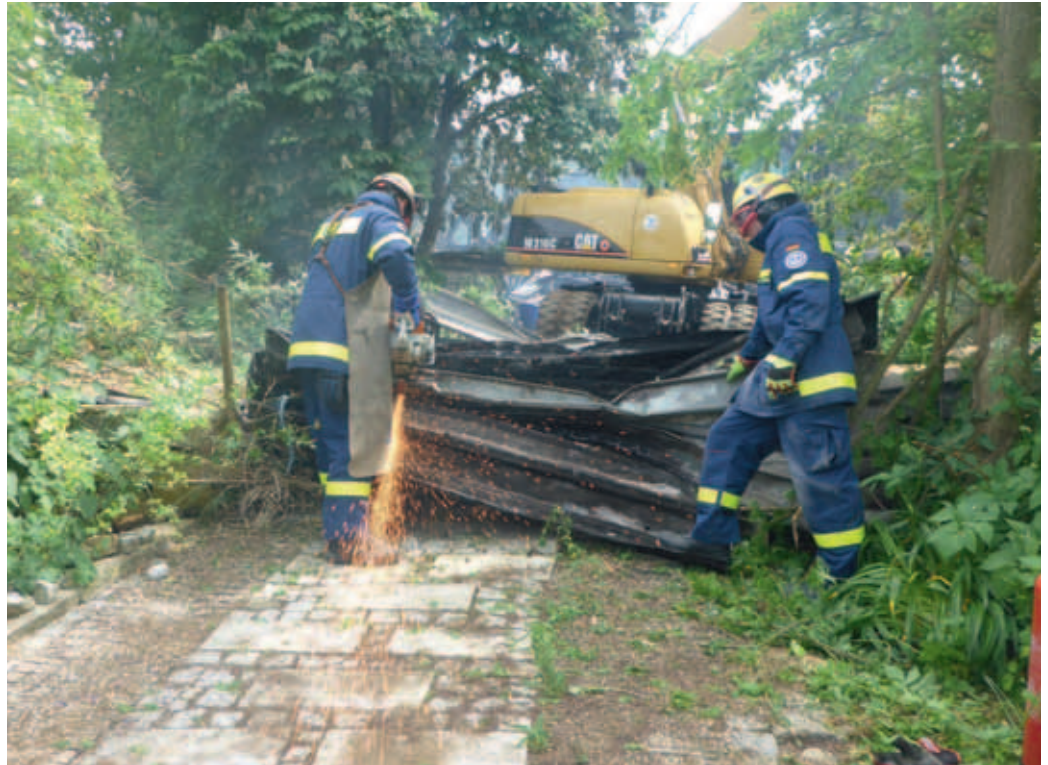
Zwei Einsatzkräfte zerkleinern Teile der abgerissenen Scheune mittels Motortrennschleifer für einen einfacheren Transport.
