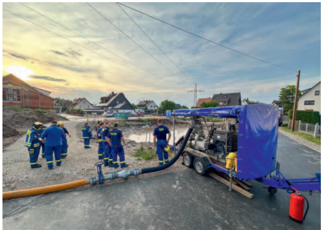
Die Fachgruppe Wasserschaden/Pumpen des THW-Ortsverbandes Erlangen beförderte mit einer sogenannten „Hannibal“-Großpumpe ca. 5.000 Liter in der Minute aus der Baugrube - bis das offene Kanalrohr sichtbar wurde und verschlossen werden konnte.
