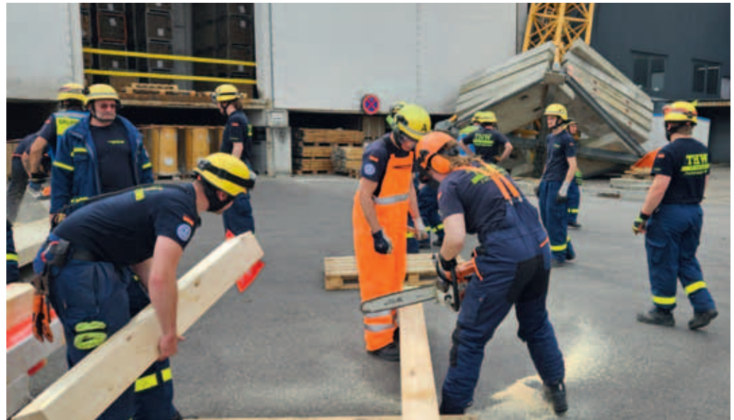
Zuschnitt des für den Kreuzholzstapel benötigten Holzes vor Ort an der Einsatzstelle.
