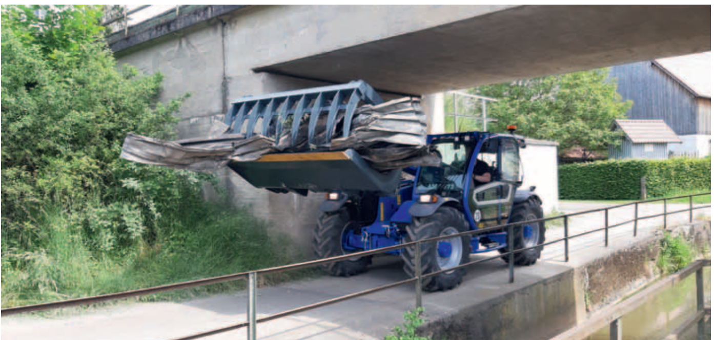
Durch den Teleskoplader wird Brandgut vom Einsatzort zur Verladestelle transportiert.
