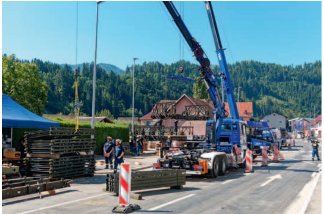
Vormontage der Seitenwände für die erste Brücke mit dem Ladekran des Wechselladers des THW Dachau
