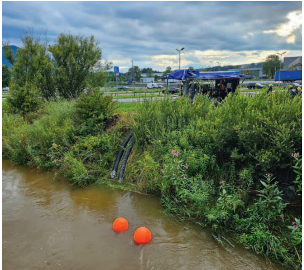
Zur Löschwasserversorgung wurde außerhalb des Werkgeländes mittels der Großpumpe Hannibal Wasser aus einem Bach angesaugt.
