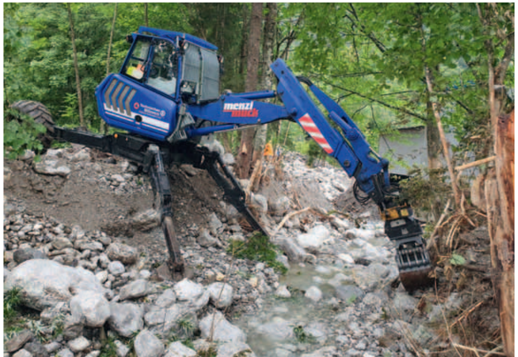
Solčava am 10.8.2023, Beräumen und Wiederherstellen eines Bachlaufes, Schreitbaggerfahrer: Martin Bergner
