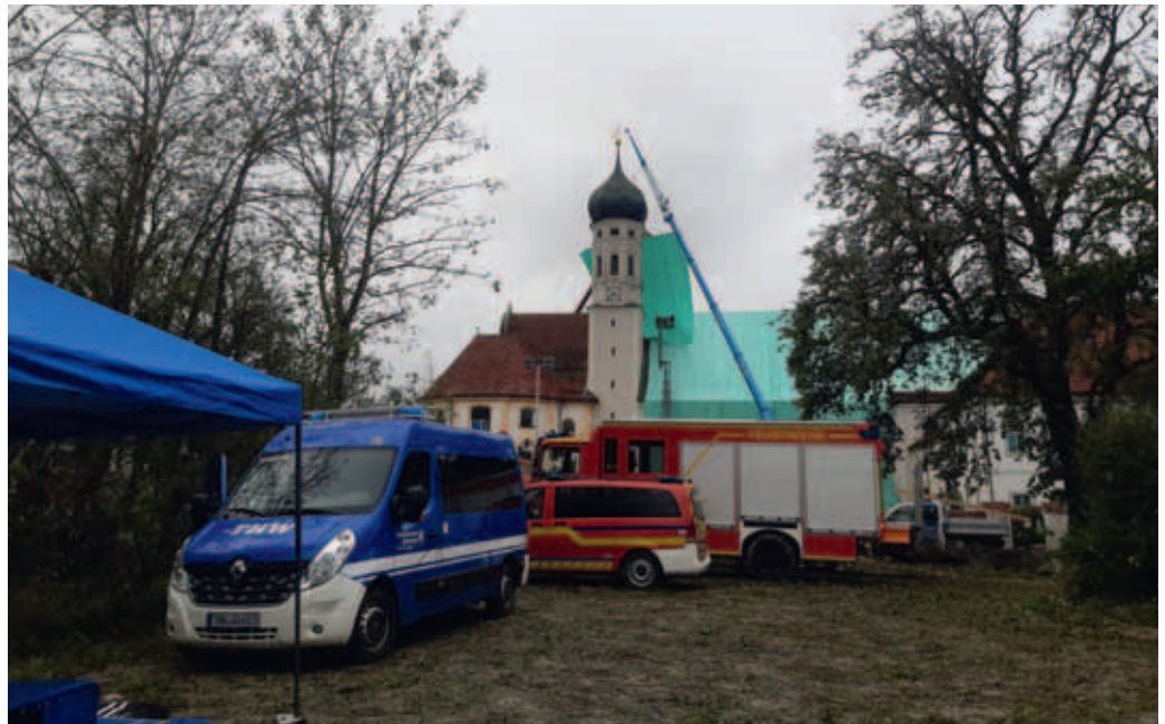
Großen Schaden richtete das Unwetter im Klosterbereich Benediktbeuern an. Das THW brachte Sicherheitsplanen an, denn die Dächer waren schwer beschädigt. Die Anlage wurde für Besucher längerfristig gesperrt.
