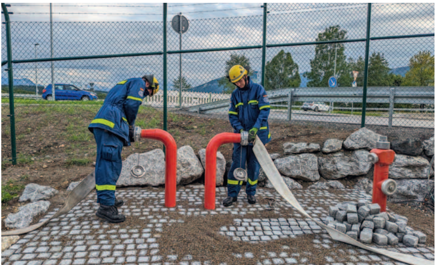
Über vorverlegte Rohrleitungen können die THW-Kräfte Maximilian Weber und Nico Schneider das außen angesaugte Wasser ins Werkgelände der Firma Bosch leiten.
