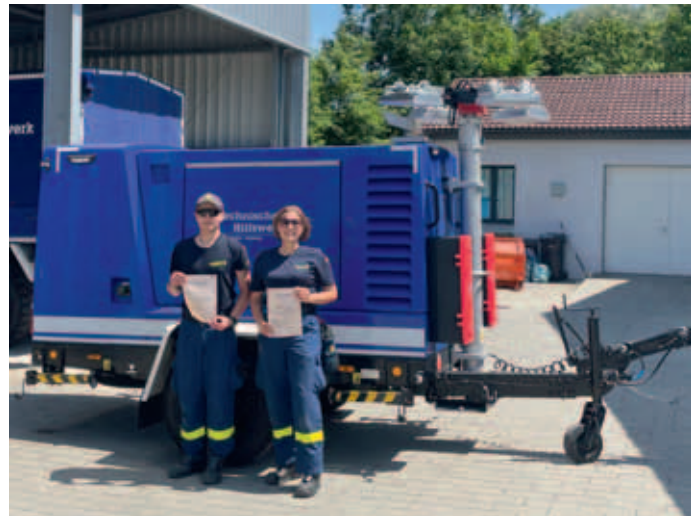
Kevin Oberhuber und Eva Sellmayer – zwei der „frisch gebackenen“ Maschinisten mit ihrem möglichen Arbeitsgerät, dem Notstromaggregat mit einer Leistung von 50 kVA der Fachgruppe Notversorgung und Notinstandsetzung. Foto: Michael Wüst
