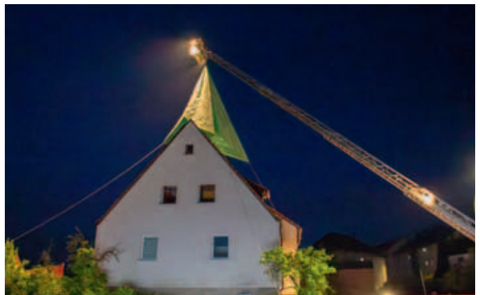
Mit der Drehleiter wird die Plane langsam über dem Dach abgelassen.
