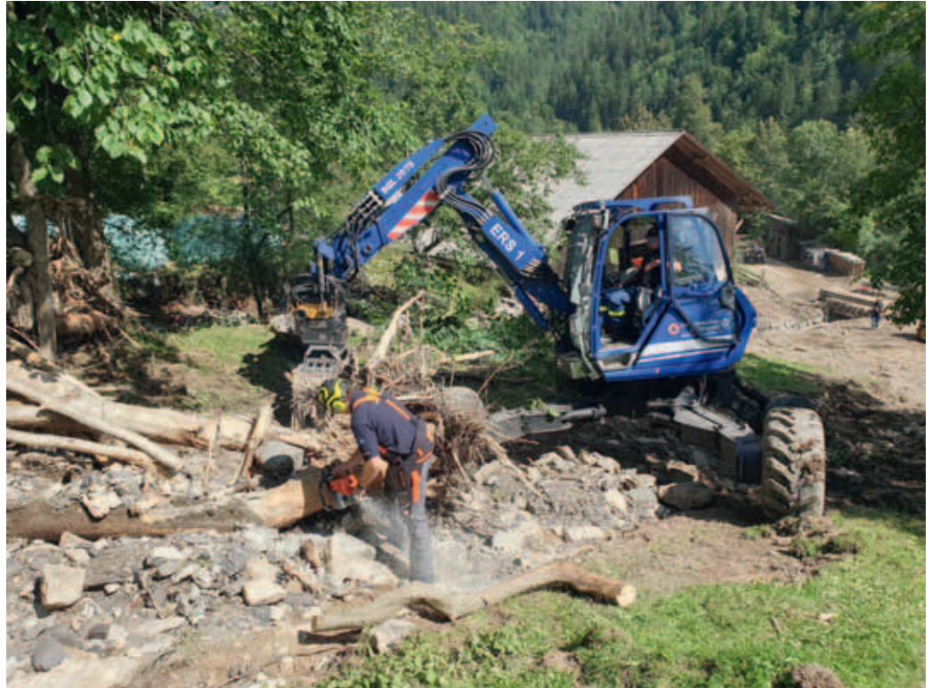
Ljubno ob Savinji am 8.8.2023, Beräumen und Wiederherstellen eines Bachlaufes, Motorsägenführer: Michael Judex, Schreitbaggerfahrer: Leonhard Deinbeck
