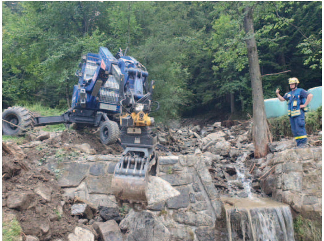
Ljubno ob Savinji am 8.8.2023, Beräumen und Wiederherstellen eines Bachlaufes, Schreitbaggerfahrer: Martin Bergner, Gruppenführer: Leonhard Deinbeck
