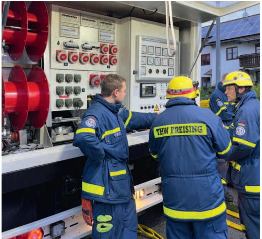
*Elektrofachkräfte des THW überwachen die Stromabgabe über das Bedientableau des Aggregats.*
