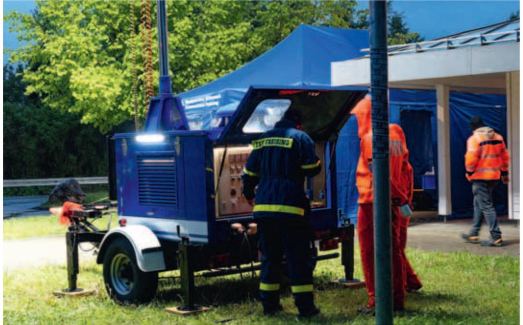
*Inbetriebnahme des Lichtmastes der vereinseigenen Netzersatzanlage 24 kVA am Einsatzort.*
