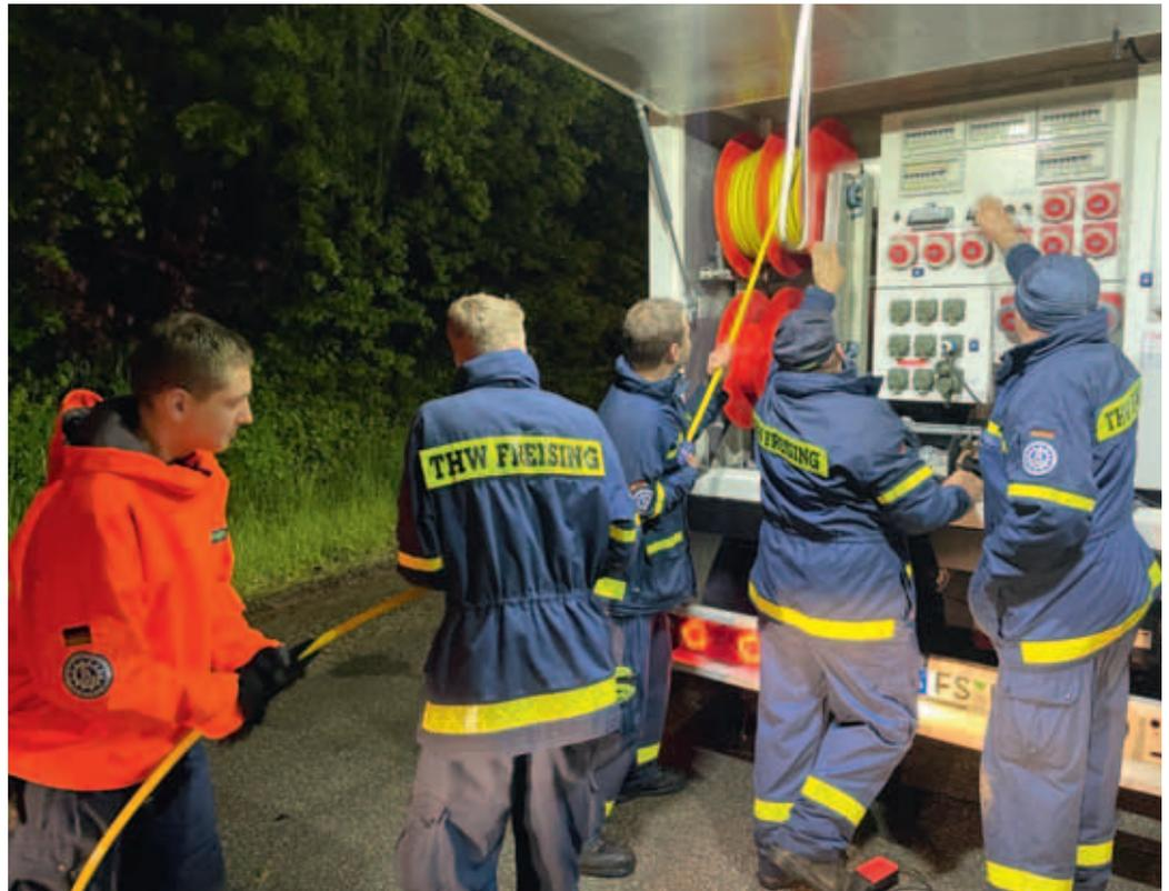
*Einsatzkräfte des THW Freising ziehen Stromkabel von den im Notstromaggregat mitegeführten Kabeltrommeln, um darüber eine elektrische Verbindung zwischen Aggregat und Einspeisepunkt zu schaffen.*
