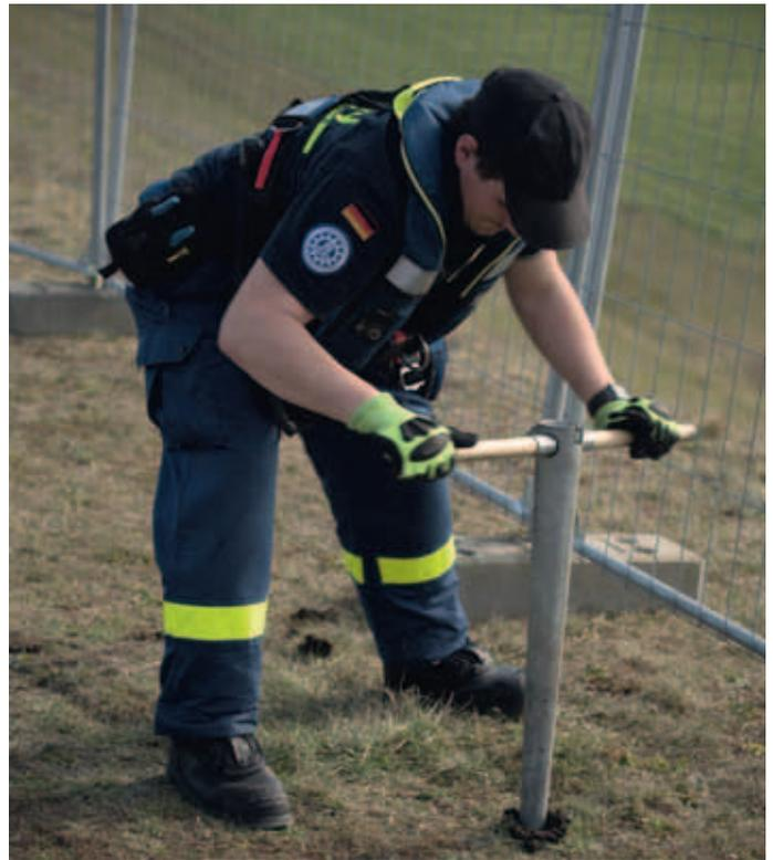
Die Hochleitungsaggregate erfordern eine sichere Erdung im Boden.
