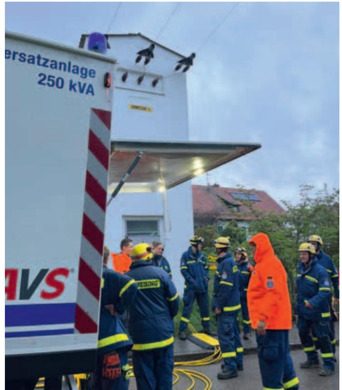
Das Notstromaggregat wird über die auf den Kabeltrommeln mitgeführten Starkstromkabel direkt im örtlichen Energieverteiler in das Stromnetz eingespeist.
