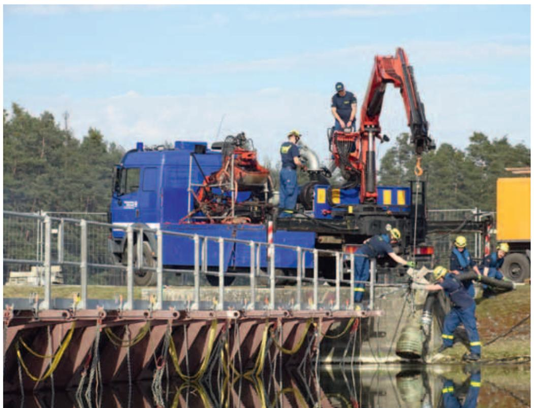
Kräne und viele starke Hände ermöglichen den Einbau der Hochleistungspumpen.
