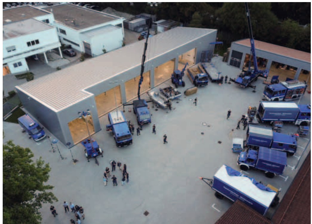
Ein Blick von oben auf Teile der aktuellen THW-Unterkunft und den Fuhrpark.
