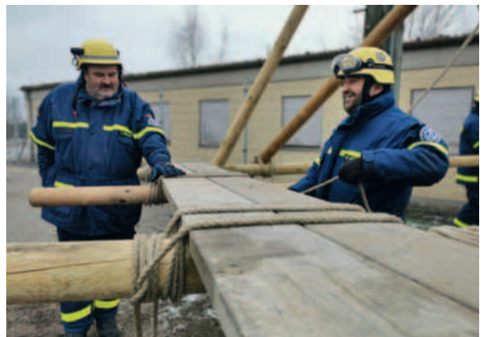
Befestigen der Trittbretter (Holzbohlen) an den Holmen der Zweiböcke.
