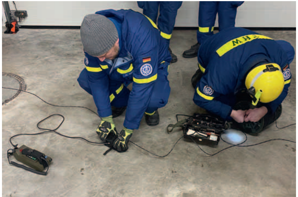
Fingerspitzengefühl ist von den Helferinnen und Helfern des Hiltpoltsteiner THW-Ortsverbandes beim Kabelbau für die Einrichtung eines modernen AWITEL-Netzes gefragt.
