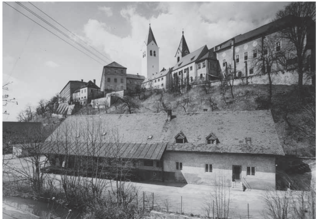
Damals nannten sich die Unterkünfte noch „THW-Heim“. Das war das alte Freisinger THW-Zuhause...
