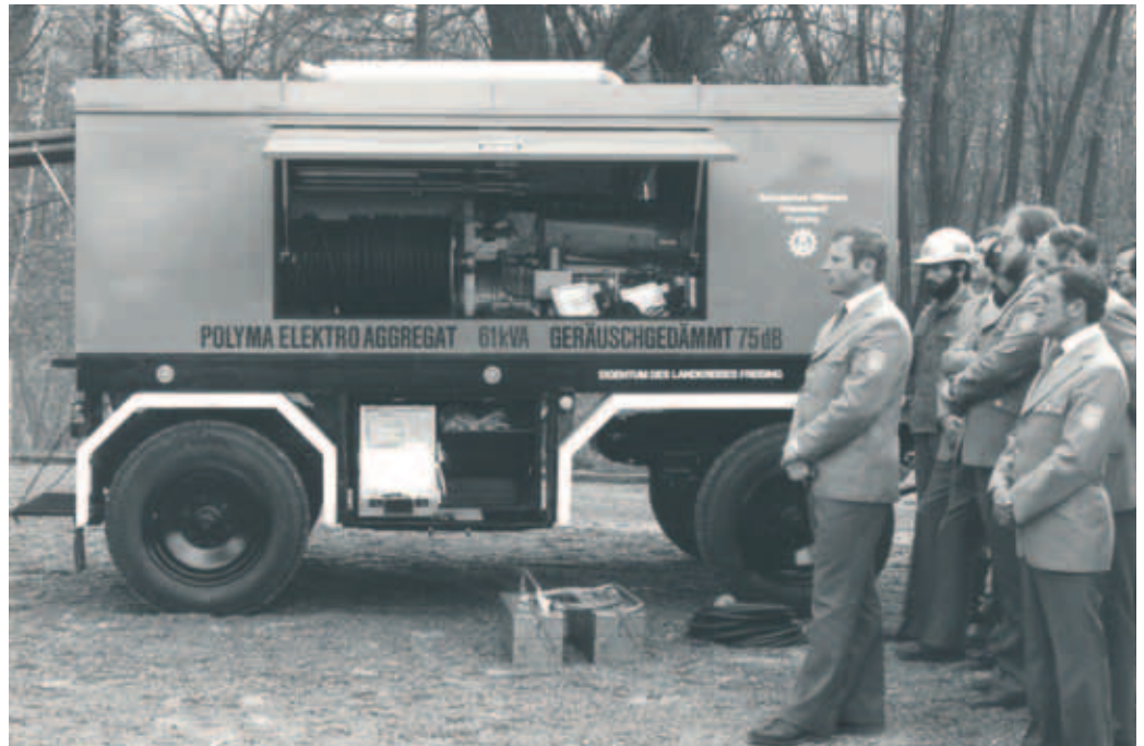
Erinnerung an 1982 - Übergabe der Netzersatzanlage an den THW-Ortsverband Freising.
