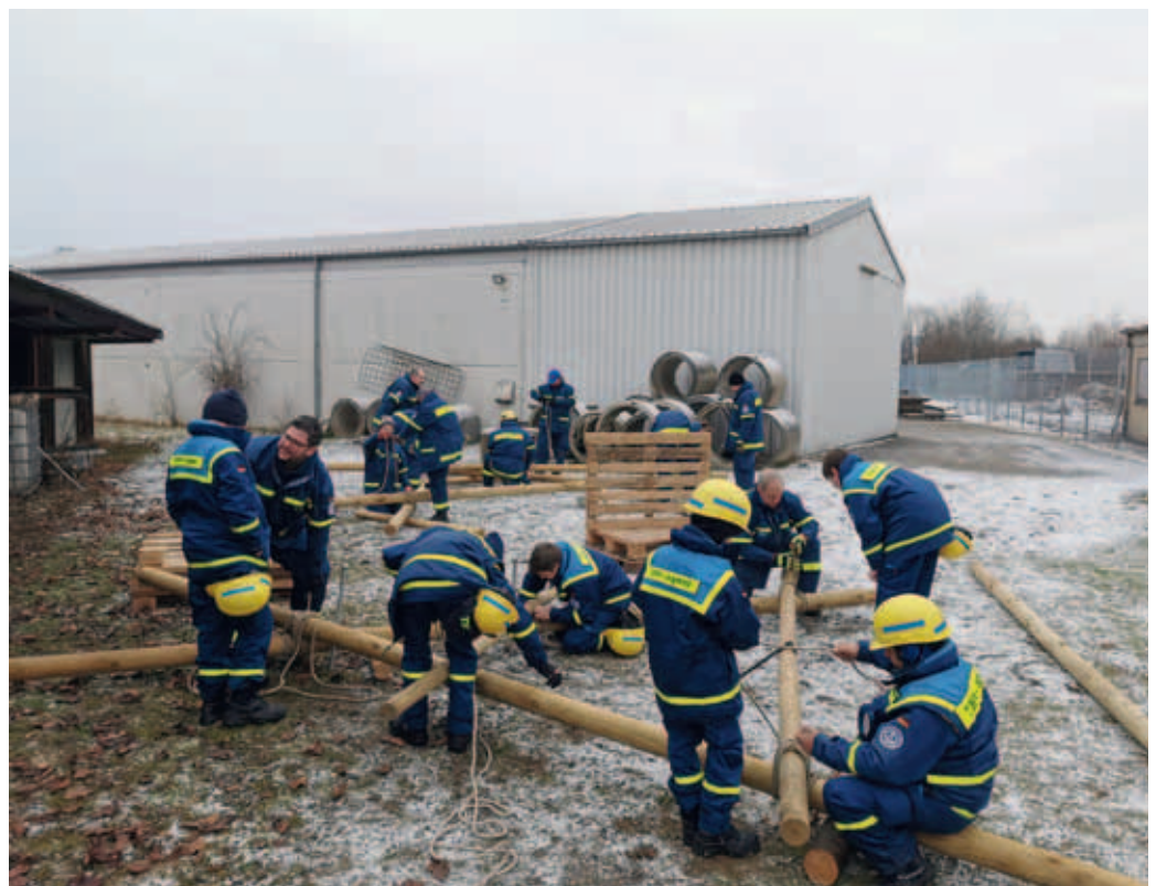
Bau der Zweiböcke für den Trümmersteg mithilfe der THW-Jugend.
