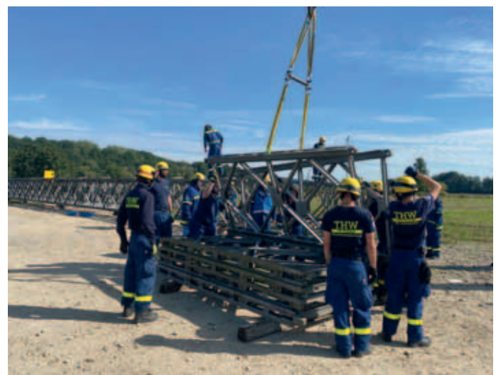
Der Freisinger Autokran erleichtert das Handling der schweren Teile.
