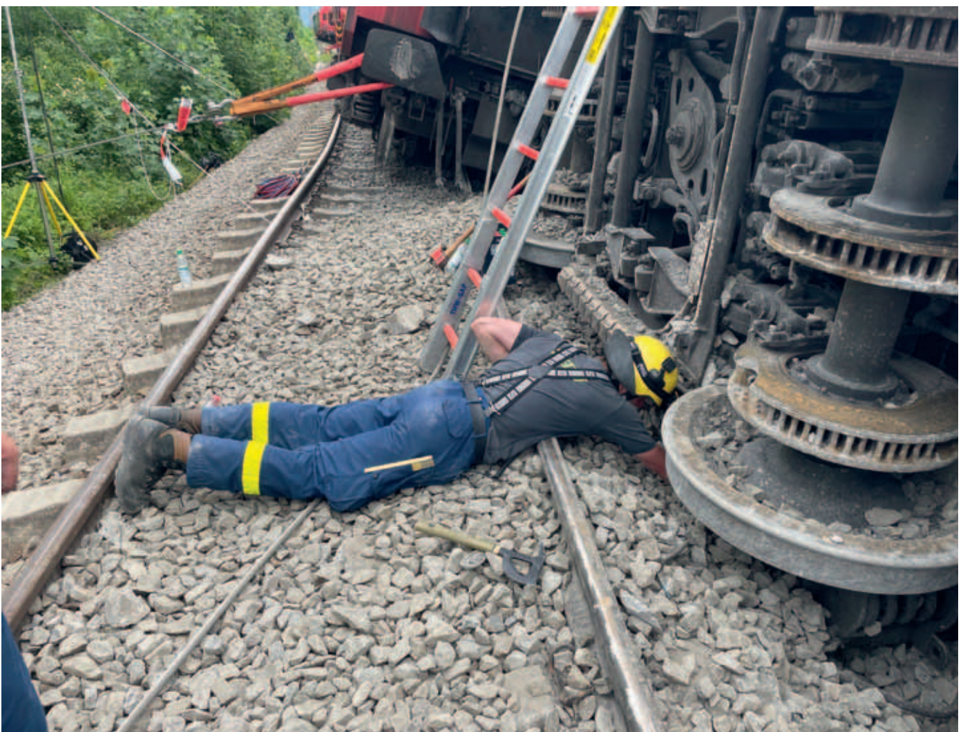
THW-Einsatzkraft beim Anbringen von Anschlagmitteln am entgleisten Zug, um Seilwinden befestigen zu können, mit deren Kraft der Waggon gesichert wird, damit der nicht vom Bahndamm rutscht.
