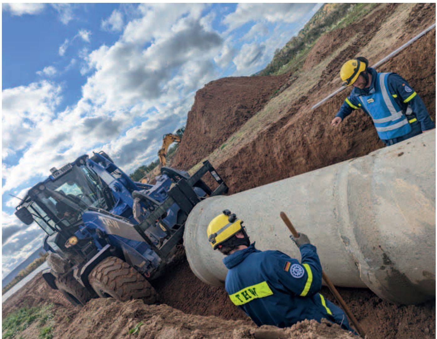
Die Fachgruppe Räumen setzt die Betonrohre mit 120 cm Durchmesser, die den Wasserdurchlass sicherstellen sollen.
