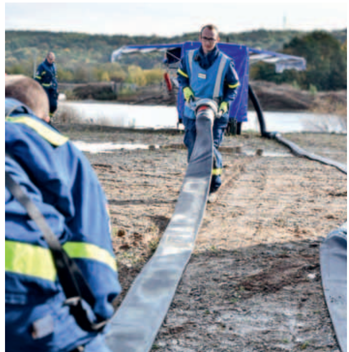
Die Schläuche für die Schlauchleitung werden vorbereitet. Insgesamt kommen rund 50 m Schlauch zum Einsatz.
