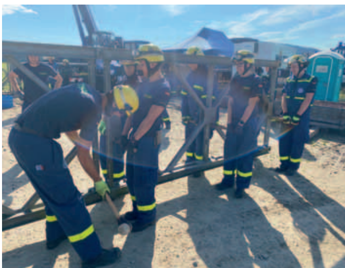
Kräftige Hammerschläge lösen die Bolzen der seitlichen Träger.
