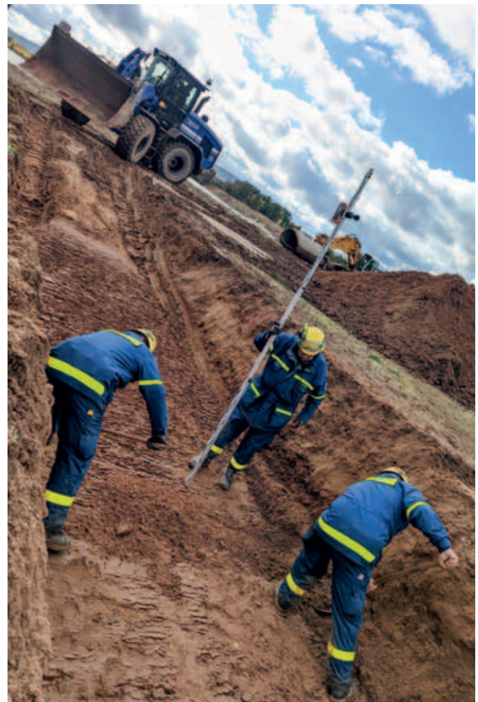
Helfer der Fachgruppe Räumen bereiten den ausgehobenen Graben für das einsetzen der Rohre vor.
