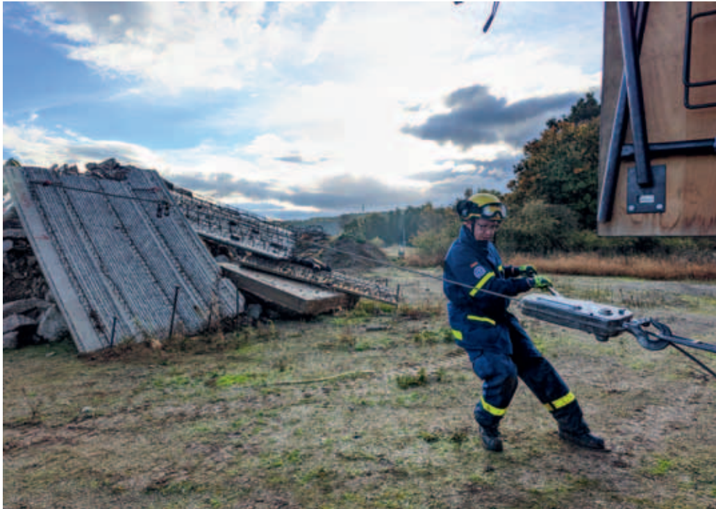
Mit Technik und Manpower werden die schweren Trümmer nach der Gasexplosion beseitigt.
