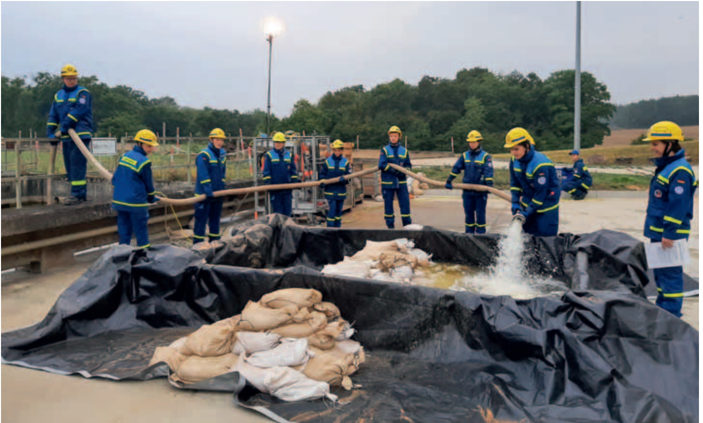
Selbst gebautes Behelfsbassin aus Leitern und einer Plane
