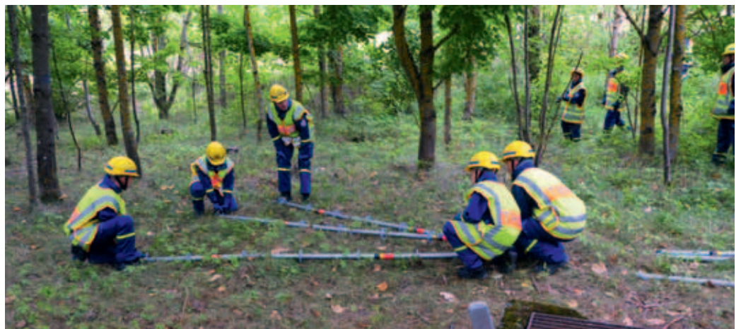
Aufstellen eines EGS-Dreibock
