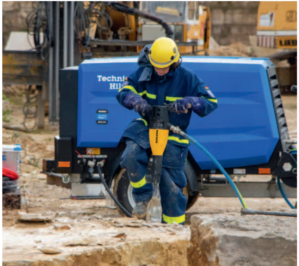
Vor dem Abtransport von Geröll und Abraum müssen große Gesteinsbrocken mit Druckluftherzeuger und Werkzeugen zerkleinert werden, was ebenfalls geübt wurde.
