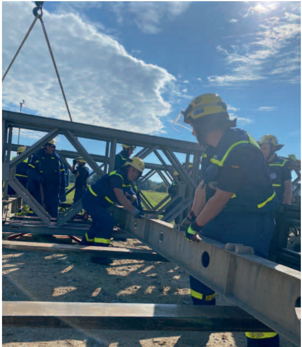
Die Auflieger für den Fahrbahnbelag wurden zuerst entfernt.
