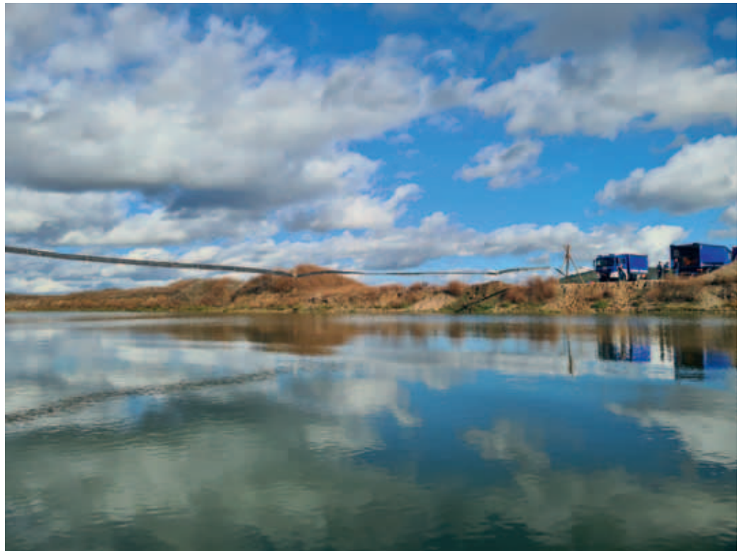
Die über den Fluss führende Schlauchstrecke, die mittels Dreibock errichtet wurde.
