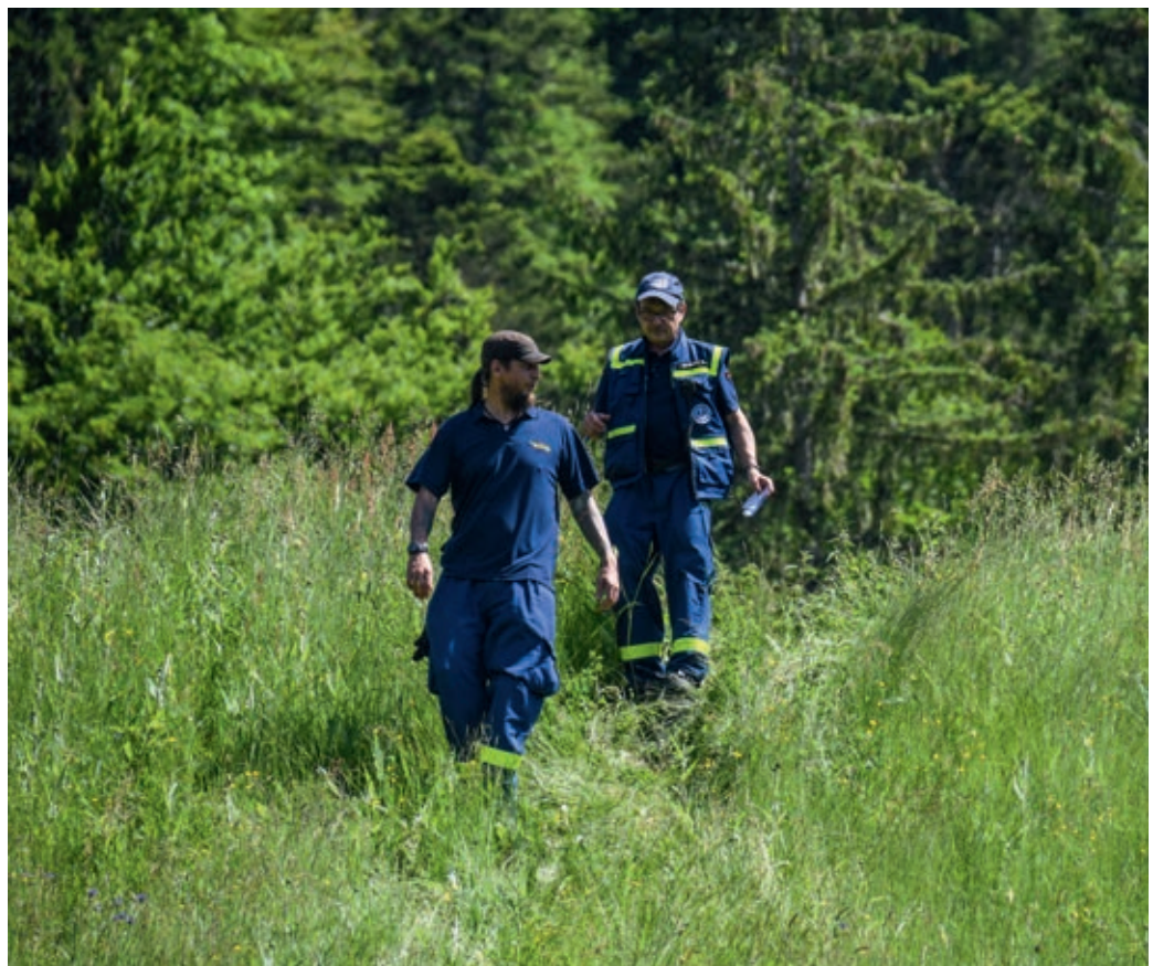
Thorsten Rindfleisch und Helmut Aulbach verlegen Leitungen rund um das Schloss Elmau.
