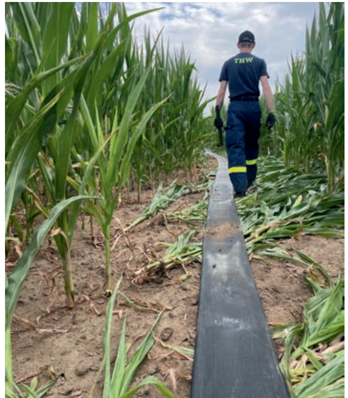
Rund 6 km Schlauchstrecke zur Löschwasserförderung mussten verlegt werden. Dies war nur als Teamleistung mehrerer Fachgruppen Wasserschaeden/ Pumpen möglich. Durch Felder und Wiesen wurden die Schläuche verlegt – ein Kraftakt aller Beteiligten. Die gemischte WP aus Bamberg und Forchheim konnte mit dem vorhandenen Material eine Strecke von rund 760 m abdecken.
