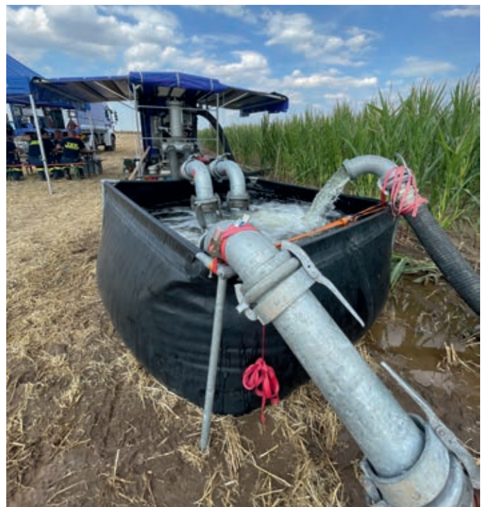
Gepumpt wurde von der Elbe in Pufferbecken. Aus denen wurde das Wasser mit Großpumpen entnommen und in den nächsten Schlauchabschnitt befördert. Nur so konnten die langen Distanzen überwunden werden.
