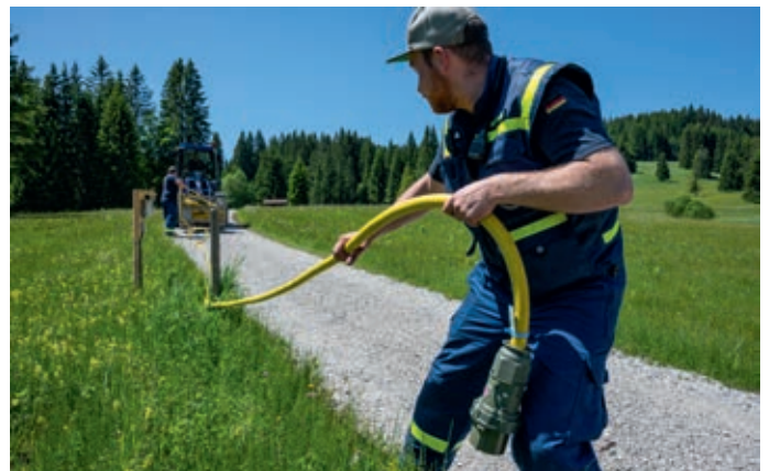
Für die Verlegung der über 27 km Kabel packten die Helferinnen und Helfer bereits Wochen zuvor tatkräftig an.
