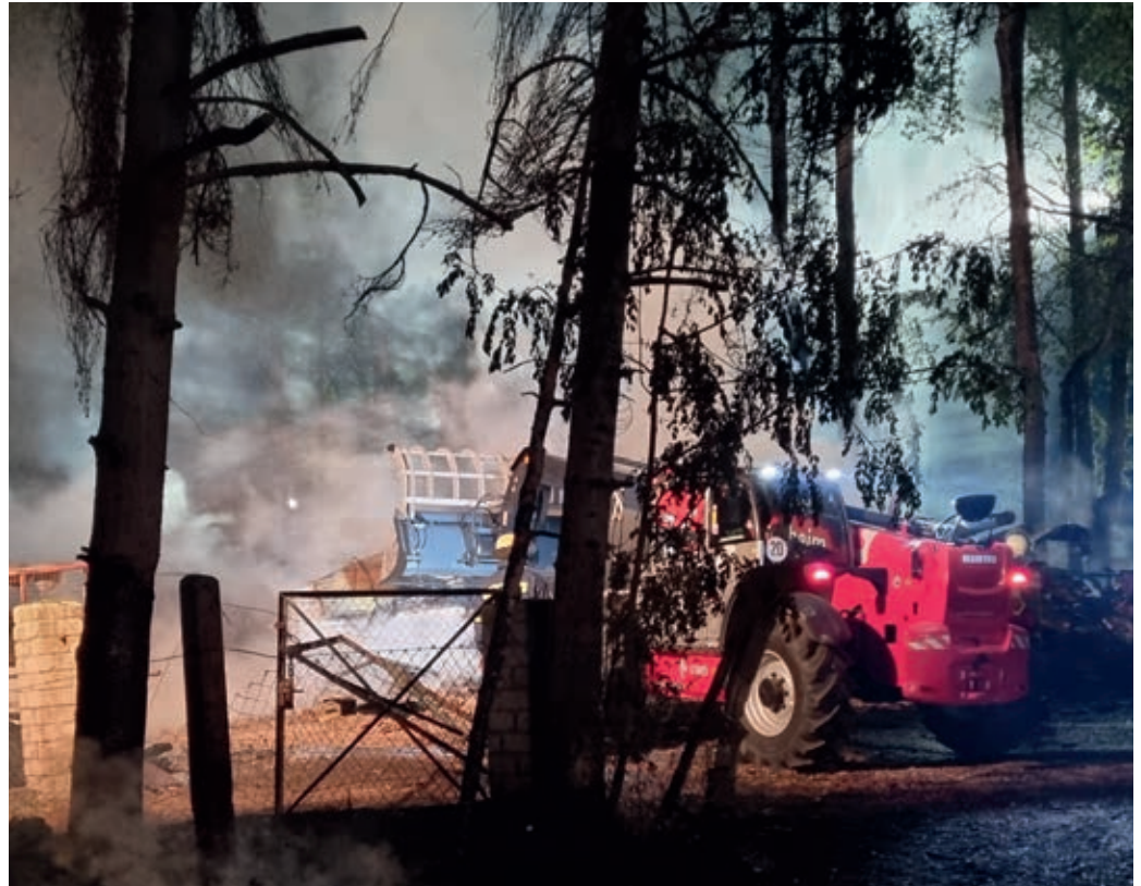
Mittels Teleskopladern und eines gewerblichen Baggers wurden Brandreste geborgen und an einen Sammelplatz gebracht, um eventuelle Glutnester gezielt löschen zu können und ein Ausbreiten des Feuers zu verhindern.
