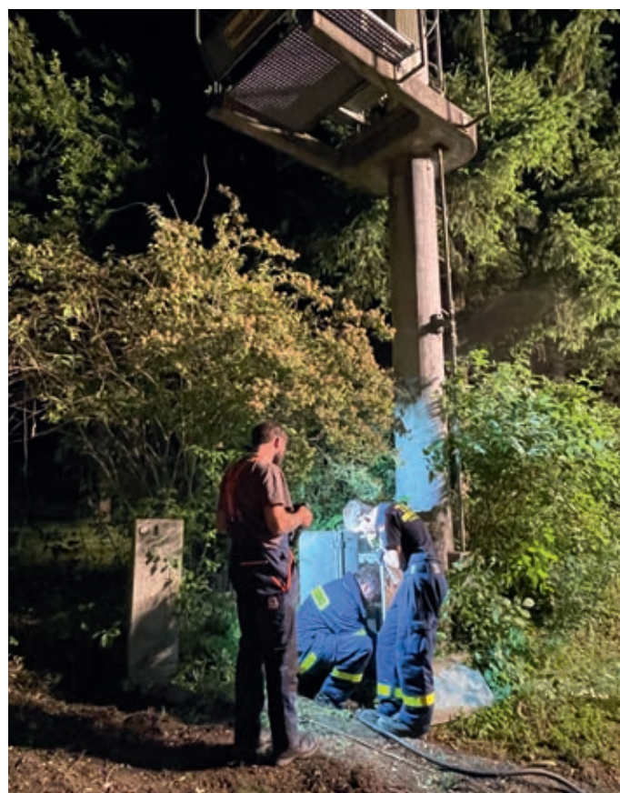
Vorbereitungsarbeiten an einer Netzunterverteilung durch THW und Stromversorger
