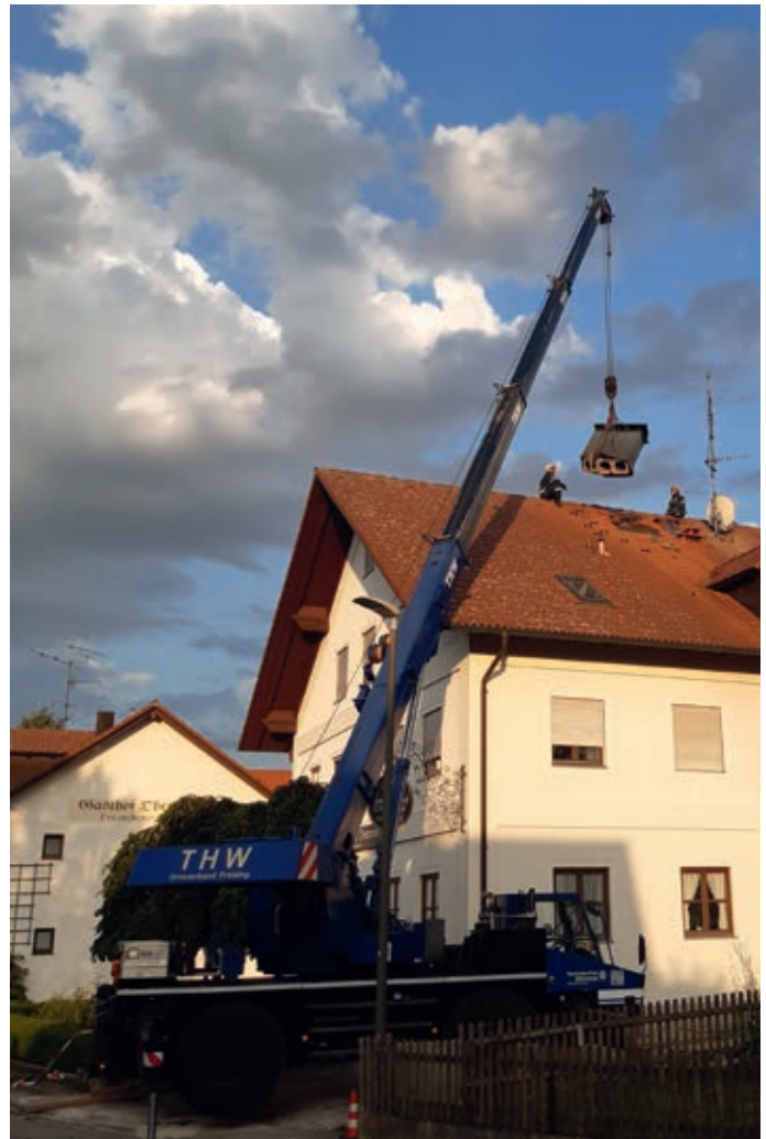
Bergung eines abgebrochenen Kamins mit dem Mobilkran des THW Freising
