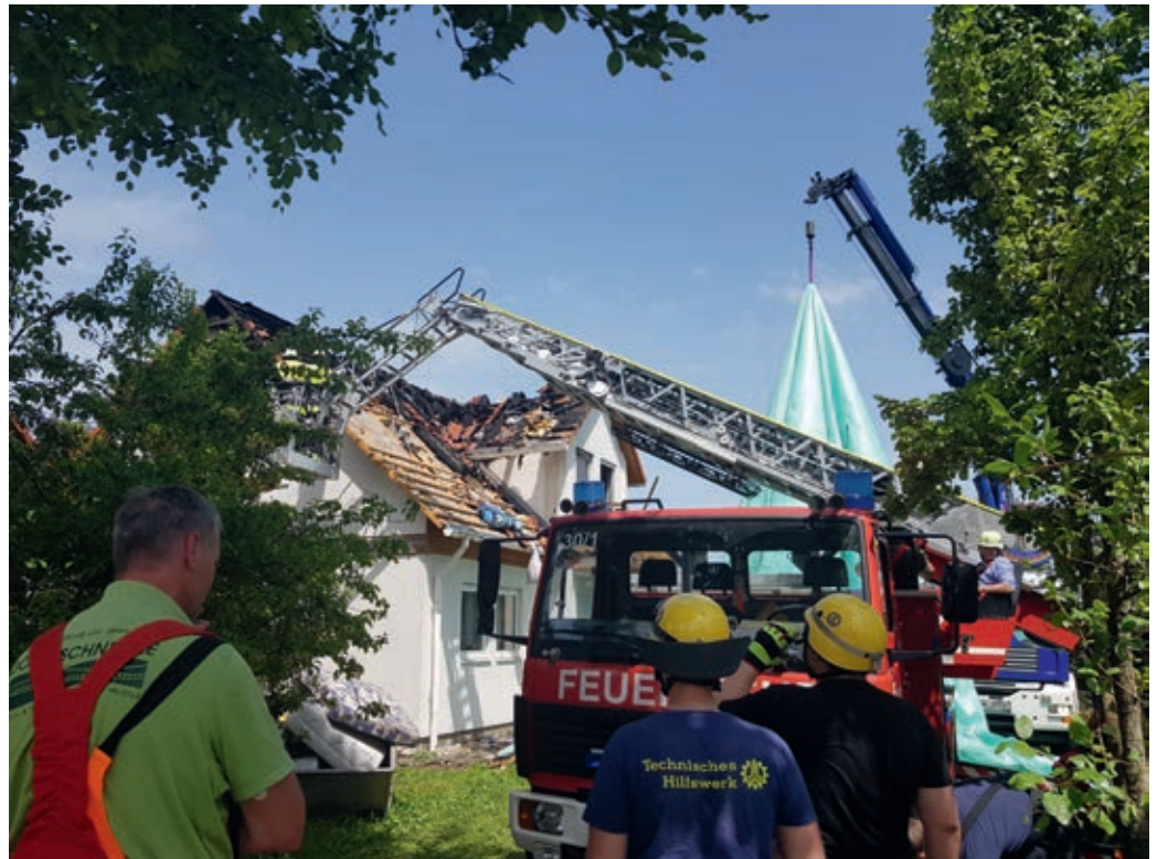
Nach dem Dachstuhlbrand in Pipinsried - das Notdach (im Hintergrund am Kran) wird vorbereitet.
