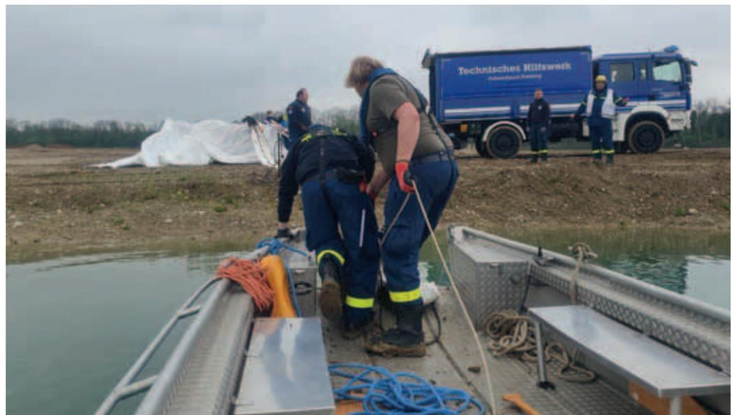
Installation der Tauchpumpen (je 2.500l/Min.) am Mehrzweckboot des THW Freising. Da der Grund der Wasserstelle, aus der gefördert werden musste völlig verschlammte, konnte durch die Nutzung des Boots als eine Art Boje für die Pumpen die Aufgabe kreativ und ohne Leistungseinbußen umgesetzt werden
