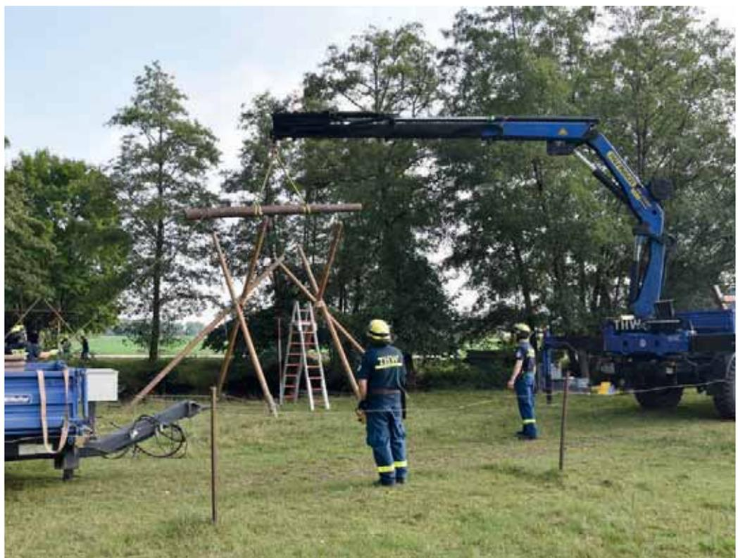
Mit Hilfe des Baiersdorfer Unimog-Krans wird zur Fertigstellung eines Stegportales ein Holm in die Gabeln der Böcke gehoben.
