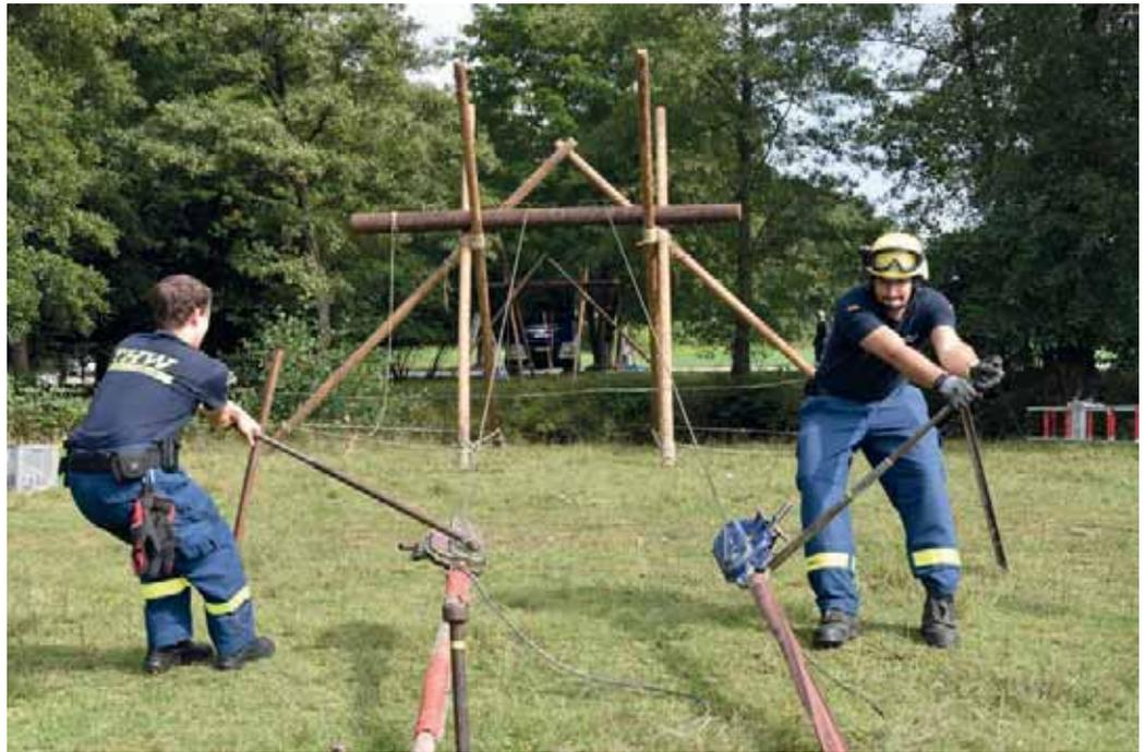
*Durch den Einsatz von zwei Zuggeräten spannen zwei Helfer die Stahlseile auf die benötigte Kraft vor.*
