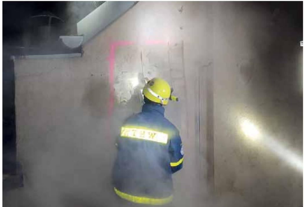
Zum Auffinden von Glutnestern wurden Sichtungsb Bohrungen und ein großer Wanddruchbruch für die Feuerwehr erstellt.
