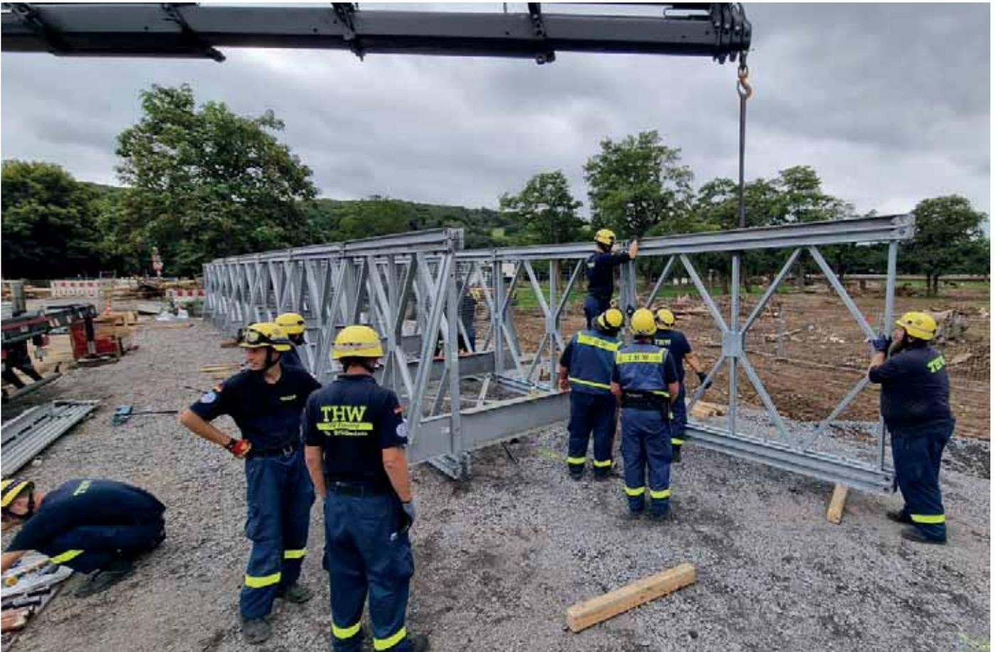
Die Montage der Brücke mit Hilfe des THW-Krans.
