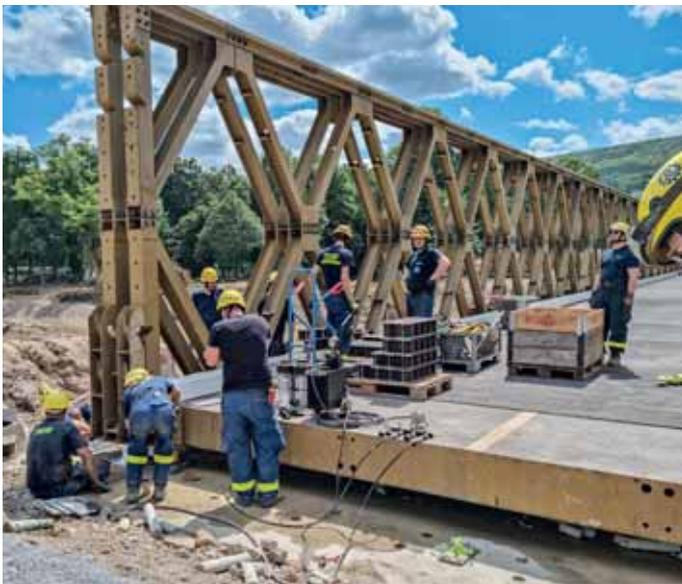
Millimeterarbeit beim Anheben und Absetzen der Brücke auf die Endlager.
