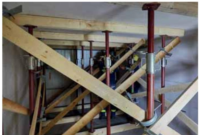
*Die von oben abgeleitete Kraft des EGS muss im darunterliegenden Stockwerk weiter in den Boden geführt werden. Hierzu werden Baustützen verbaut.*
