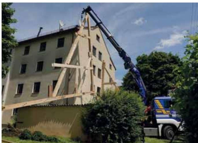
*Einheben einer kompletten Strebstütze nach „Freisinger Methode“*
