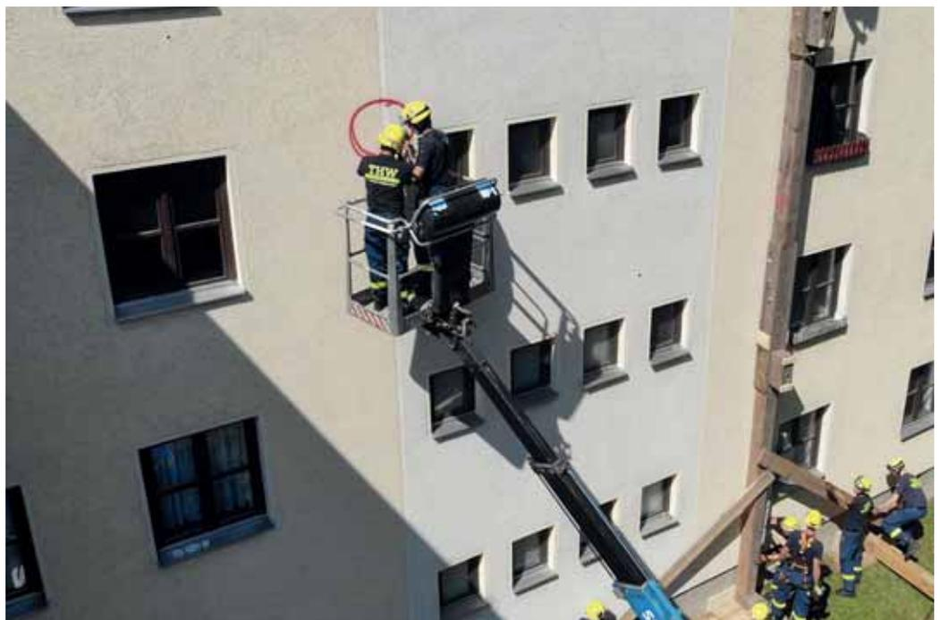
Das Anbringen eines „Rissmonitors“. Mit diesem Rissmonitor lassen sich bereits bestehende Risse im Gebäude überwachen.
