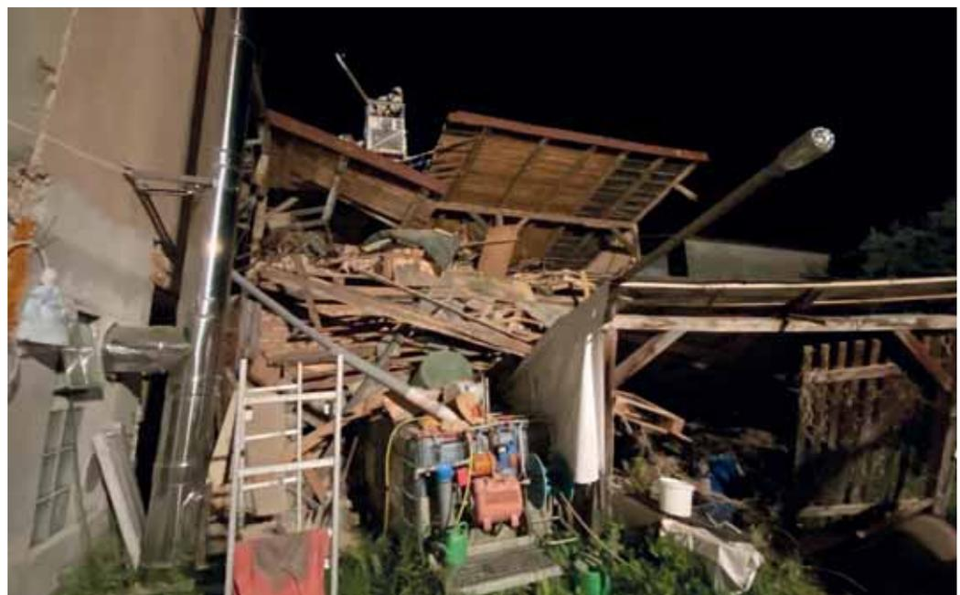
Das Dach muss nach dem Teileinsturz der Scheune entfernt werden.
