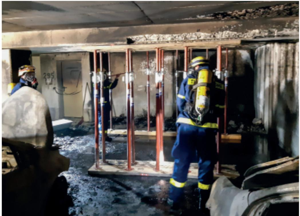
*Einbau der Deckenabstützung in der ausgebrannten Tiefgarage unter schwerem Atemschutz.*
