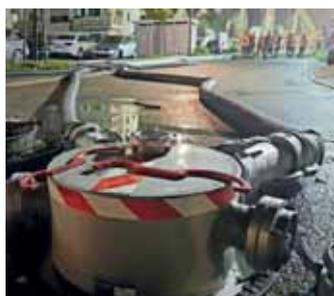
Dank der Schachteinlauftonne konnten über 14.000 l Wasser pro Minute gefahrlos über den Regenwasserkanal abgeführt werden.
