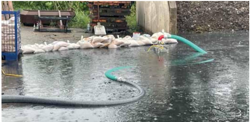
Dank der Sandsacksperrung kann das Löschwasser gesammelt und abgepumpt werden.
