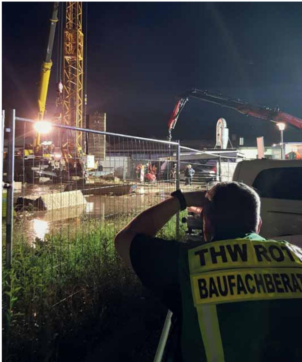
Während der gesamten Dauer des Einsatzes wurde die Lage des Baukrans mit dem Nivelliergerät überwacht.
