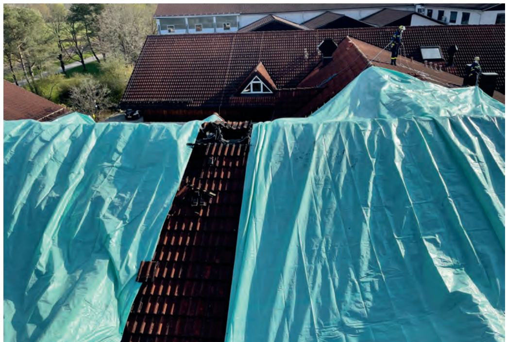
Der Gebäudeeigentümer und die Einsatzleitung trafen gemeinsam die Entscheidung, das beschädigte Dach des Impfzentrums mit zwei Notdächern einzudecken. Christian Zrock / THW München-Land
