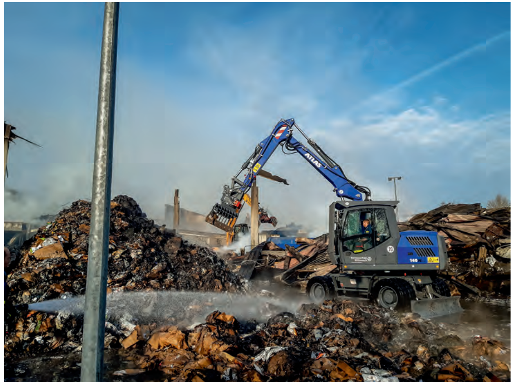
Der Radbagger des THW Ansbach ermöglicht Nachlöscharbeiten.
