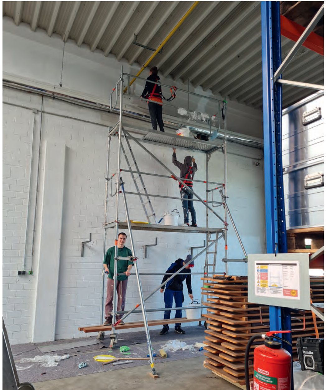
Ein Beispiel aus der vielfältigen Arbeit: Im THW Dillingen brauchte die Fahrzeughalle einen neuen Anstrich. Instandsetzungsarbeiten, die von Jana Guppenberger (oben), Moritz Gerkhardt (mitte), Marius Meinhardt (unten rechts) und Marius Wall (links) geleistet worden sind.
