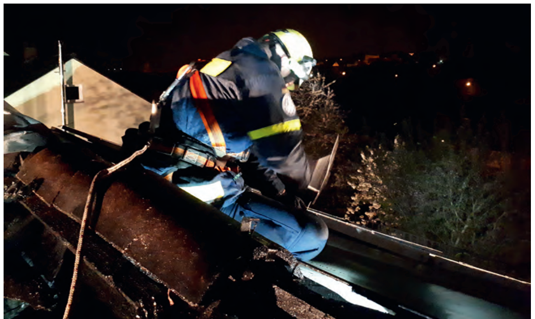
Der durch das Feuer zerstörte Dachstuhl wurde durch das THW mit Latten und Folienbahnen vor weiteren Witterungseinflüssen geschützt. Dabei wurde mit entsprechender Absturzsicherung gearbeitet.
