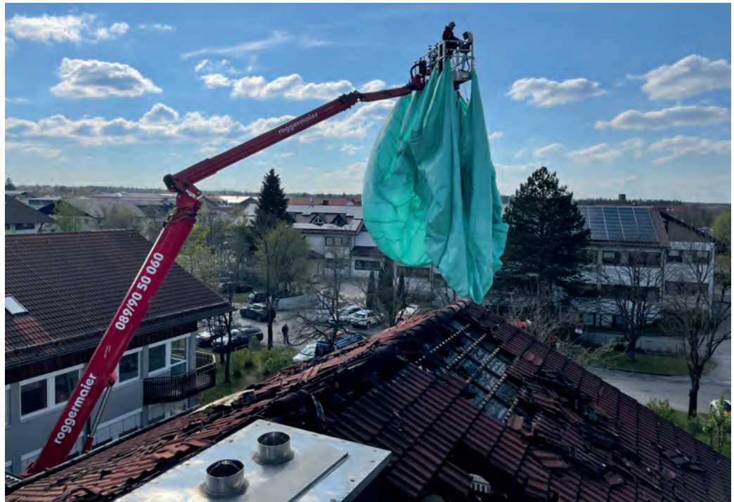
Eines der beiden Notdächer wird mit einem 46-m-Hubsteiger hochgehoben, um es auf dem beschädigten Dach abzulassen, wo es von den wartenden THW-Einsatzkräften befestigt wird. Christian Zrock / THW München-Land
