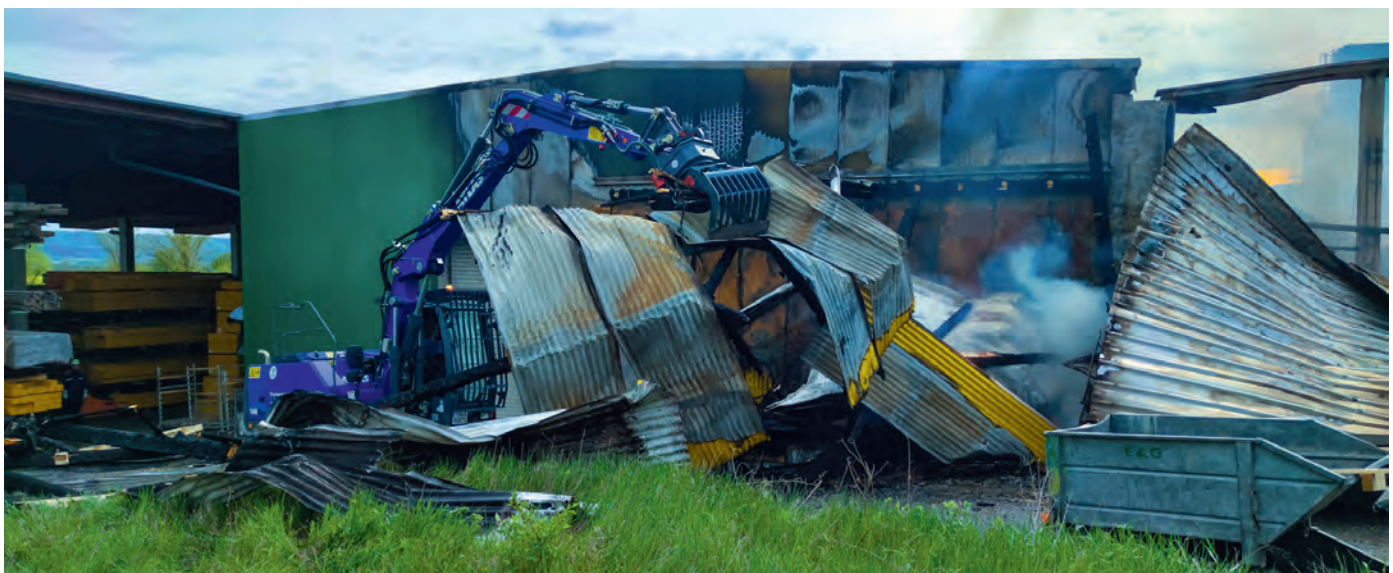
Der Abriss durch den Radbagger geht gezielt und sicher voran.
