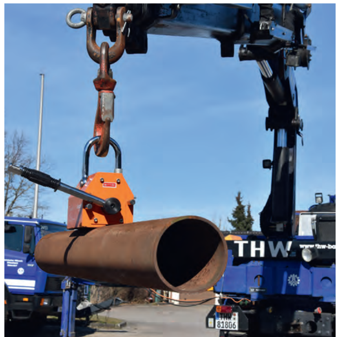
Anheben von Rundmaterial mittels Permanent-Lasthebemagnet
