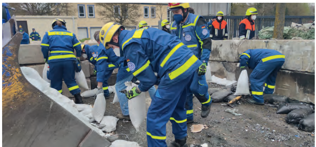
20.000 Sandsäcke werden auf 130 m Länge von den Einsatzkräften verbaut.
