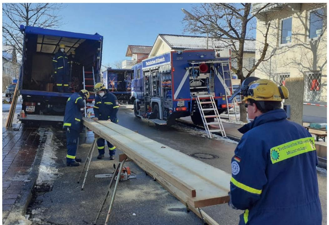
Unter ständiger Absturzsicherung wegen der bestehenden Einsturz- und Durchbruchgefahr konnten die THW-Einsatzkräfte den Dachstuhl mittels Holzbalken und Dachlatten herstellen. Unterstützt wurde das THW dabei von den Freiwilligen Feuerwehren (FFW) Sauerlach und Siegersbrunn, die unter anderem mit einer Drehleiter vor Ort waren.
