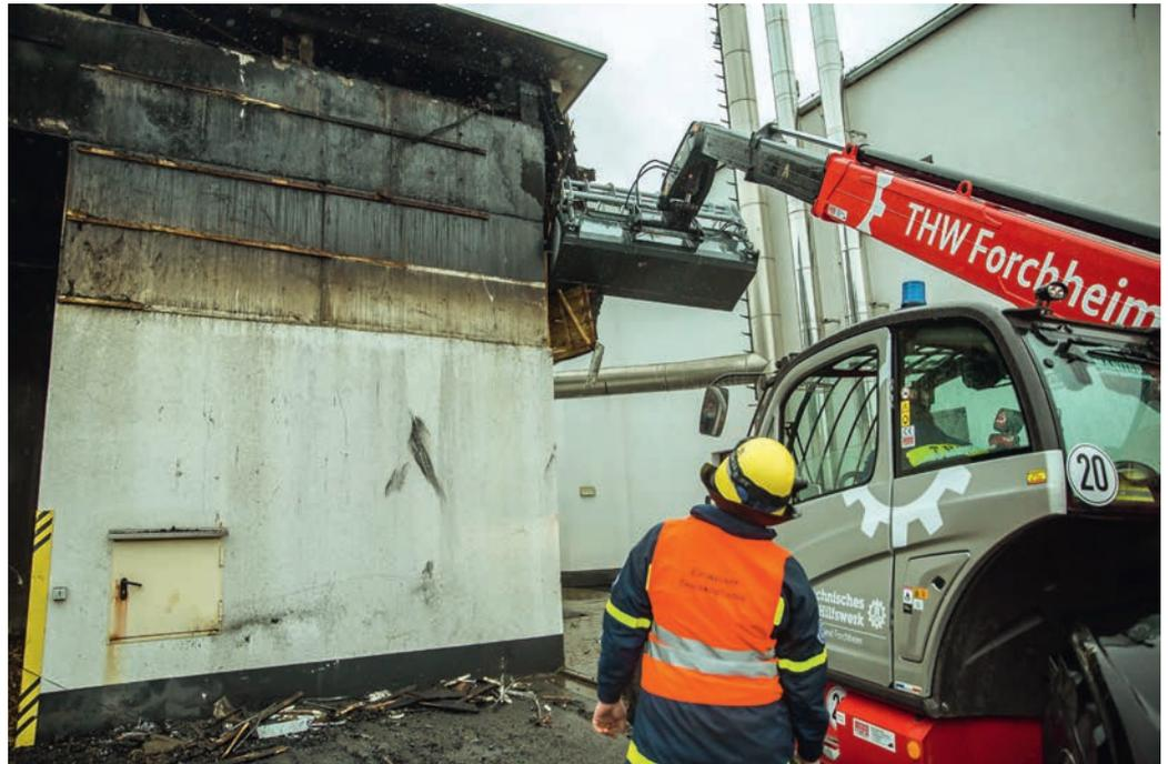
oben: Mittels Teleskoplader konnte die Fassade entfernt werden, um weitere Glutnester zu finden
