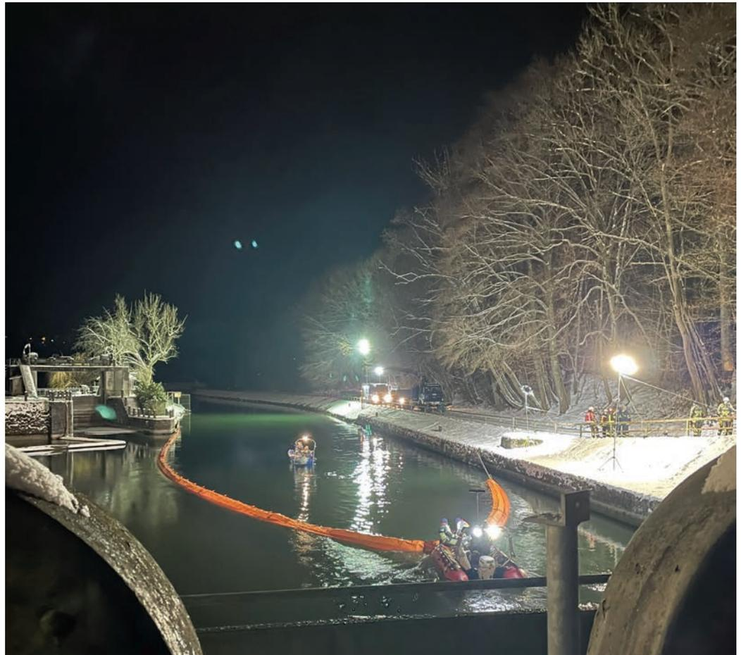
Die Ölsperre wurde nach dem Einlassen ins Wasser so am Ufer befestigt, dass ein Umweltschaden durch das ausgelaufene Hydrauliköl verhindert werden konnte.
