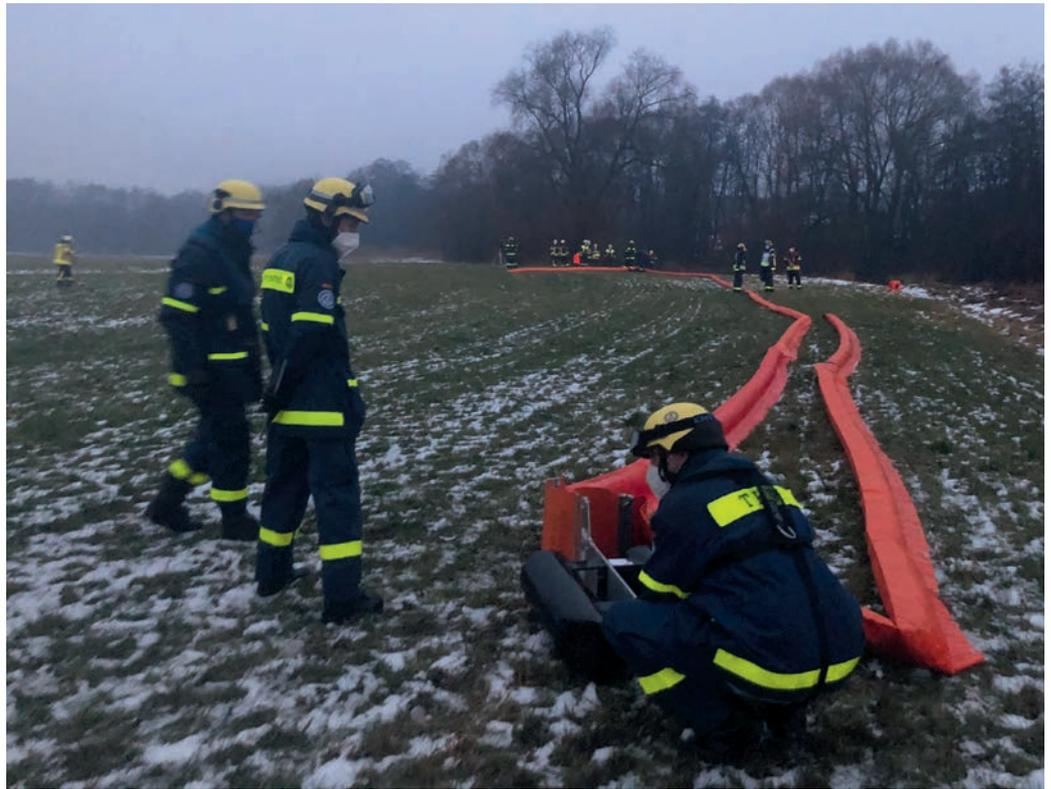
Die einzelnen Elemente werden an Land zusammengesetzt.
