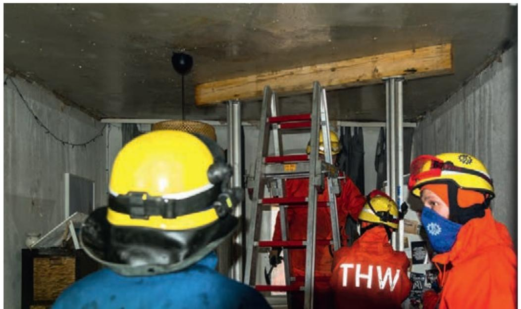
*Beim Abstützen der vor Löschwasser tropfenden Decken ist die Regenbekleidung von Vorteil.*
