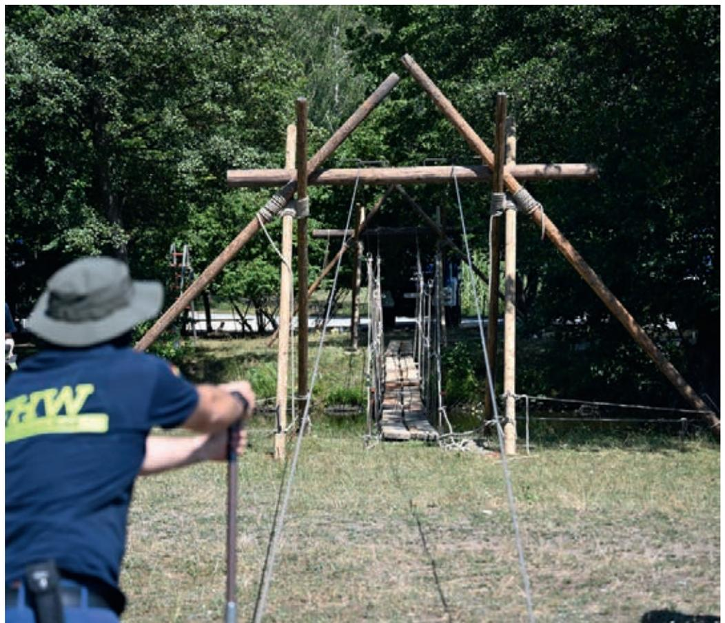
Zur Überprüfung des errichteten Hängesteges führt ein Helfer die Spannprobe durch.
