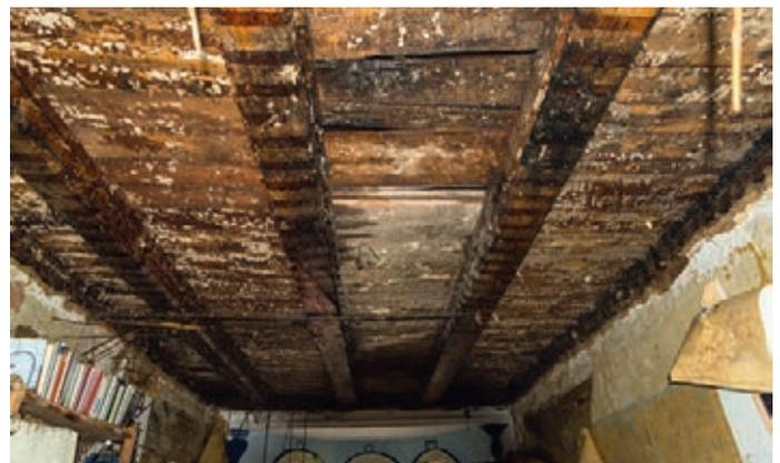
*Das Löschwasser tropft aus der offengelegten Decke des 3. OG.*
