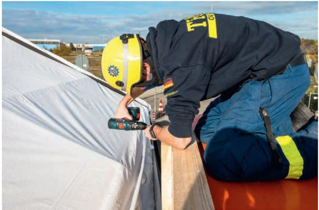
*Die OSB-Platten wurden an den angebrachten Latten verschraubt.*
