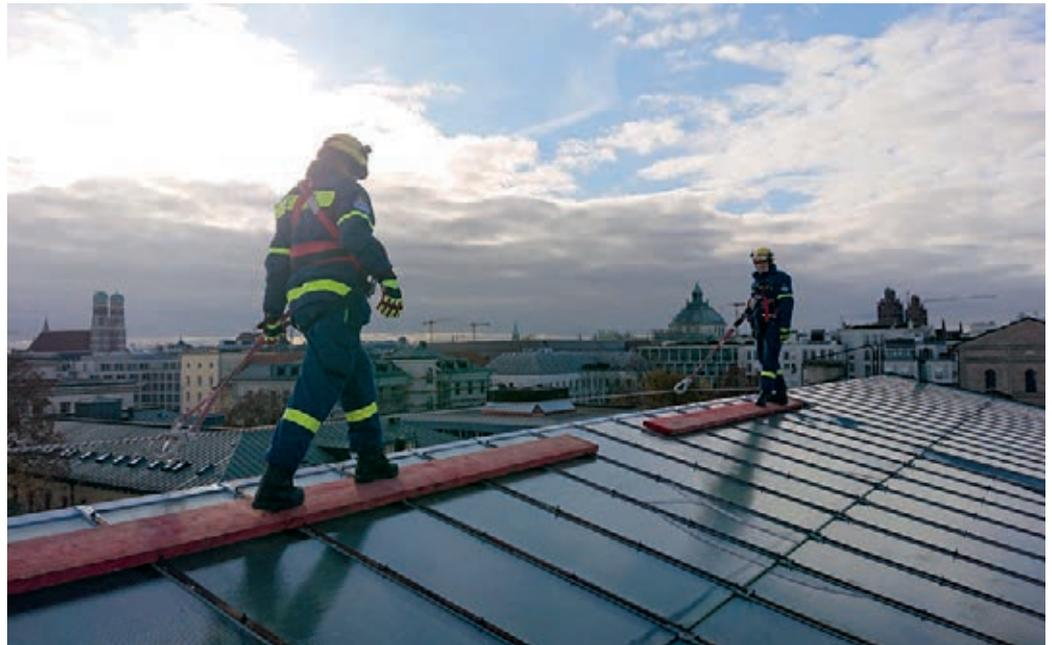
stellen gesichert und lose Teile entfernt. Dabei war große Umsicht nötig, um nicht durch die Glasplatten zu brechen oder zusätzliche Schäden zu verursachen. Anschließend wurde mit Hilfe des Baukrans das Notdach ausgelegt und durch Leinen, Bohlen und fast 300 Sandsäcke gesichert.
