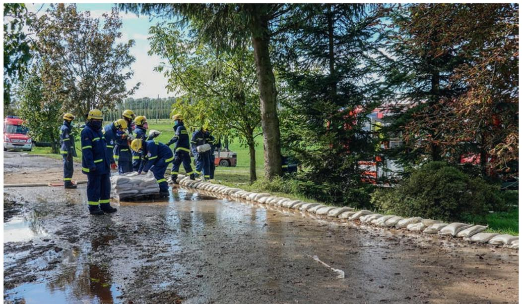
*Sandsackbarriere hält kontaminiertes Löschwasser zurück.*
