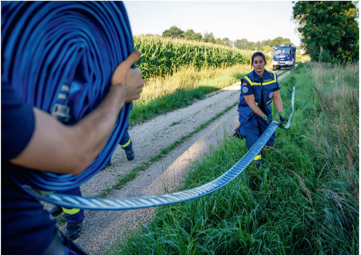
THW-Einsatzkräfte beim Verlegen der Trinkwasserleitung für die Überbrückung des Notfalls für den Weiler Einsassen.
