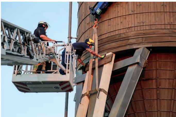
von Streusand und fasst bis zu 60 Tonnen. Aufgebaut ist es auf Stützen, so dass LKWs es unterfahren können.
