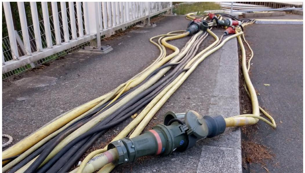
*Hunderte von Metern Kabel und unzählige Verteiler waren notwendig um die Tauchpumpen im See mit Energie zu versorgen*
