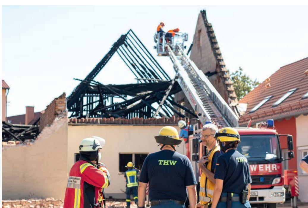
Bei den anderen beiden Giebeln war die Sachlage nicht ganz so deutlich. Aufgrund der Höhe der Giebel wurde der Ladekran des THW Nürnberg nachalarmiert. Eine Abstützung war nach gründlichen Überlegungen nicht möglich, da der Untergrund durch eine Güllegrube
