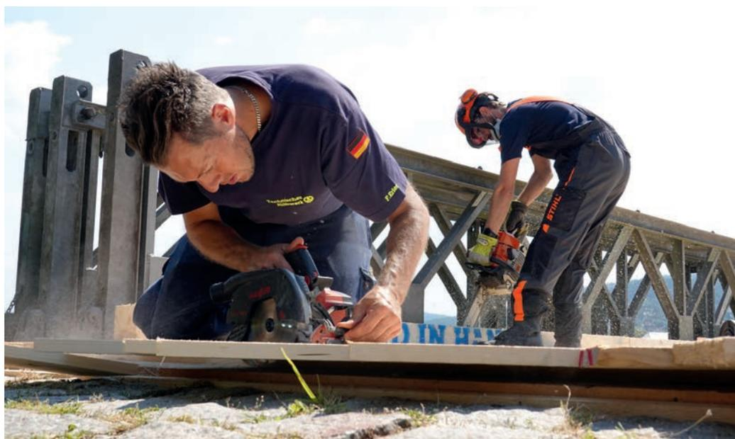
Roding und Freising die rund 35 Tonnen schwere Stahlkonstruktion der Behelfsbrücke aus bis zu 300 kg schweren Bauteilen.
