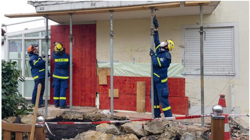
*Die Stützen werden nochmals überprüft. Helfer verbarrikadierten die beschädigte Wand.*
