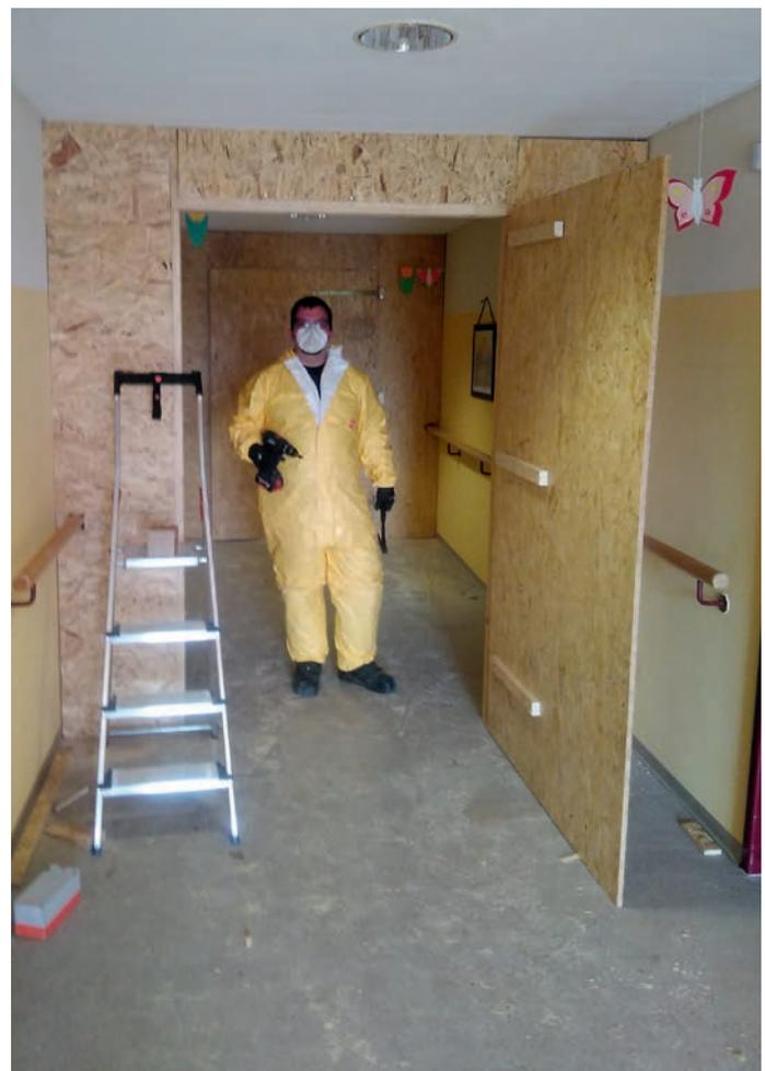
Aus Holz-Verbundplatten errichteten die THW-Einsatzkräfte in drei Seniorenheime spezielle Schleusen zum Infektionsschutz. Für die Arbeiten wurden FFP2-Masken getragen.
