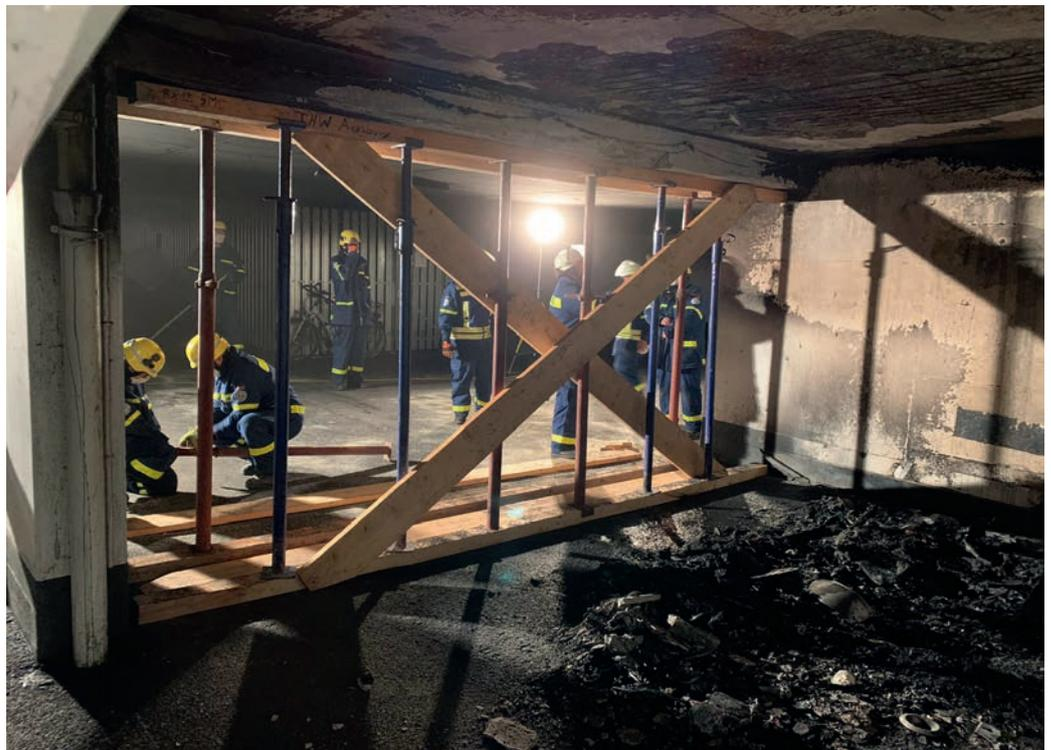
*Massive Schäden waren nach dem Feuer in der Tiefgarage entstanden - das THW stützte tragende Bereiche ab.*
