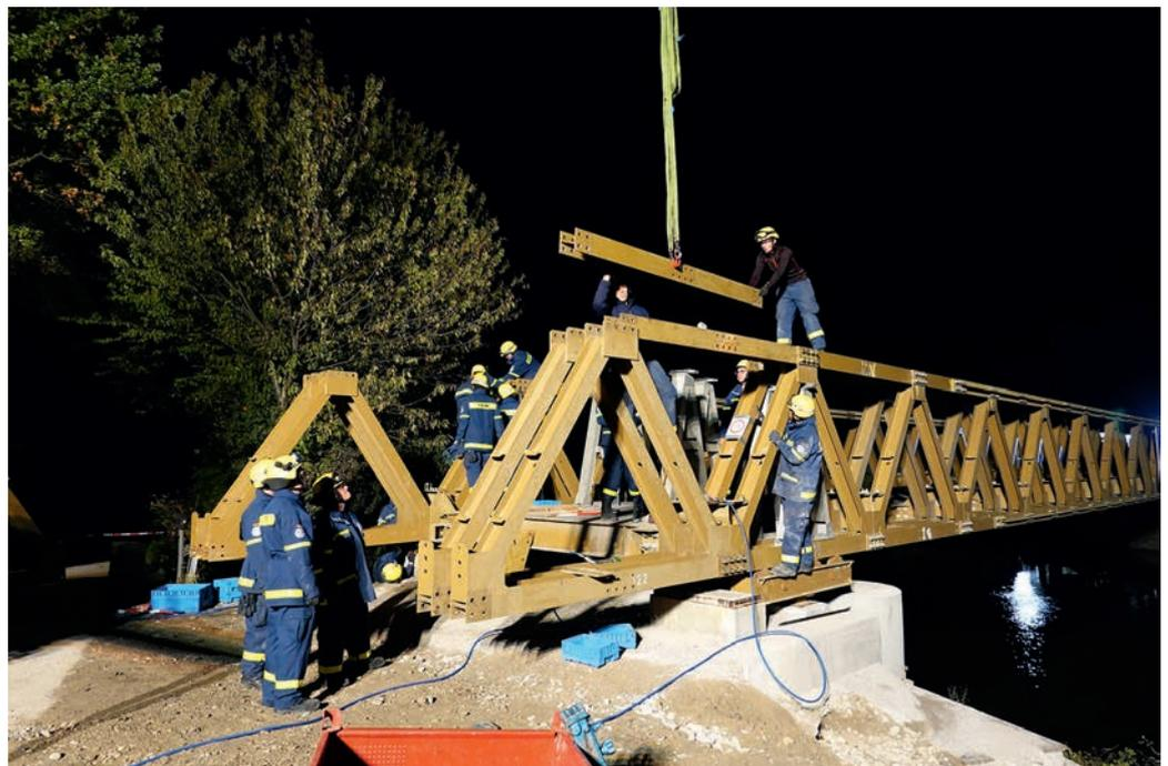
Mit dem Vorbauschnabel – einer Montagehilfe aus Brückenelementen für den Vorschub – wurden 120 Tonnen Material bewegt, montiert und wieder demontiert, was Helferinnen und Helfer aus 3 Ortsverbänden bewerkstelligten. Insgesamt wendeten die eingesetzten 300 Einsatzkräfte dabei gut 7.200
