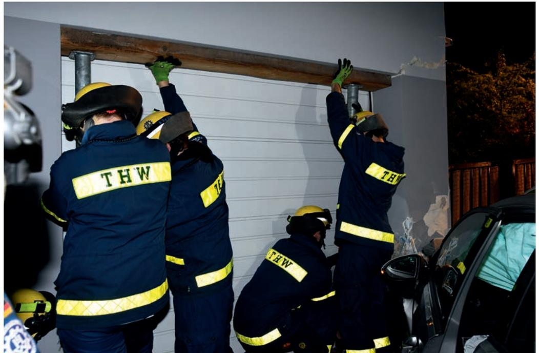
Baiersdorfer Helferinnen und Helfer stabilisieren die beschädigte Garage mittels Balken und Baustützen.
