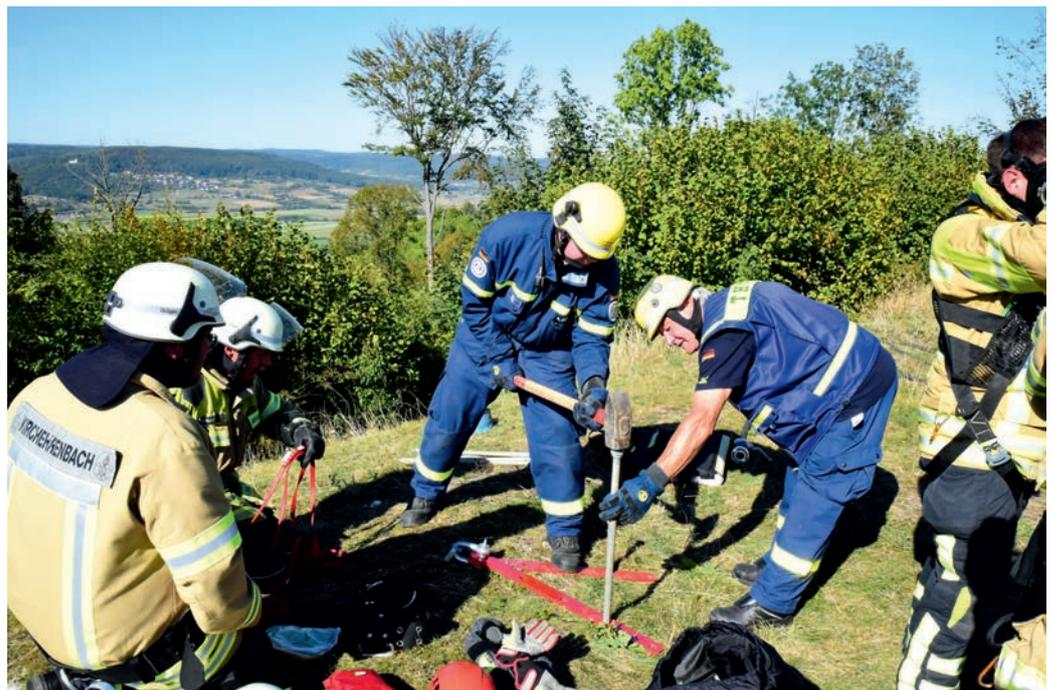
Für die Sicherung des verunfallten Traktorgespans wurde eine Verankerung in den Boden geschlagen.
