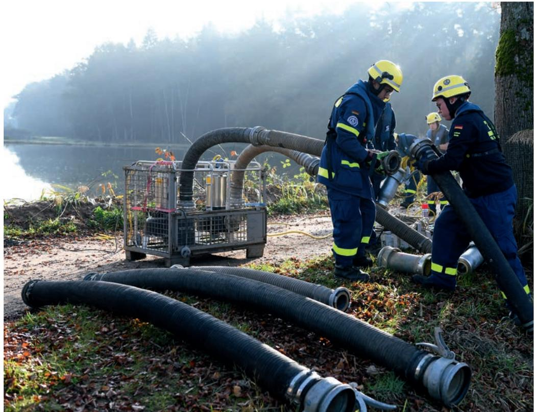
Forchheimer THWler kuppeln formstabile Schläuche an die Tauchpumpen, bevor diese zu Wasser gelassen werden.
