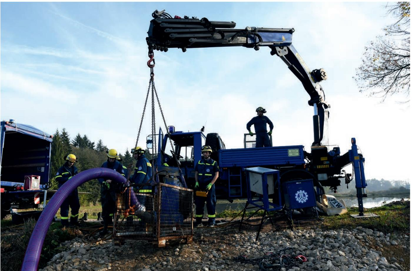
Abladen der Pumpen und des Elektromaterials mittels Baidersdorfer Unimog-Kran.
