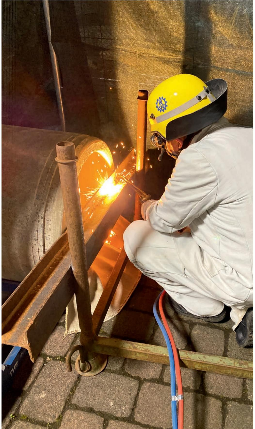
Stahlträger durchtrennen mit dem Brennschneidgerät
