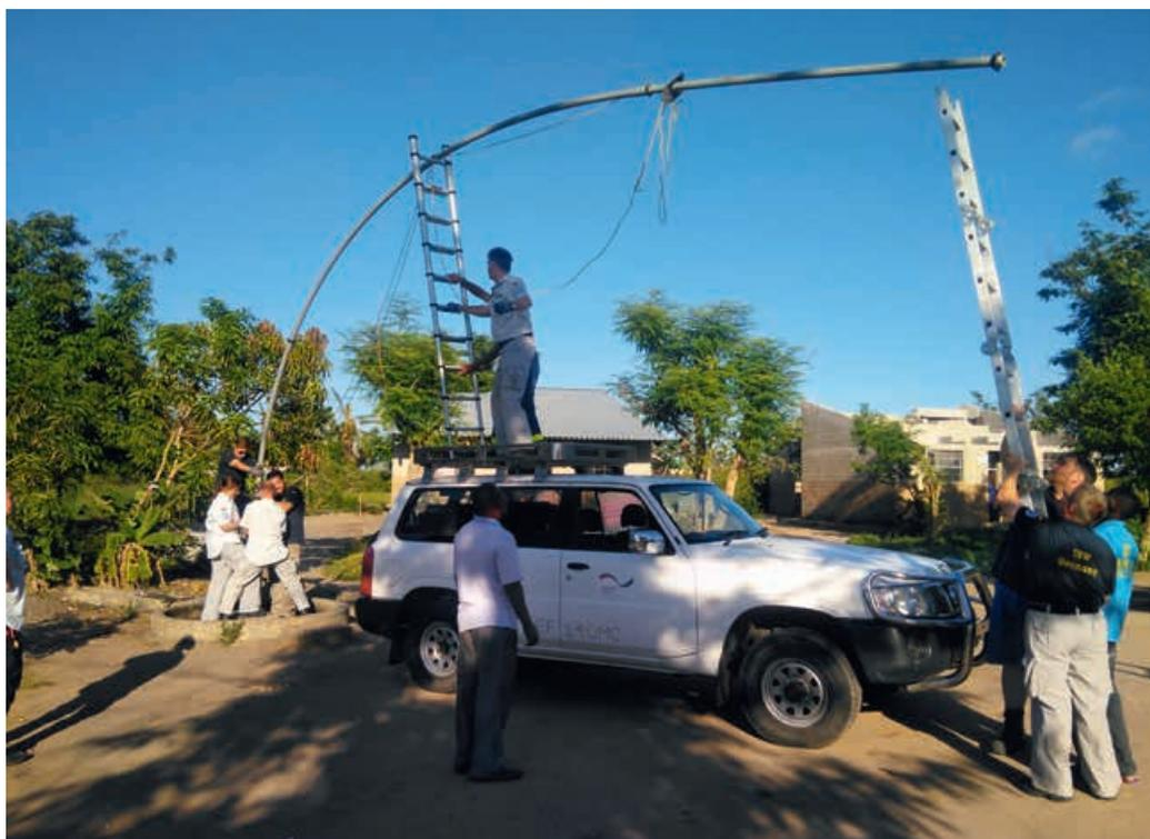
*Ein Brunnenrohr – ca. 20 Meter lang – wird vorsichtig ausgebaut. Der Grundwasserspiegel liegt relativ hoch, der Grundwasserbereich geht jedoch ziemlich tief. Die Brunnen haben dort eine Tiefe von 20 - 30 Metern.*
