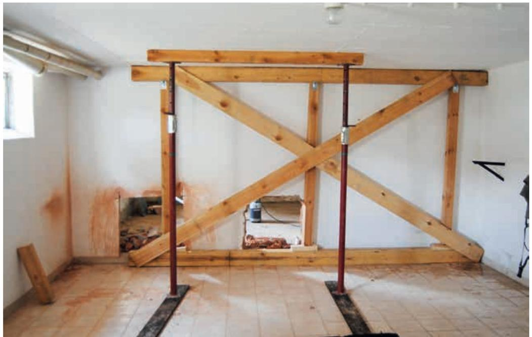
Das sogenannte Schwelljoch stützt die Deckenkonstruktion und ermöglicht eine sichere Erstellung von Wanddurchbrüchen.
