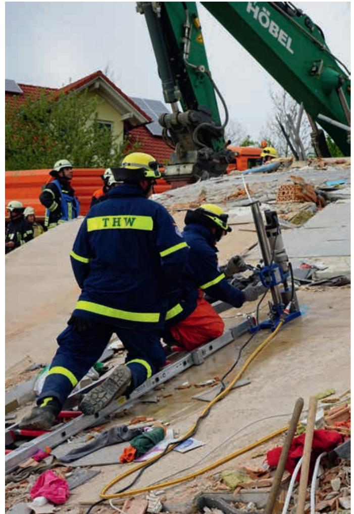
*Kernbohrgerät - schafft Zugang für Endoskopkameras, hier durch eine Geschossdecke, um Einblick in evtl. darunter entstandene Hohlräume zu gewinnen, in denen sich Menschen befinden könnten.*
