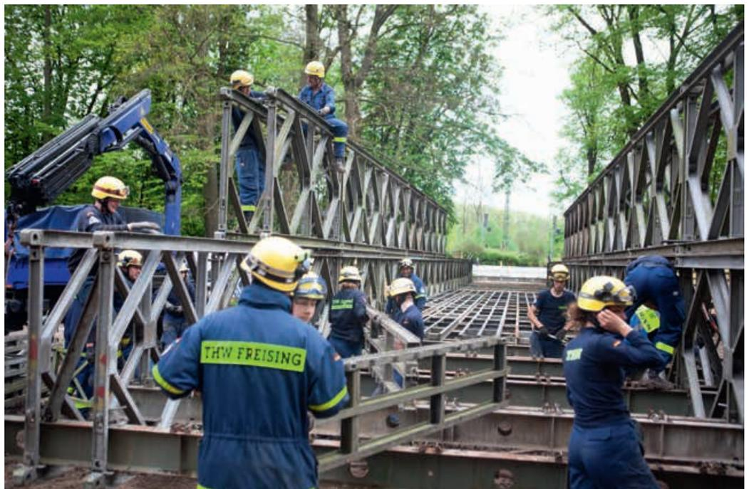
Um die benötigte Tragfähigkeit für das Befahren mit LKWs zu ermöglichen, ist bei dieser Stützweite die Bauart zweiwandig-zweistöckig erforderlich. So ist sogar das geplante Befahren mit einem 95 Tonnen schweren Mobilkran möglich.
