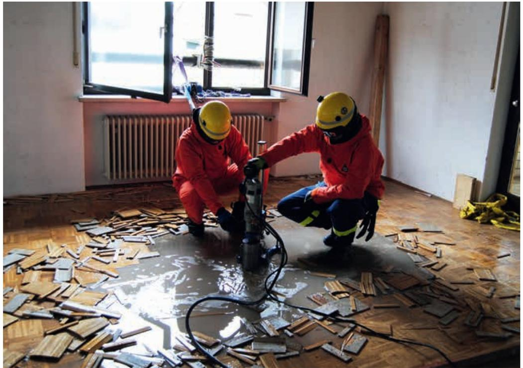
Mithilfe des Kernbohrgerätes erstellten die Einsatzkräfte Öffnungen in Boden und Wänden.
