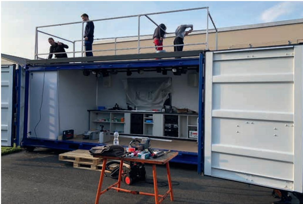
Der Innenausbau geht in die Endphase: Die Kameraden auf dem Container montieren gerade den Klapprahmen an dem die Dachbanner angebracht werden. Im Inneren sind die Technikschränke bereits eingeräumt
