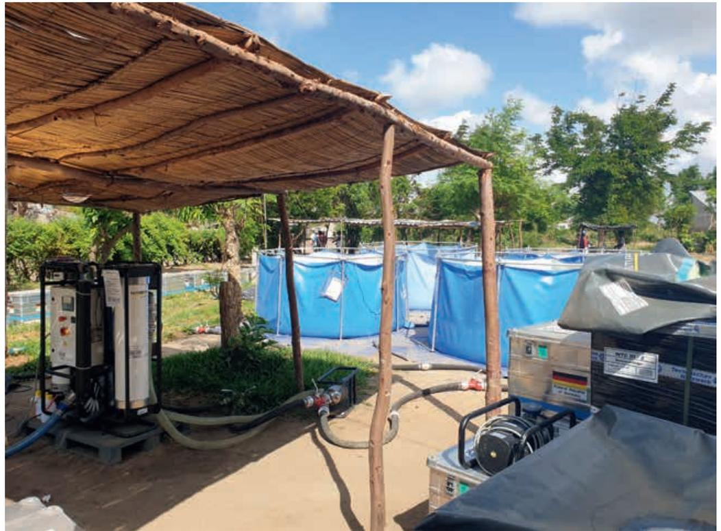
Links im Bild der Filter, quasi das Herzstück der Trinkwasseraufbereitungsanlage. Die blauen Behälter im Hintergrund sind Rohwasserbehälter. Die Aufnahme zeigt nur einen Teil der Wasseraufbereitungseinrichtungen.
