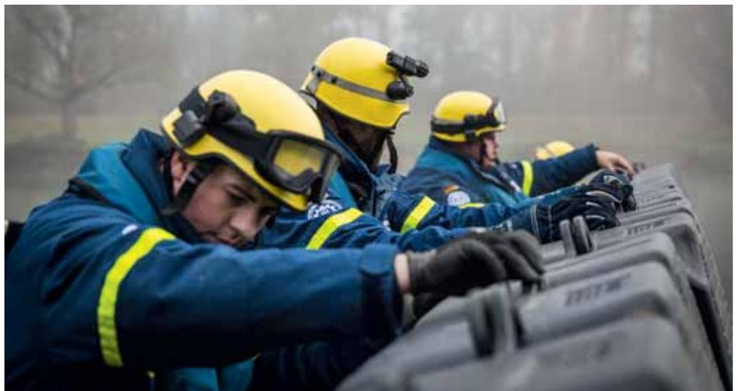
*Mit den JetFloat-Auftriebskörpern wurde durch das THW eine Rampe gebaut, über die das Floß später zu Wasser gelassen werden sollte.*
