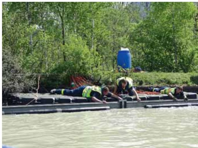
Mit Hilfe dieser quer über den Inn eingebrachten Ölsperre können im Einsatzfall große Mengen Öl abgefangen und in den Hafen geleitet werden, um dort mit speziellen Separationsgeräten das Öl aus dem Wasser filtrieren zu können.
