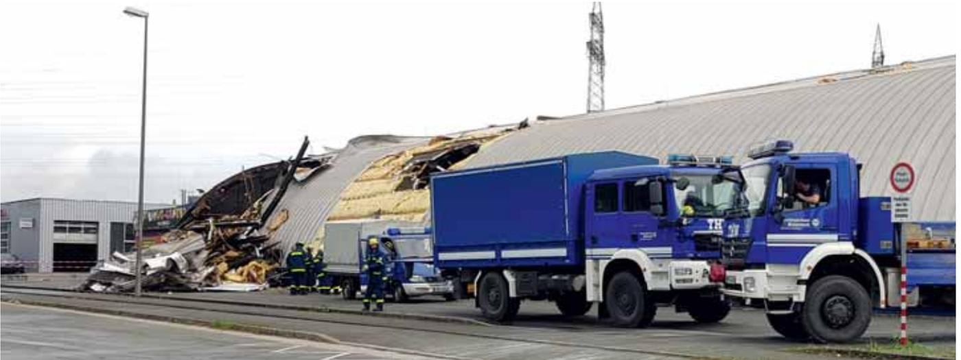
Der THW-Ortsverband Kulmbach beginnt zusammen mit dem THW-Ortsverband das Gebäude zu sichern. Öffnungen werden mit Holzplatten verschlossen und das Gelände vollständig mit Bauzaun umzäunt.
