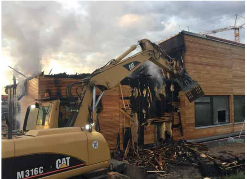
Mit dem Greifer am Bagger wurde die Außenverkleidung und die Installationsebene für die Löscharbeiten geöffnet.
