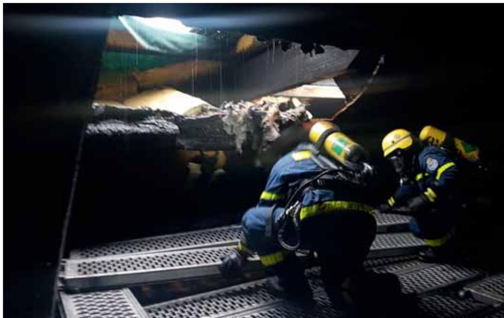
*Durch die starke Hitzeentwicklung im Gebäude und Löschwasser ist ein Teil des Bodens nur bedingt begehbar. Um weiter im Gebäude arbeiten zu können, wurden im Auftrag der Feuerwehr Gerüstböden verlegt.*
