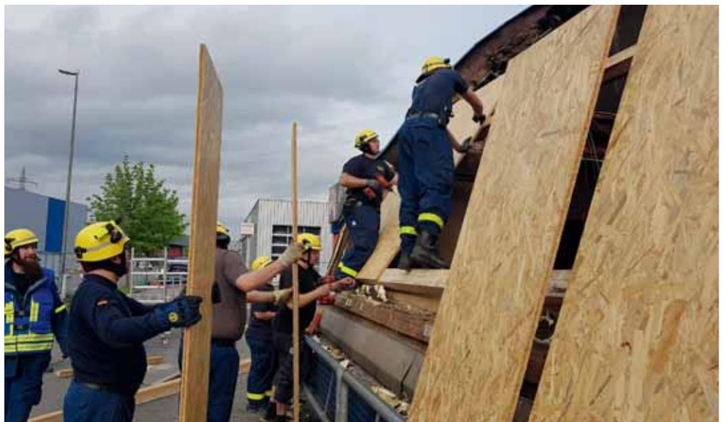
Um ein unberechtigtes Eindringen in das Gebäude zu verhindern, hat die Polizei das THW beauftragt, alle Öffnungen am Gebäude zu verschließen. Hier wurde zunächst eine Holzunterkonstruktion erstellt, auf der Platten verschraubt wurden.
