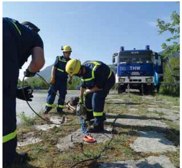
*Bild oben rechts: Erstellung des zweiten Fixpunktes. Mit der Seilwinde des GWK wird das Stahlseil quer über den Inn gespannt.*
