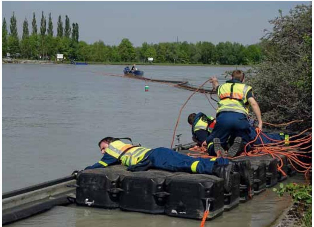
*Die Ölsperren werden am gespannten Stahlseil befestigt und mit dem Boot über den Inn gezogen.*
