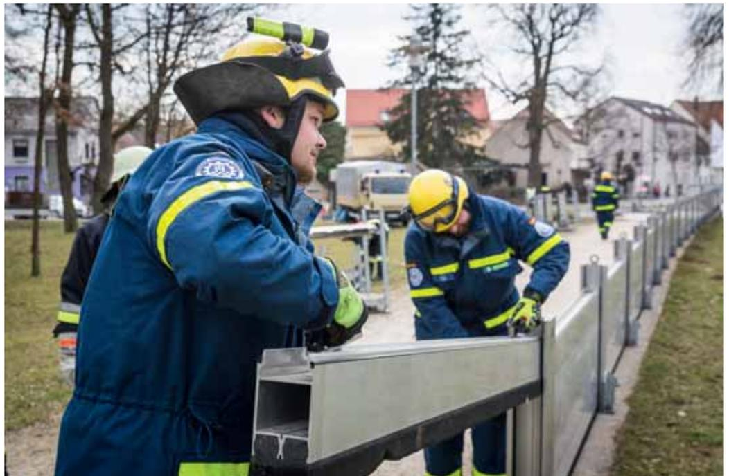
Zwei Helfer beim Einsetzen der Aluminiumbalken.
