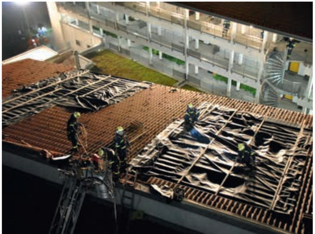
Am späten Vormittag des Neujahrstages wurde der Fachberater des THW zur Unterstützung alarmiert, da die Statik des Dachstuhls unklar war. Der Baufachberater des THW-Ortsverbandes Weilheim beurteilte die Statik des Gebäudes weiterhin als intakt, sodass keine Abstützmaßnahmen ergriffen wurden.
