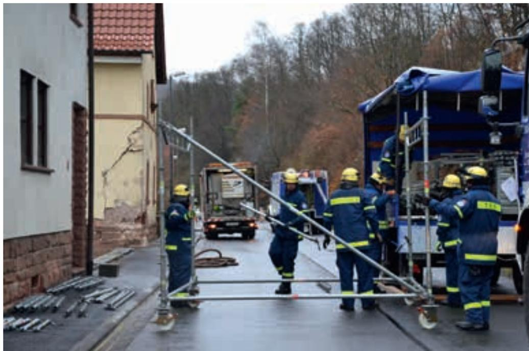
aus dem THW-Einsatzgerüstsystem. Im Inneren wurde die straßenseitige Giebelwand mit Gurthölzern verspannt, um das Herausfallen der Wand zu
