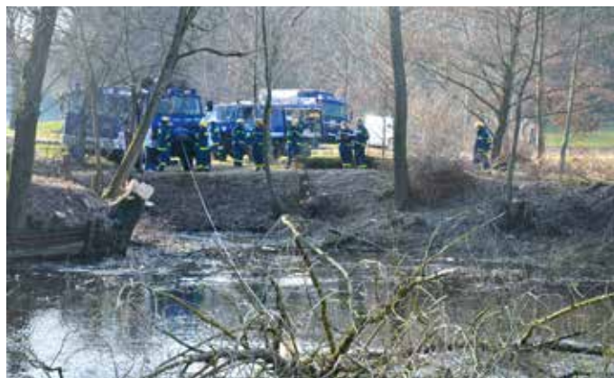
Durch die 80 m lange Seilwinde des Unimogs können sogar weit entfernte Baumstämme aus dem Weiher gezogen werden.
