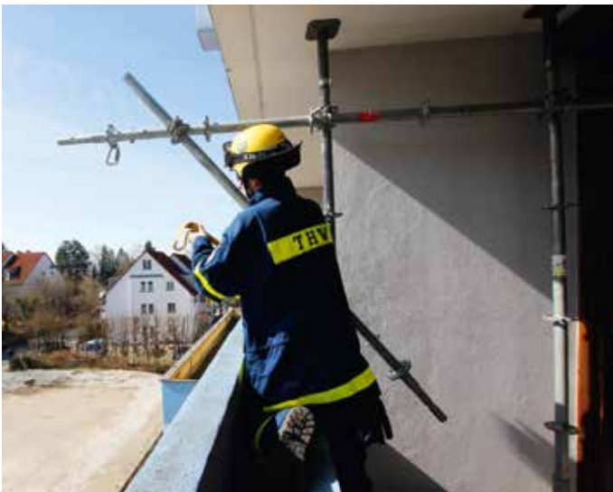
Mit dem Einsatzgerüstsystem wird ein Einspannausleger als Fixpunkt für die Abseilübung vorbereitet.
