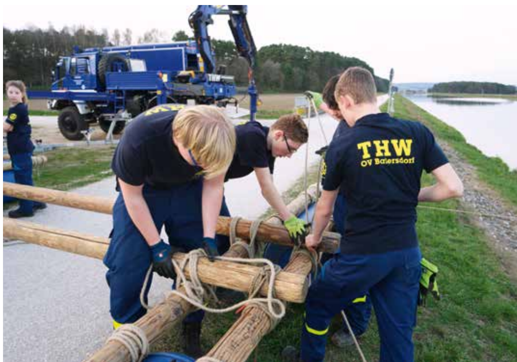
An Land fertigten die Junghelferinnen und Junghelfer die Schwimmer an.
