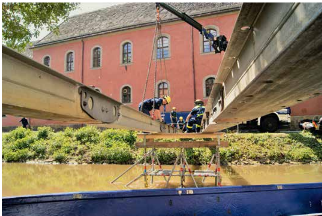
Das Fahrenoberbau-Material wurde mittels Kran auf den Stützturm gesetzt und bildete den Untergrund für die Gehwegplatten.
