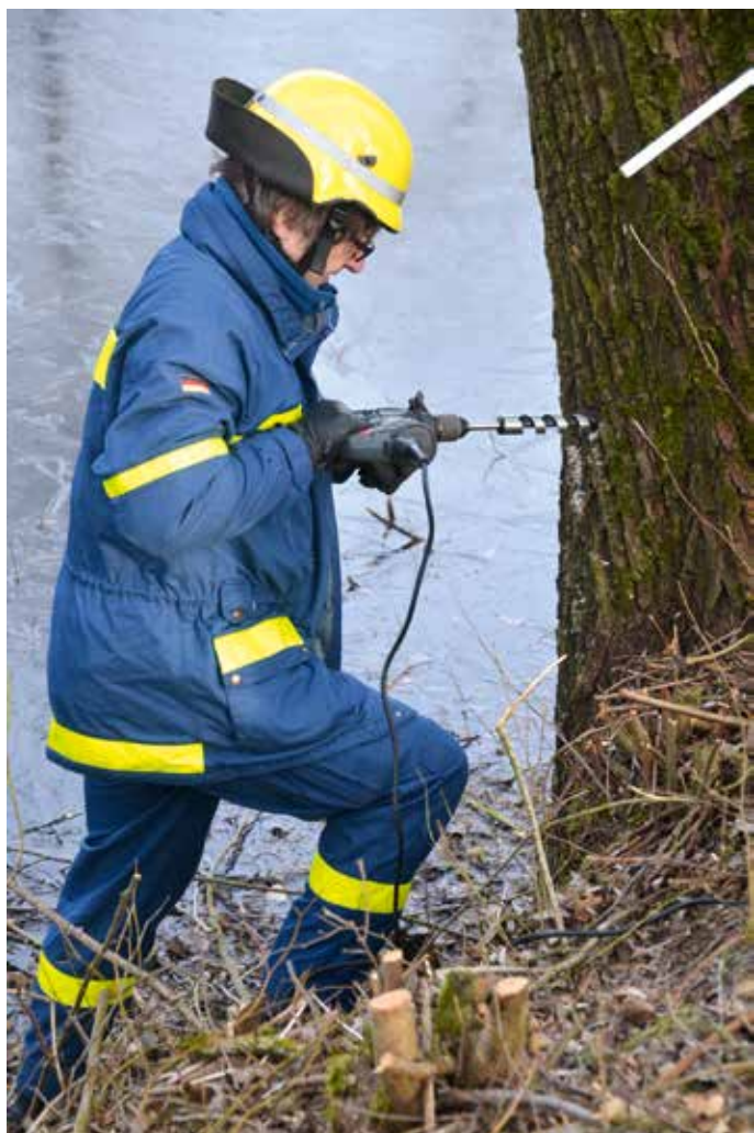
Durch Bohren der Sprenglöcher bereitet ein Baiersdorfer Helfer die Baumsprengung vor.
