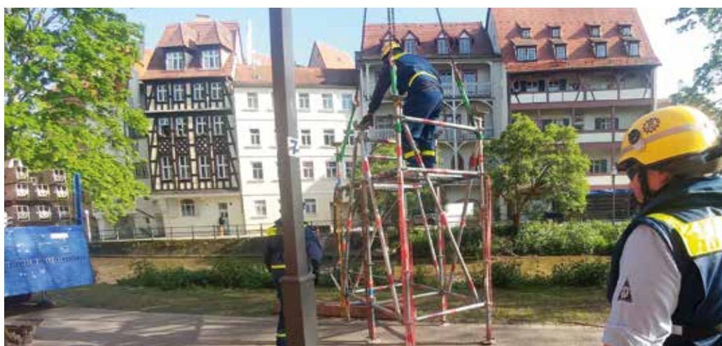
Der EGS-Turm wurde an Land zusammengebaut und später als Stützturm im Gewässer aufgestellt.
