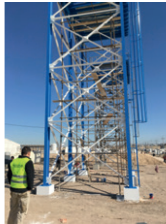
Bauwerke in der Wüste, die der Wasserversorgung dienen.
