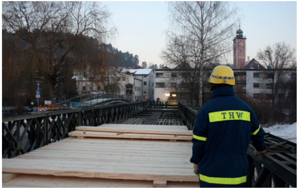
30 Meter und 30 Tonnen: Eichstätt neue Brücke über die Altmühl war notwendig geworden, weil ein stark frequen- tierter Steg am Zugang zur Altstadt wegen Baumängeln gesperrt werden musste.
