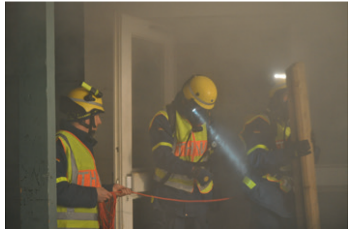
Helfer des THW Rosenheim mit Atemschutz beim Sichern des einsturzgefährdeten Kellerbereiches.
