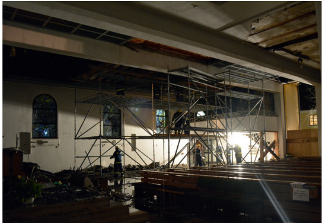
Sicherungstürme: Aus Teilen des Einsatzgerüstsystems errichteten die Freiwilligen des Technischen Hilfswerks aus Eichstätt ein Schutzdach.
