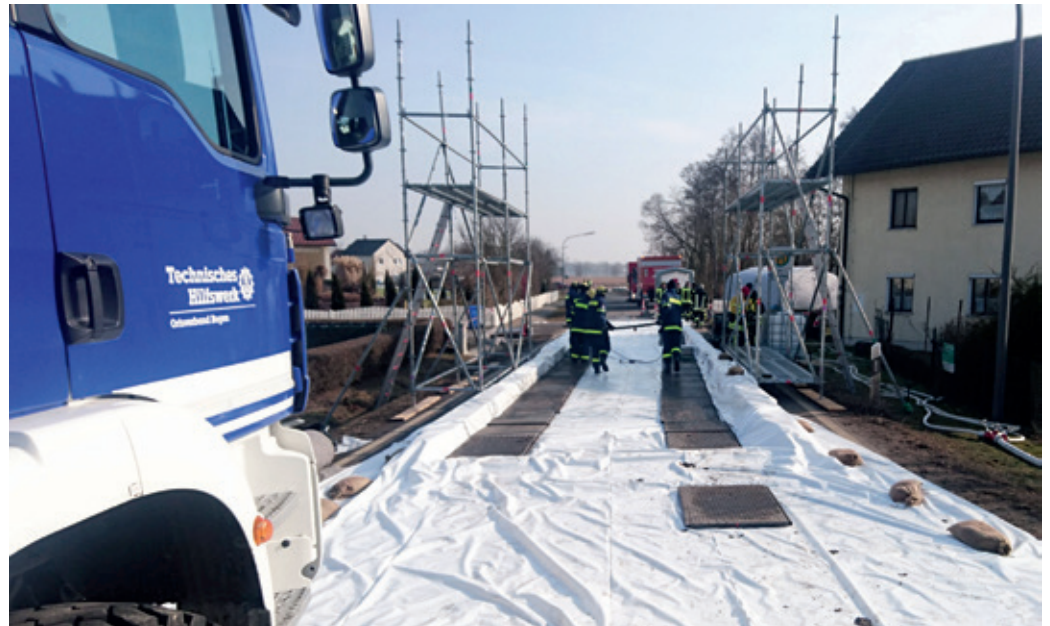
Zusammen mit weiteren Einsatzkräften von THW und Feuerwehr errichteten die Bogener THW-Helfer/innen eine Dekontaminationsschleuse zur Desinfizierung eventuell kontaminierter Fahrzeuge.
