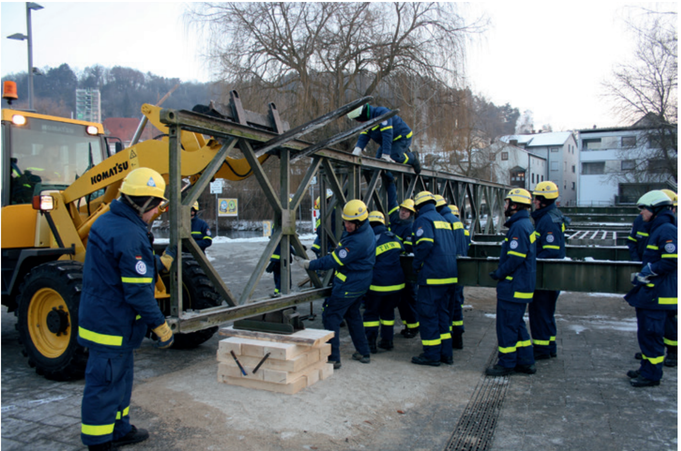
Vor allen Dingen in Handarbeit, nur ab und an unterstützt von zwei Gabelstaplern, errichtete das THW die Brücke aus Bailey-Elementen.
