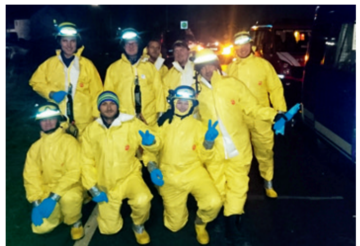
Wegen des starken Desinfektionsmittels mussten die Abbauarbeiten der EGS-Türme in Schutzanzügen erfolgen.
