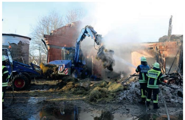
*Bagger holt Heu und Gebäudeteile zum Ablöschen durch die Feuerwehr aus dem Gebäude. Abtransport mit dem kleinen Radlader.*
