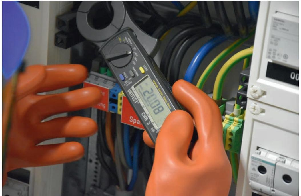
Strommessung am stationären Stromverteiler durch Helferinnen und Helfer.
