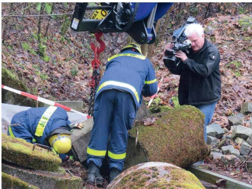
Die Betonrohre werden am Teleskladerarm befestigt. So können sie angehoben und damit der Weg für die Helfer freigeräumt werden.
