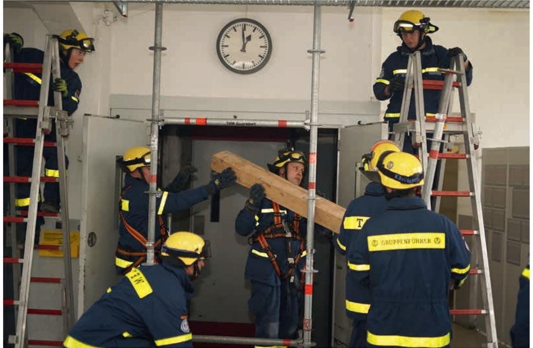
Hand in Hand bauen die THWler aus Baiersdorf, Nürnberg und Rothenburg einen Anschlagpunkt mittels Einsatzgerüstsystem (EGS) vor den Schachttüren auf.
