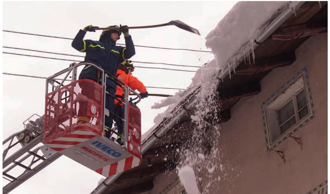
*Schneemassen werden vorsichtig von der Drehleiter aus vom Dachüberstand entfernt.*
